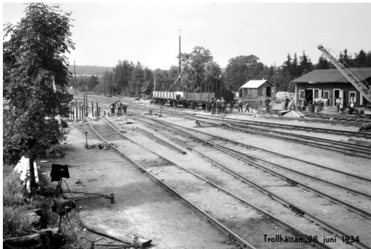
Kungsporten byggs. Foto 28 juni 1934.
