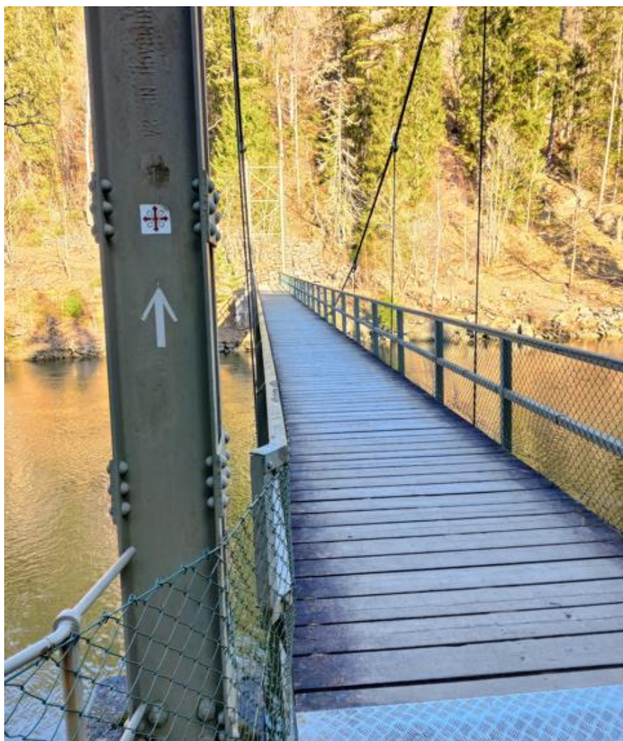
Figur 12. Hängbron, med vy från Åker mot den västra sidan av älven. Bron används som en passage för till exempel Pilgrimsleden och kommer inte att påverkas av slussarbetet.
