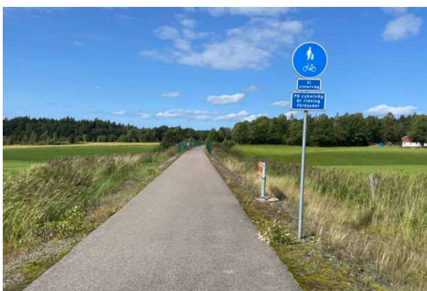
Genom karaktärsområdet Upphärad går järnvägen i en ny sträckning öster Upphärad. Den äldre banvallen är nu cykelbana.
