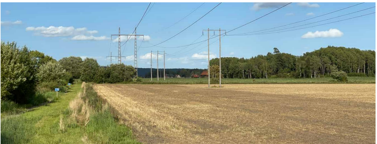
Luftledningar på Gärdhemsslätten. Ett exempel på ett storskaligt linjärt anspråk i landskapet.
