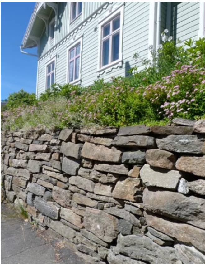
Kallmurade stödmurar är ett viktigt inslag i Strömslund. Murarna är sedan 2003 skyddade i detaljplan.
