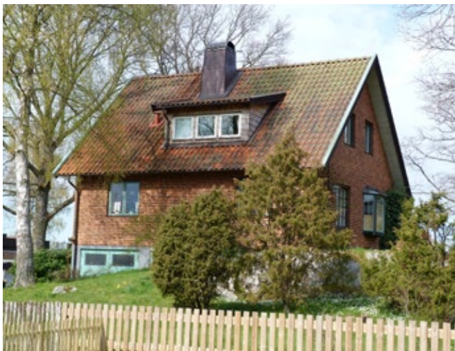
Välbevarad och tidstypisk villa med röda tegelfasader och grönmalade tvåluftsfönster. Välutformade detaljer så som takkupor, burspråk, balkongräcken och entréparti.
