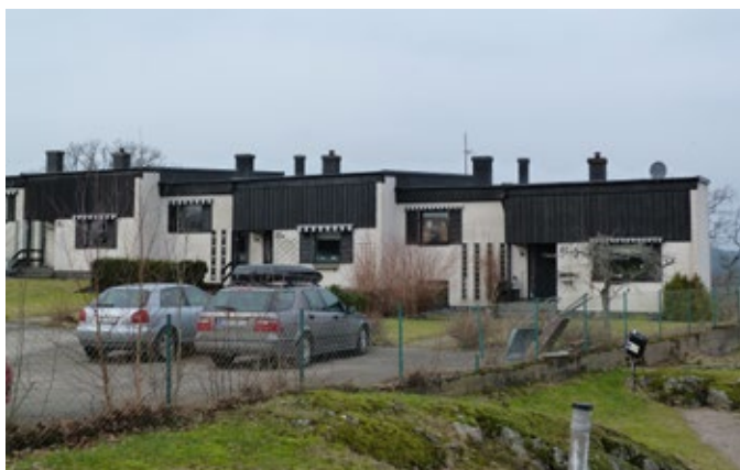
På Dalahöjd uppfördes tre radhus med utsikt över slussarna år 1975 efter ritningar av A. Rydström. Husen har en mycket typisk arkitektur där framför allt material och byggnadsvolymer är karakteristiska för tidens byggnation.
