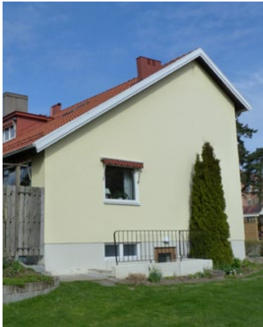
Det så kallade "trollhättetaket" är en taktyp som är särskilt vanligt i Trollhättan, både på flerbostadshus och på mindre en- och tvåfamiljshus. Taktypen var framför allt populär under 1950- och 60-talet.
