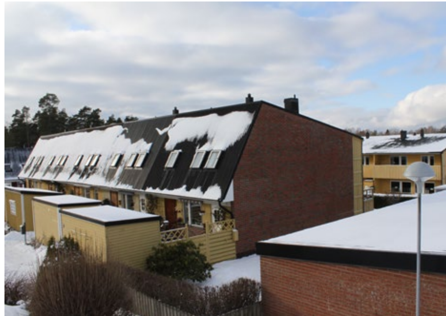
Det så kallade "trollhättetaket" är en taktyp som är särskilt vanligt i Trollhättan, både på flerbostadshus och på mindre en- och tvåfamiljshus. Taktypen var framför allt populär under 1950- och 60-talet.
