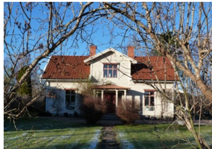
Den gamla jordbruksfastigheten i kvarteret Järnsågen är det bäst bevarade bostadshuset från tiden runt sekelskiftet 1900 i Halvorstorp. Fastigheten är mycket värdefull för förståelsen av stadsdelens äldre bebyggelsestruktur och arkitektur.
