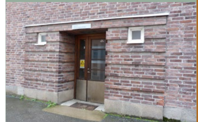
Rustikt utformat entréparti med 1950-talskaraktär.
