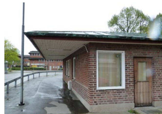
Vakthytt i 1950-talskaraktär med utskjutande takfall.
