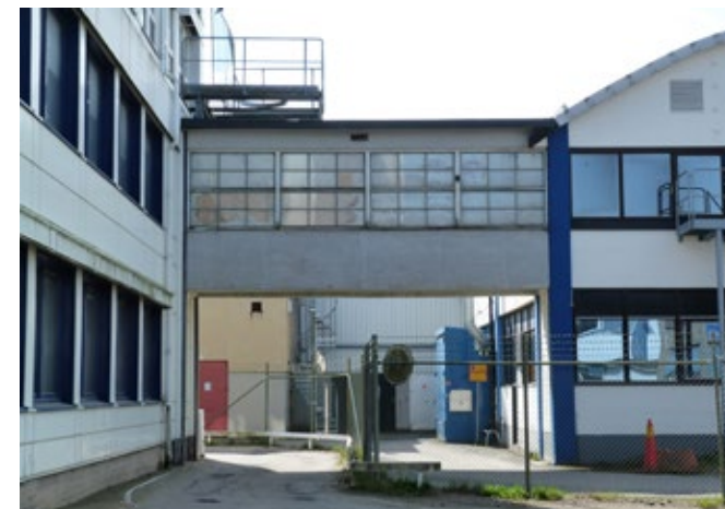
Gångbron som sammanlänkade företagens byggnader. Bron murades igen år 1941 då företagen gick skilda vägar.
