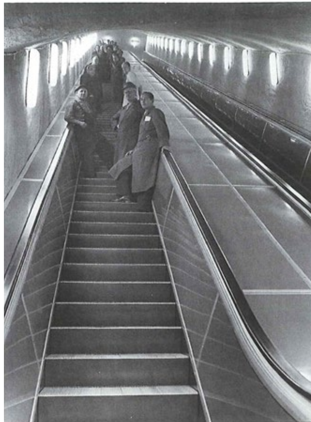
När rulltrappan ner till B-verkstaden byggdes 1951 var det Europas längsta. Rulltrappan är fortfarande i bruk och används dagligen.
