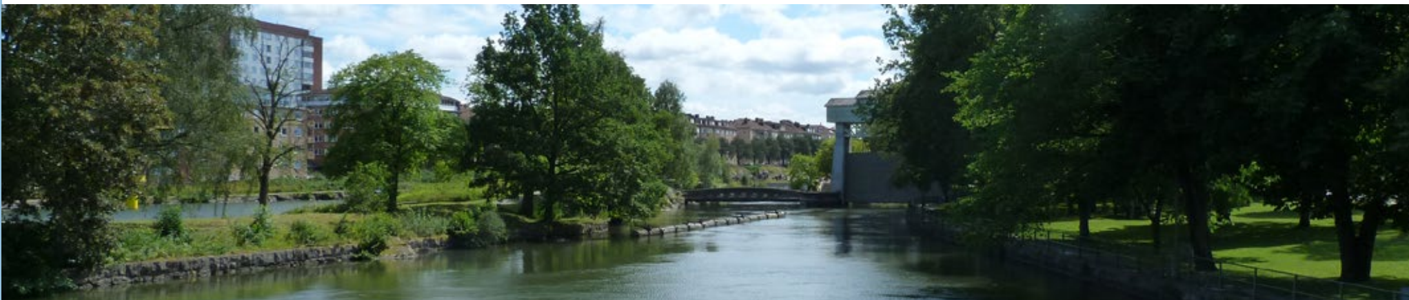
Tilloppskanalen till Olidans kraftstation som började användas år 1910. Längst bort i bild syns den anläggning som används för att torrlägga kanalen vid underhållsarbeten.
