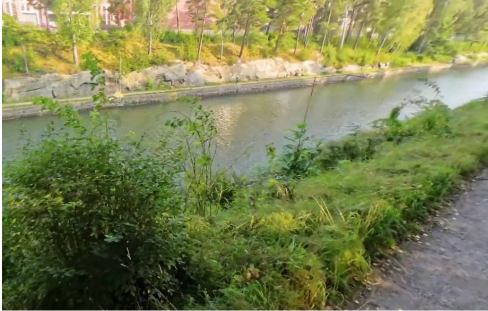
Figur 3. Bergkanalen från västra sidan.
