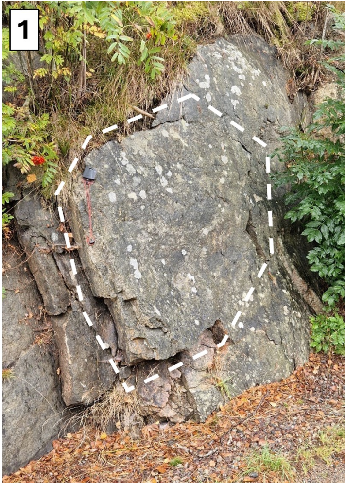
Figur 18. Instabilt block (1) i anslutning till gångväg.
