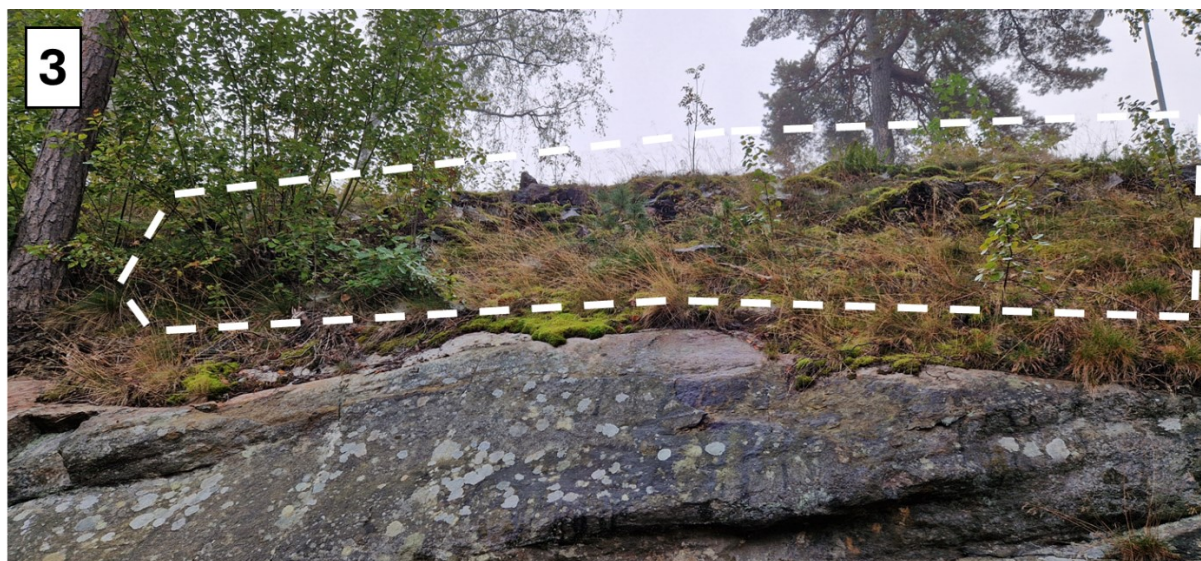
Figur 20. Block/område 3, lös sprängsten högt upp i slänten/ovan släntkrön.
