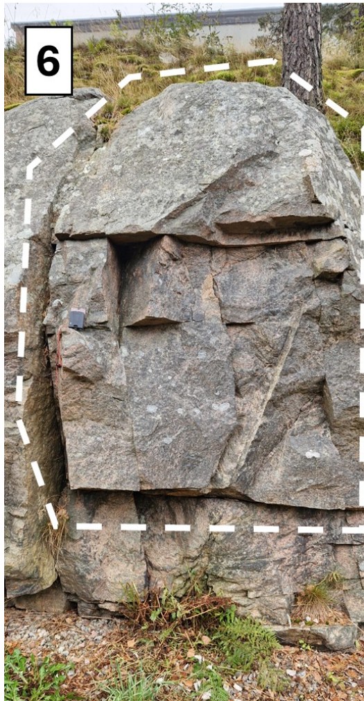
Figur 14. Block 6, större instabilt block som saknar mothåll i släntfot.
