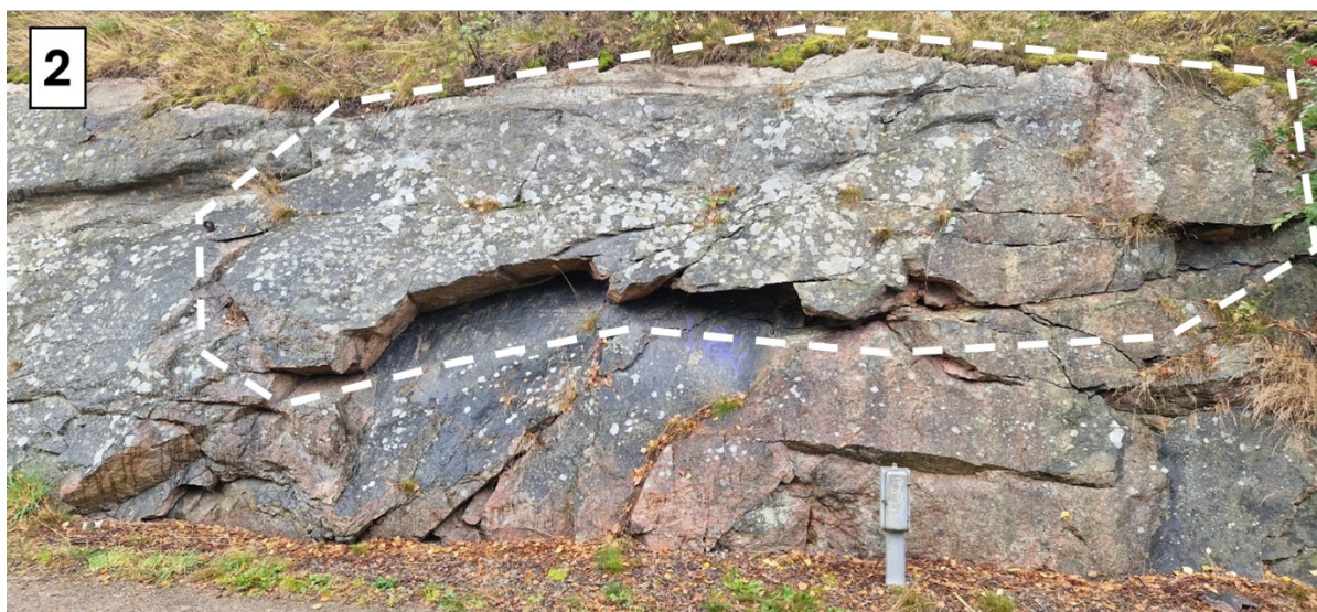
Figur 10. Block 2, större parti av uppsprucket berg som utan mothåll vilar mot ett sprickplan som stupar cirka 60^\circ .
