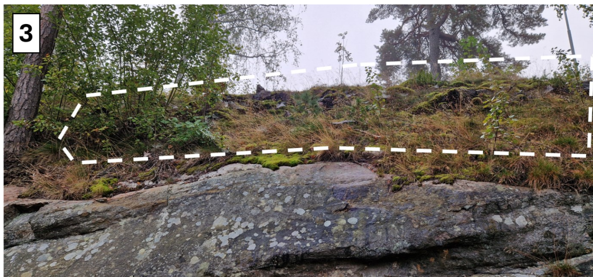
Figur 11. Block/område 3, lös sprängsten högt upp i slänten/ovan släntkrön.
