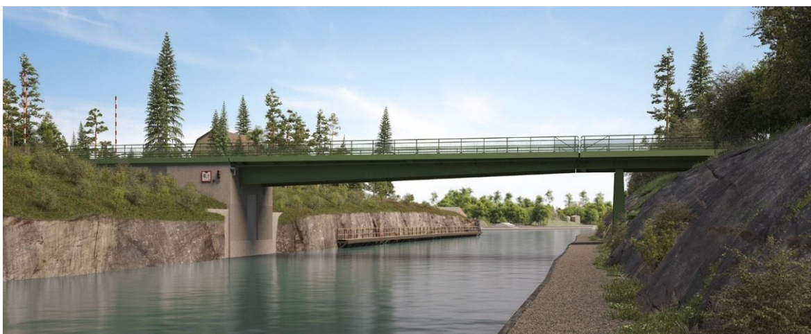
Figur 14. Illustration på möjlig utformning av ny bro i nedfällt läge, sett från dragvägen. (Bild från Trafikverket)
