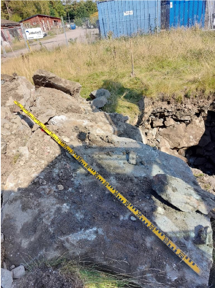
Figur 4. Block med storlek upp till ca d=1500 mm påträffades.
