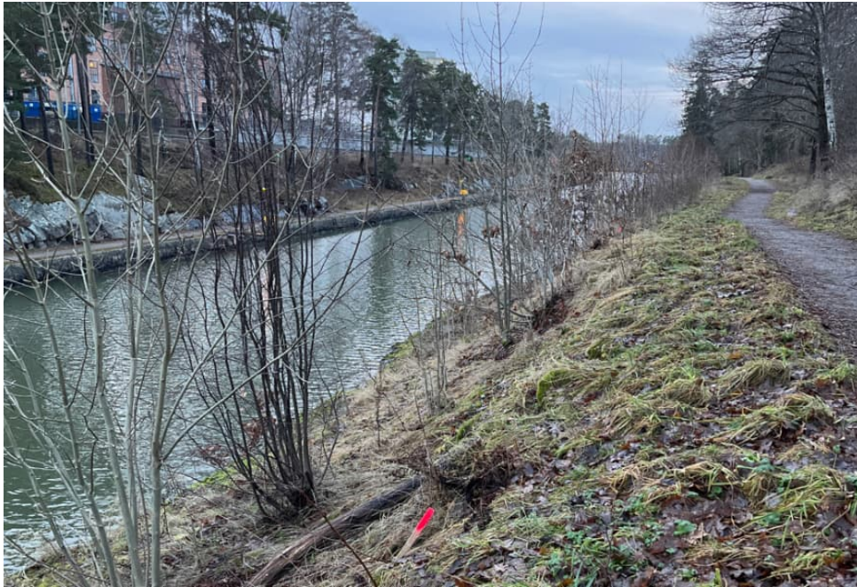
Figur 8. Representativ bild över markförhållanden på västra sidan av Bergkanalen.
