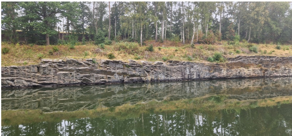
Figur 8. Västra sidan av Bergkanalen.
