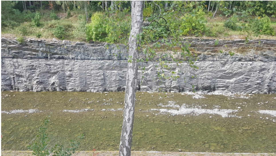
Figur 9. Västra sidan av Bergkanalen, fotografi taget 2021 med liknande snitt som i Figur 8. Slänthöjd från kanalens vanliga vattennivå (ses som en mörk linje i slänten) till botten på bergkanalen är ca 6,2 m.
