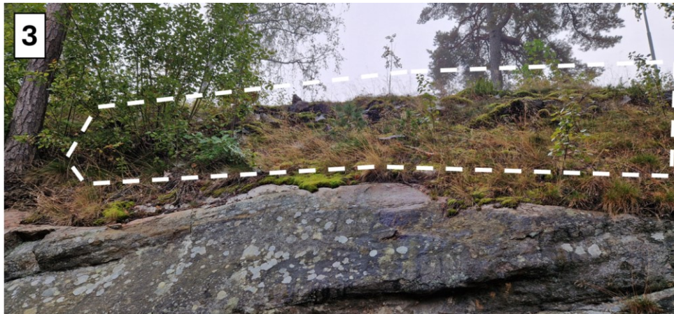
Figur 4. Block/område 3, sprängsten högt upp i slänten/ovan släntkrön.
