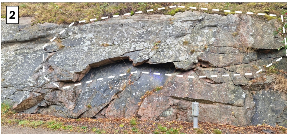
Figur 3. Block 2, större parti av uppsprucket berg som vilar mot ett sprickplan som stupar cirka 60°.
