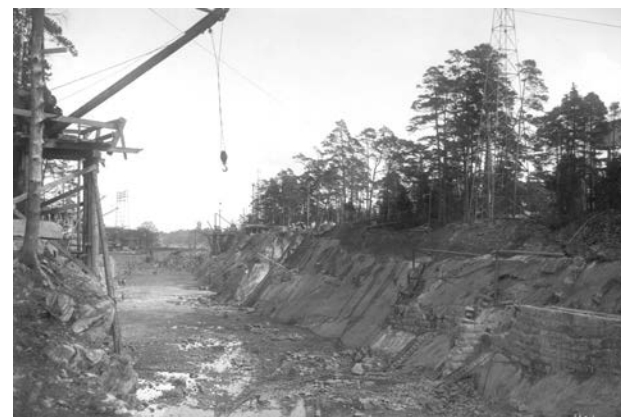
Figur 6 Bergkanalen under arbetet med breddningen av 1916 års sluss- och kanalled. Den nya dragvägen är under konstruktion. Fotot är taget 1914 i närheten av den nya bronns tänkta placering och i riktning mot Olidebassängen. Sjöfartsverkets arkiv
