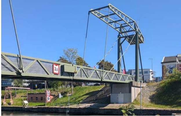
Figur 42 Olidebron – en bro med tydlig karaktär. Kopplingen till det industriella arvet är tydligt synlig i brons utformning; fackverkskonstruktionen, den karaktäristiska ovanliggande lyftanordningen, den gröna kulören och stålet.
