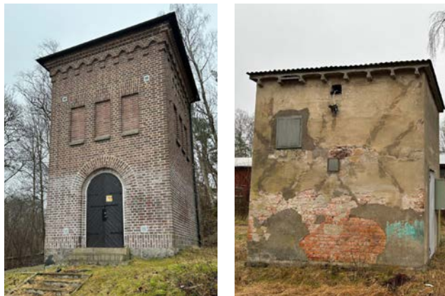
Figur 63 Exempel på nyttobyggnader i området - Transformatorstation omsorgsfullt gestaltad i rött tegel samt ett ställverk med sällsynt, karaktäristisk takkonstruktion av prefabricerad betong
