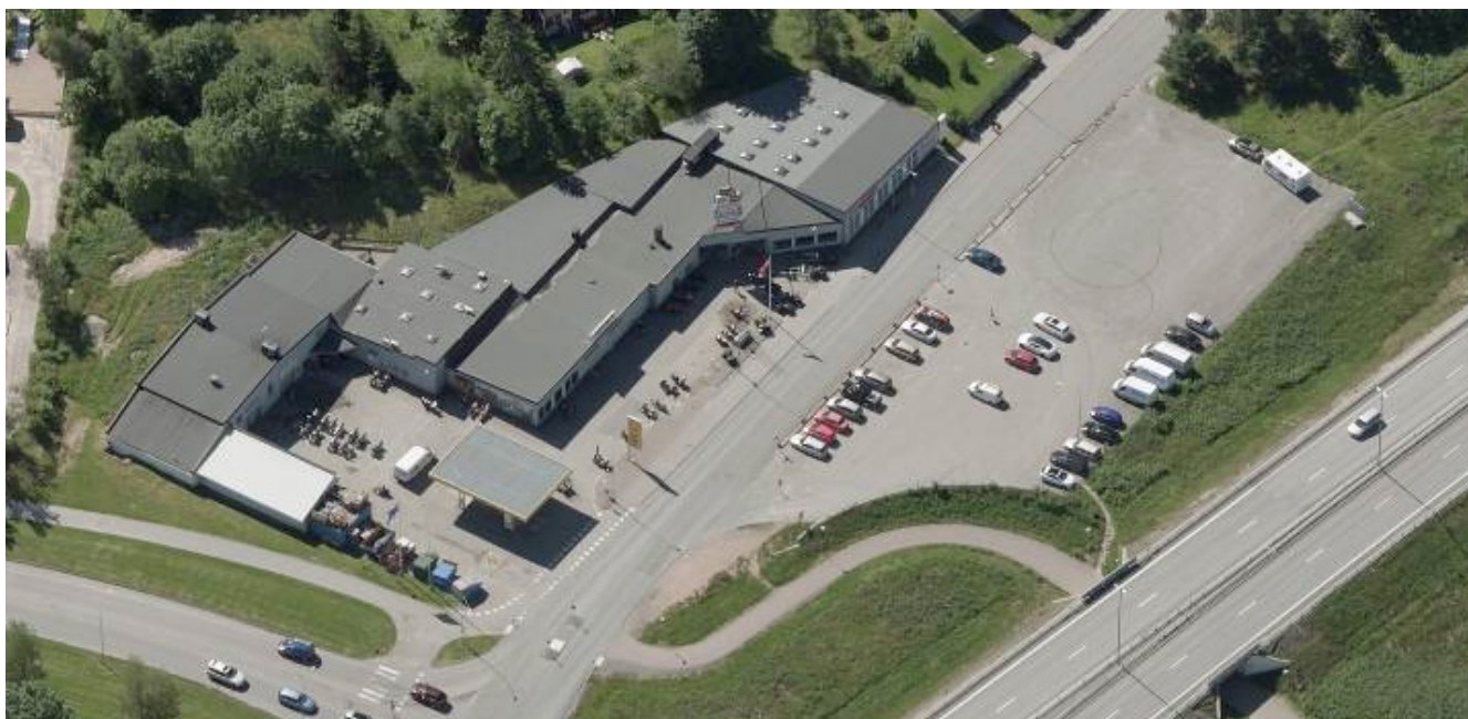
Översiktsbild av byggnader inom Tandvingen 1, juli 2016
