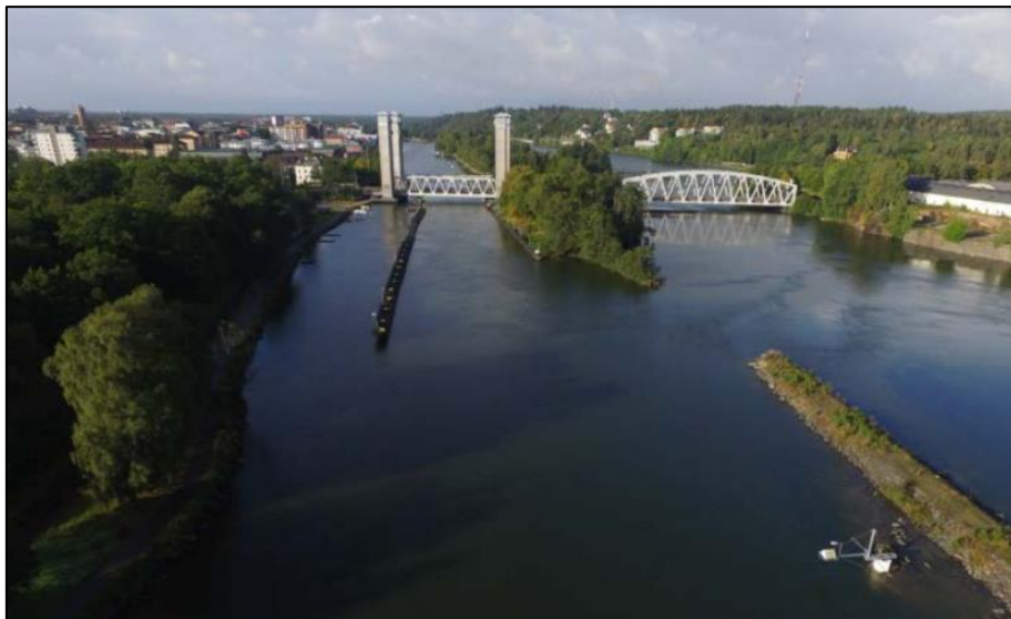
Figur 2-1 Översikt över Hjulkvarnsholmen och befintlig bro sett från norr. Konvaljön åskådliggörs i figurens nedre högra del [5].
