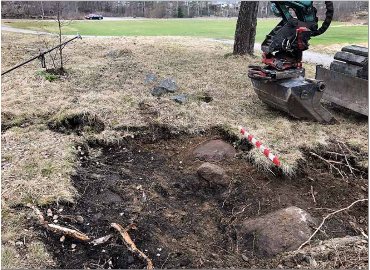
Figur 28. Bilden visar schakt 32 som grävdes i västra kanten av huslämningen, Trollhättan 315. Raden av syllstenar ses i den gräsbevuxna ytan och i schaktet framkom ytterligare tre syllstenar som låg dolda under jordtäcket. Inom huset lager med träkol blandat med recenta material, mestadels taktegel. På utsidan huset var bara opåverkade lager. Foto mot västsydväst, Robert Hernek, Bohusläns museum.
