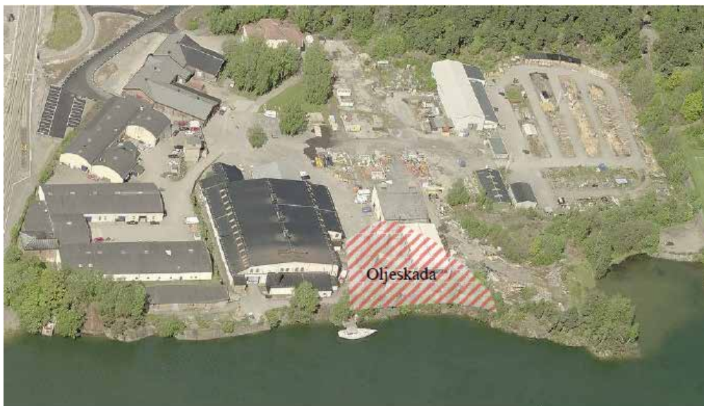
Figur 3.15 Område med oljeskada skrafferat (Structor 2015)
