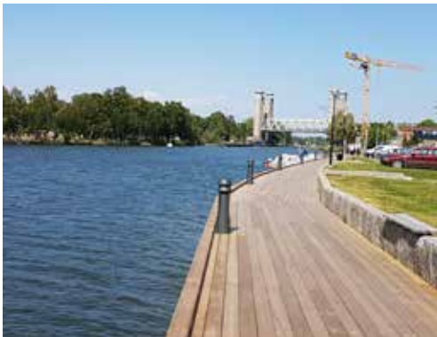
Vy över trafikkanalen från kajen längs Strandgatan
