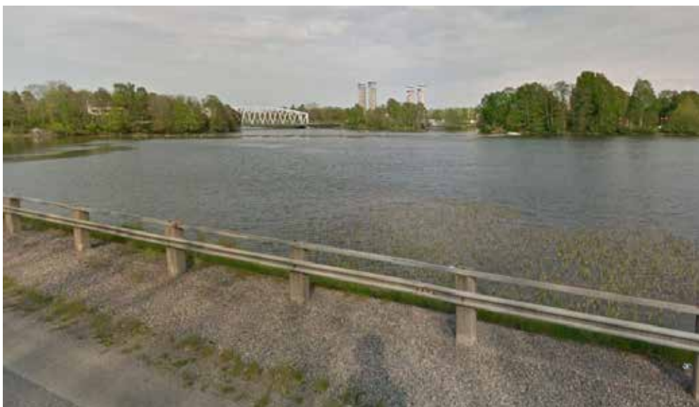
Vy mot järnvägsbron från Vänersborgsvägen
