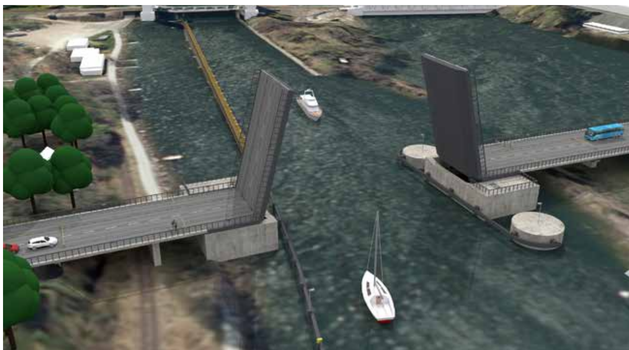
Figur 4.10 Stridsbergsbron med kassuner och ledverk (Trollhättans stad)
