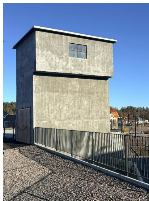
Bild 24. Hisstornet efter renovering. Bild: Trollhättan Exploatering AB
