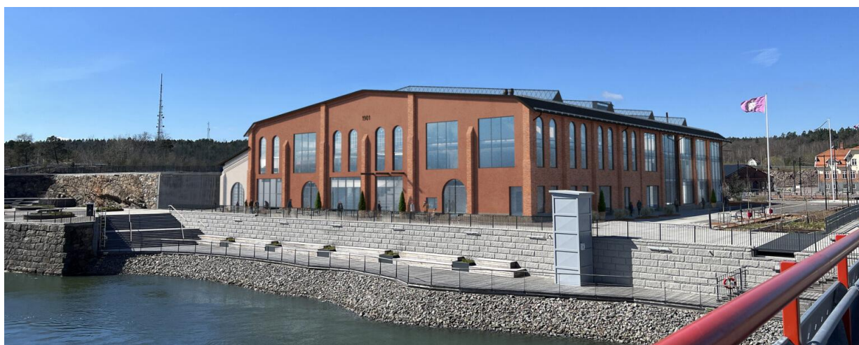
Bild 22. Visulisering över hur Martinverket kan se ut efter renovering. Skiss: Contekton Arkitekter
