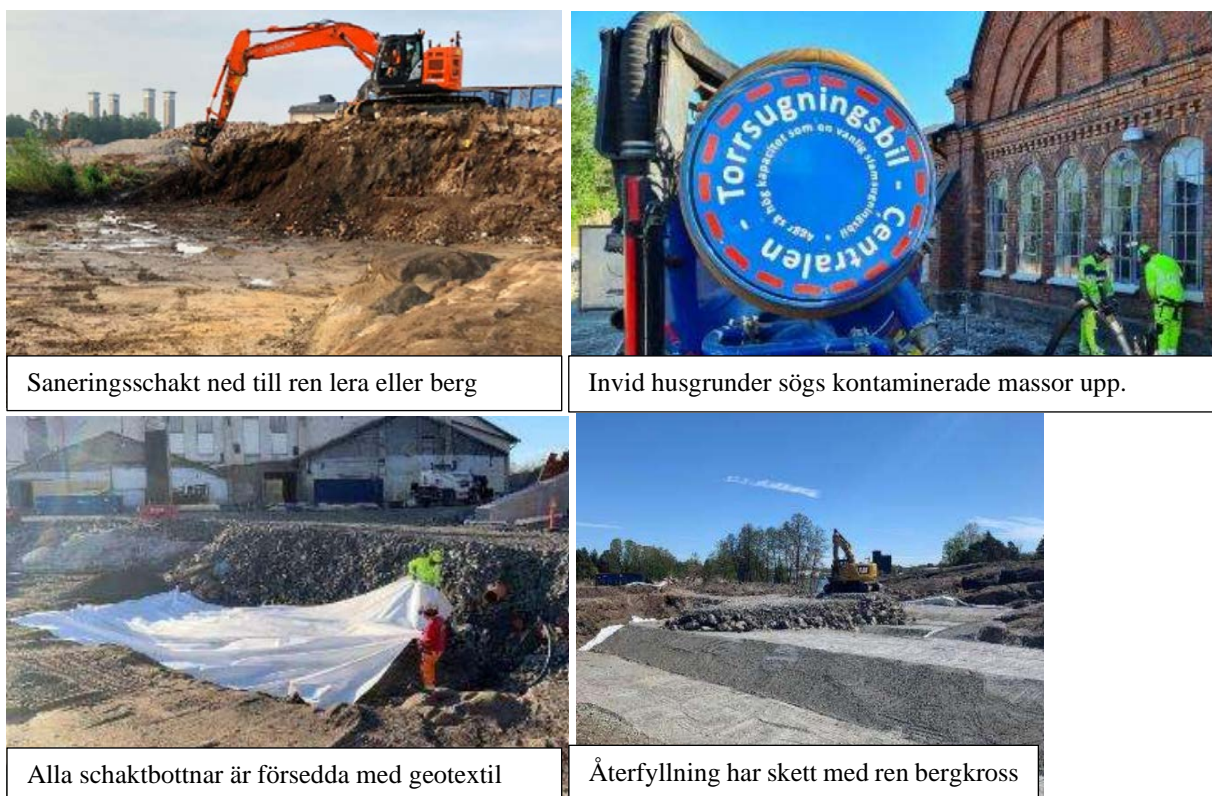
Figur 2 Foton från sanerings- och återställningsarbete.
