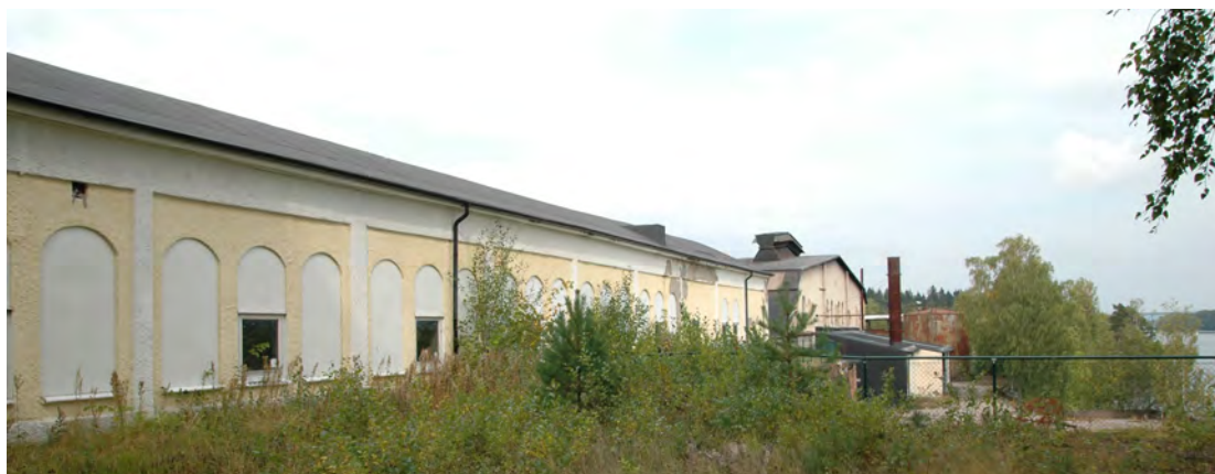
Avsyningsbyggnadens sydvästra fasad. Här föreslås de igensatta fönstren tas upp.
