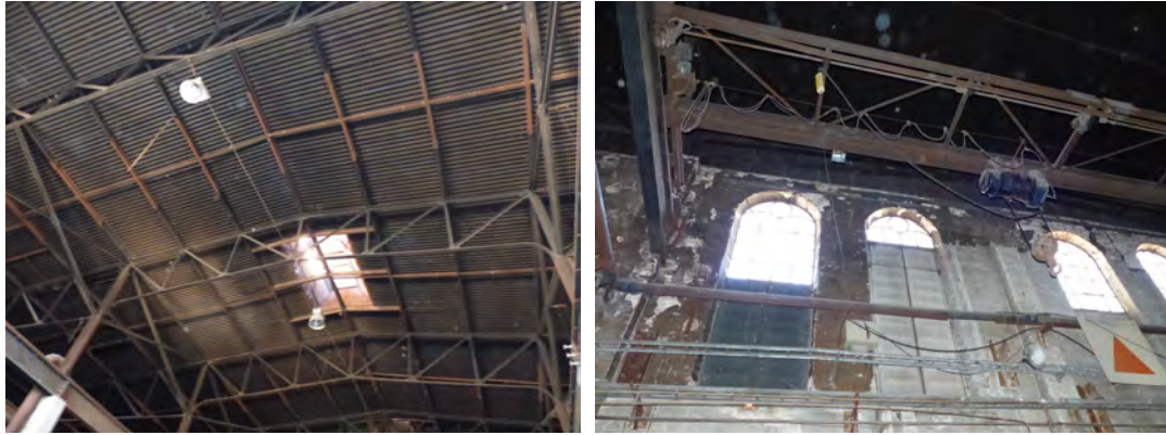
Till vänster foto på fackverket i taket. Till höger fönster som föreslås återställas.
