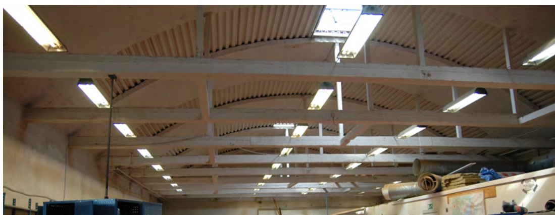
Den kultur- och industrihistoriskt intressanta takkonstruktionen.
