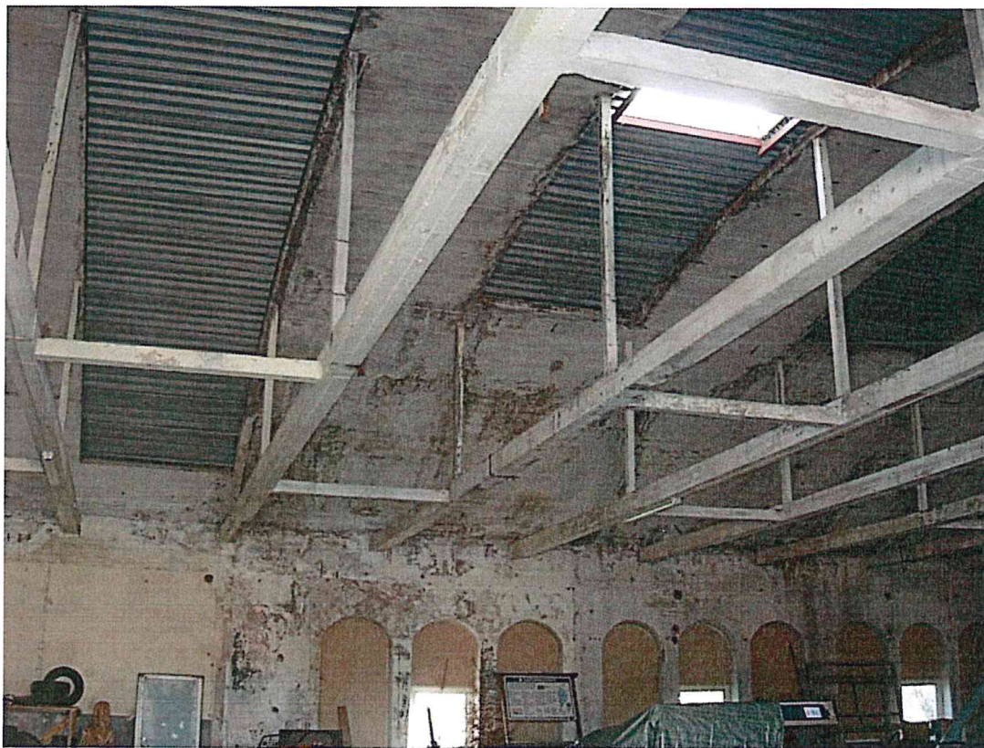
7. Betongvalv med dragstag i hus 1 – bilaga 2
