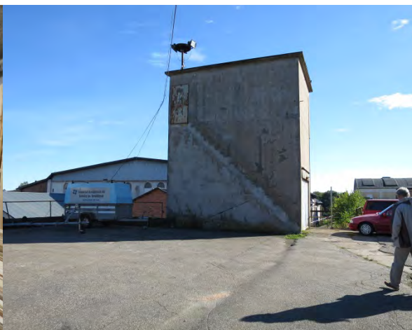
Figur 20. Hisstorn har hissmaskin innehållande olja. Detta utrymme var låst.
