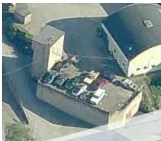
Figur 5. Skyddsrum och hisstorn.
