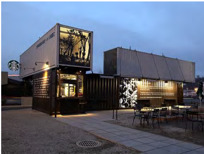
Exempel på mobil och tillfällig byggnad.
