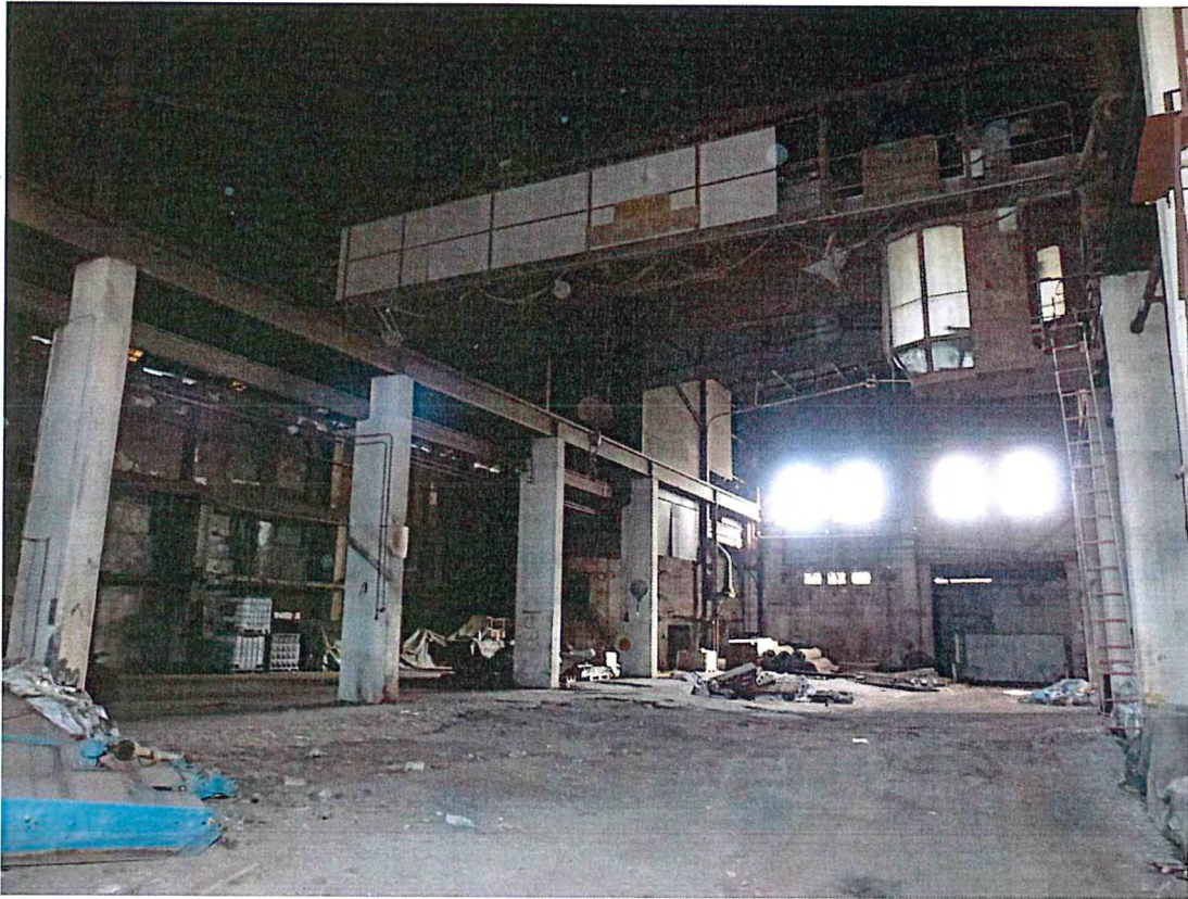
3. Betongpelare, traverser och grusgolv i industrihallen
