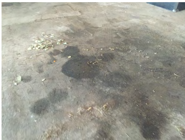
Figur 23. Mindre mängd oljefläckar finns på betonggolvet i hallar.
