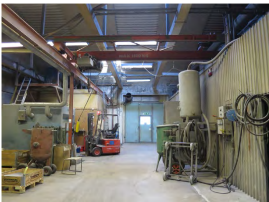
Figur 21. Golv och väggar är dammiga av blästersand från pågående verksamhet.
