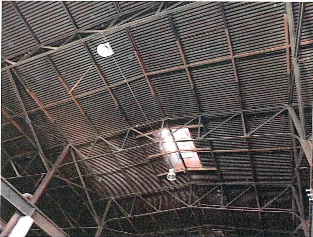
1. Stålkonstruktion och tak i industrihall – Martinverket
