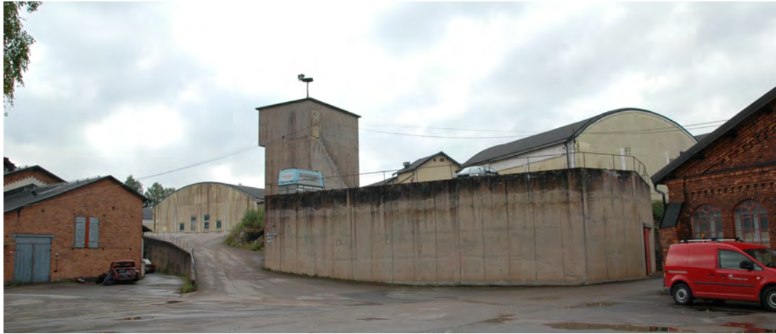
Hisstornet med skyddsrummet nedanför.
