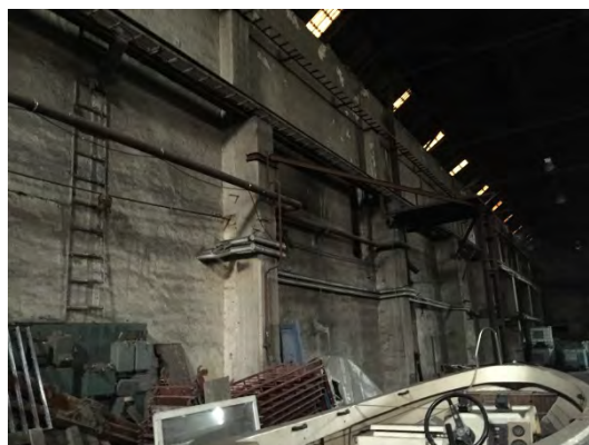
Figur 7. Tegelväggar är invändigt putsade, vitmålade och mer eller mindre smutsig/sotiga (grön strekat område).
