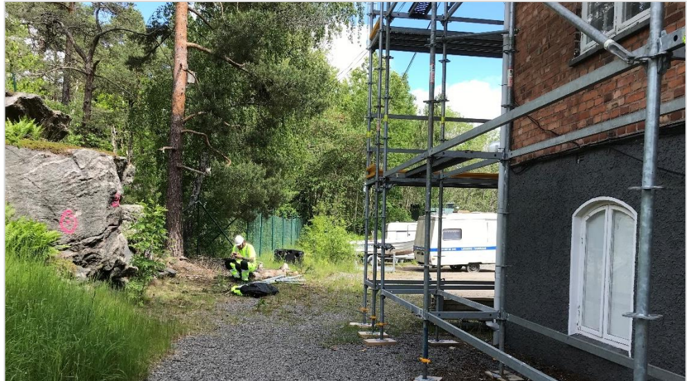
Figur 22. Bergskärning (t. v.) i område 3 i nära anslutning till kontorsbyggnad.
