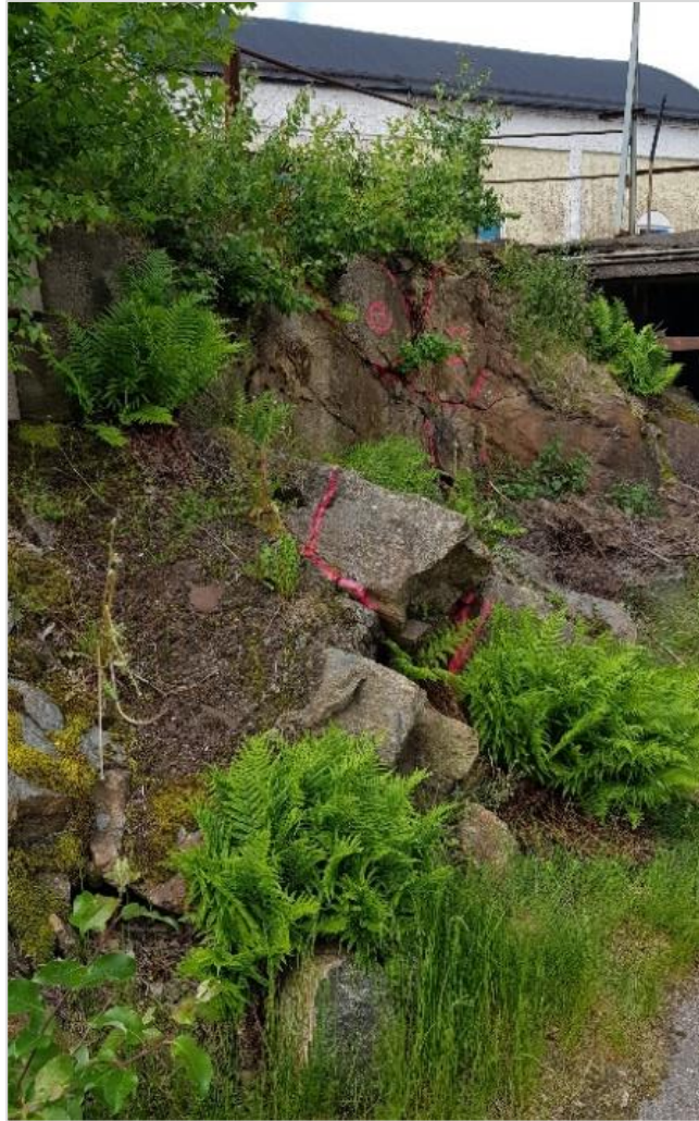
Figur 17. Skärningen sedd från sidan med markplanen ovanför.
