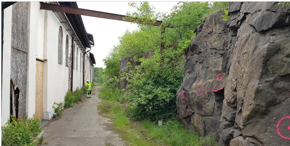
Figur 6. Bergsslänt i område 1 i direkt anslutning till äldre industribyggnad.
