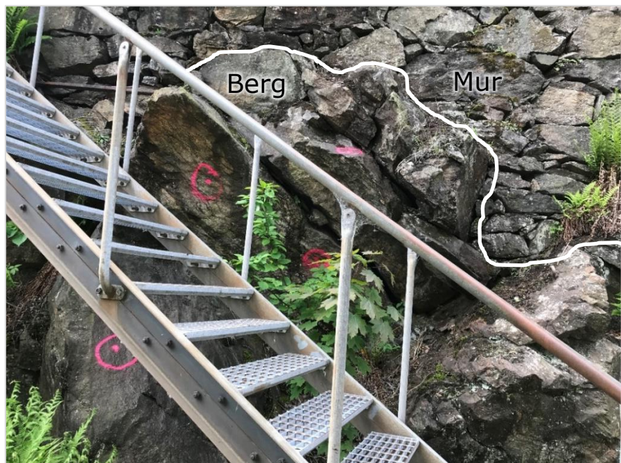
Figur 10. Muren ligger inarbetad i berget vid skärningens östra del.
