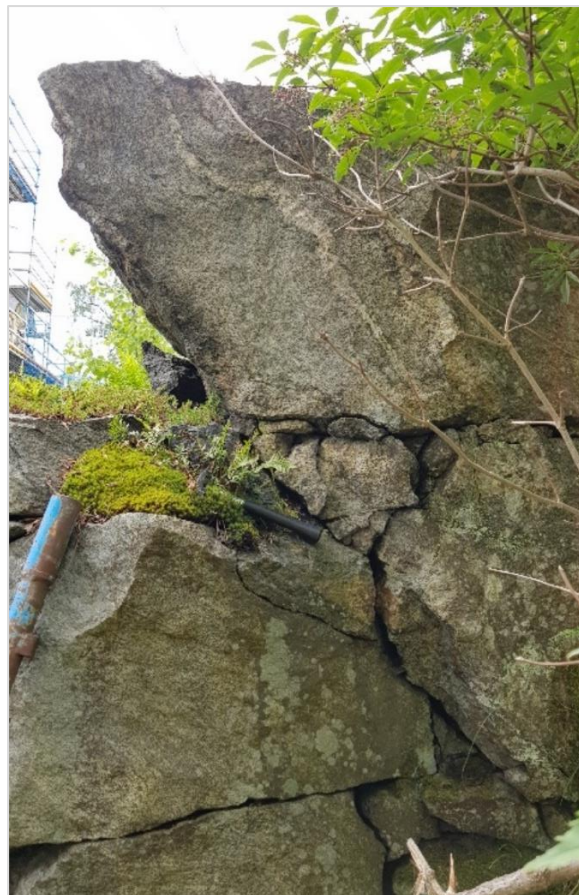
Figur 24. Stora lösa block i skärning.
