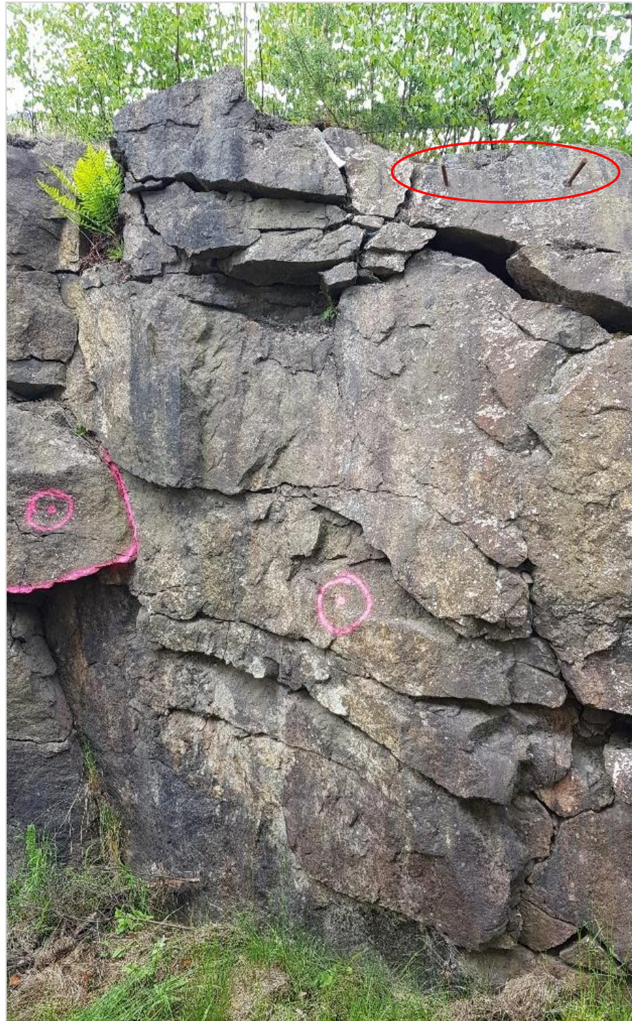
Figur 11. Stora lösa block och tidigare utförd bergförstärkning.
