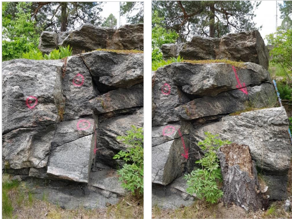
Figur 23. Lösa block i skärningen bakom kontorsbyggnad.
