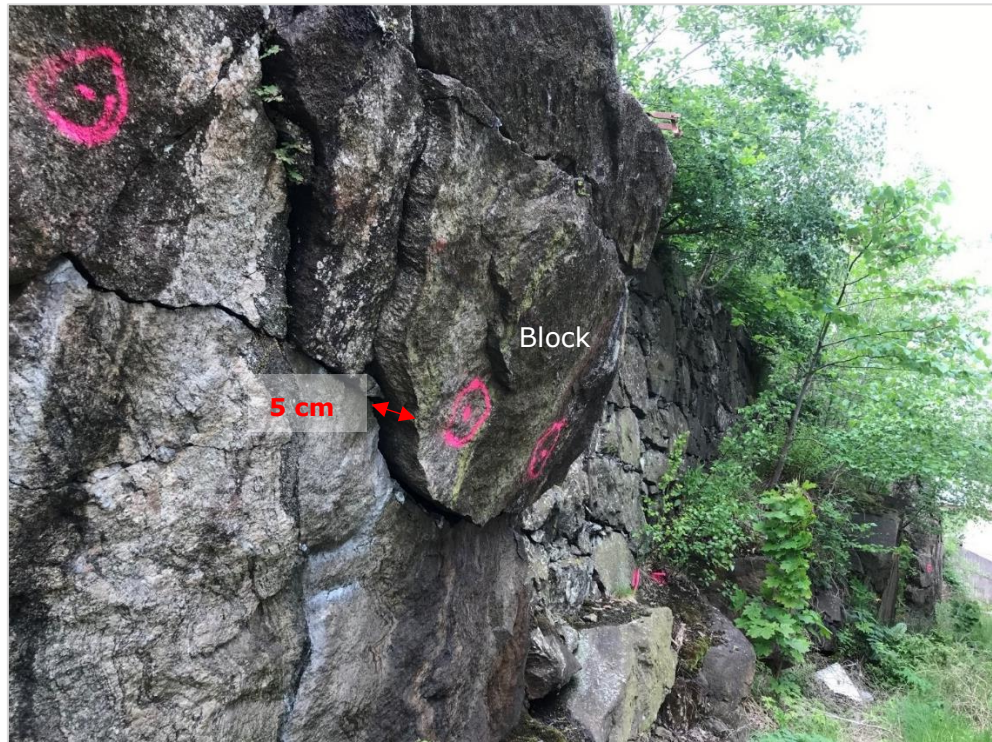
Figur 8. Stort instabilt block som redan har glidit ut 5 cm. Blocket har rosa bultmarkeringar.
