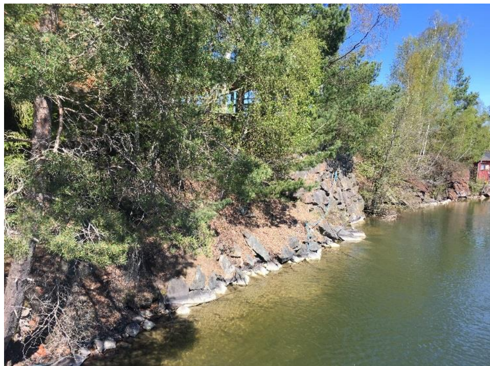
Figur 17 Stödmur vid strandkanten, COWI AB 2018-05-08.
