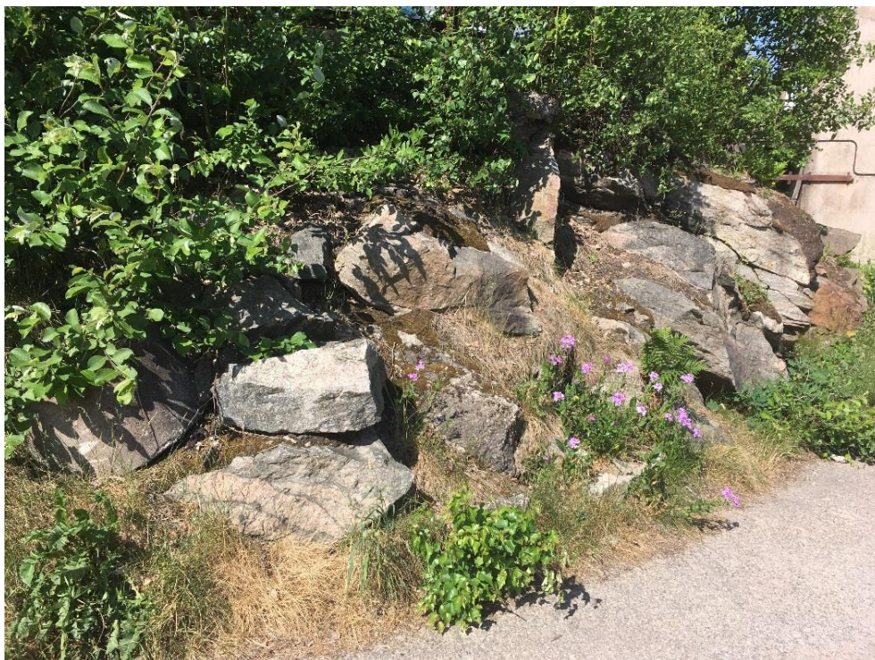
Figur 11 Bergsslänt med lösa block och fyllnadsmassor
