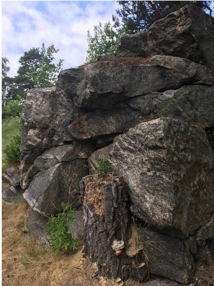
Figur 12 Lösa block bakom kontorsbyggnad
