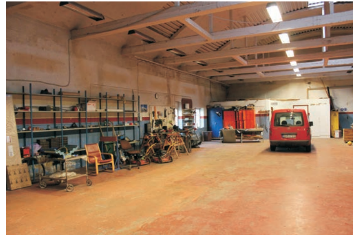
Den stora hallen har ett intressant och historiskt tidigt betongtak med takbjälkar i betong. Golvet är idag i betong och väggarna är putsade. Få fönsteröppningar i byggnaden åt väster.
