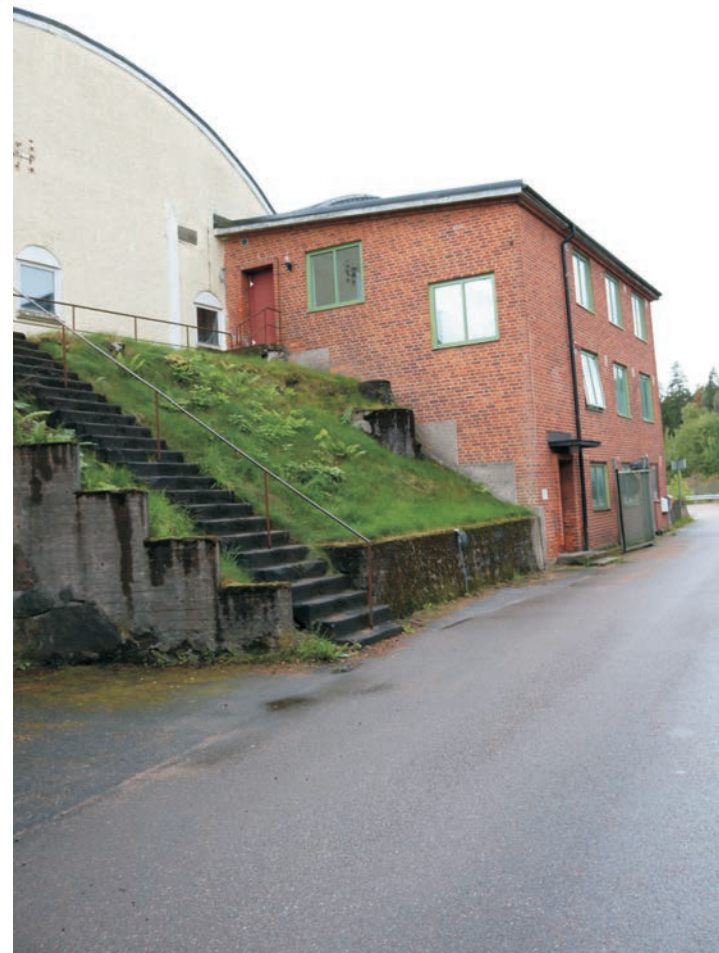
Personaltillbyggnaden uppfördes under 1950-talet och är en trevåningsbyggnad med kök, matsal, omklädningsrum och duschar, toaletter. Fasaderna är av rött tegel. Fönstren är tidstypiska från 1950-talet.
