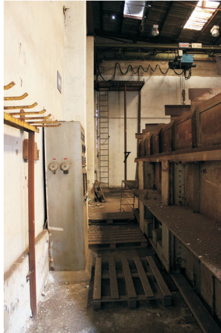
Även här syns takfönstren och inredning med kvarvarande traverser m.m.
