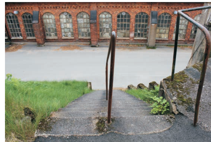
Betongtrappa ned från Takterassen på Skyddsrummet och Garaget.
