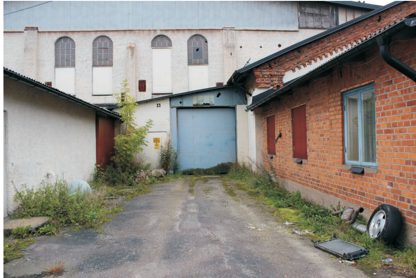
Längst in finns ännu en skjutdörr på den vita tillbyggnaden. En mindre tillbyggnad rakt fram är en gemensam port för Martinverket och tillbyggnaden till vänster. Den är murad i tegel och vitputsad. På ta-
