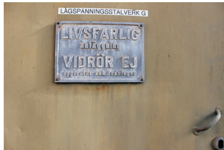
Skylt på dörr in i den mindre utbyggnaden.
