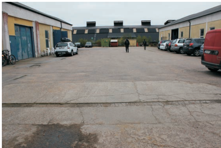
Inifrån området och ut mot Martinverkets tak är platskaraktären påtaglig.
