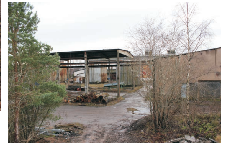
Vyn genom Sägverket söderut. I blicksfältet syns Spikön och dess höga Transformatorstation.
