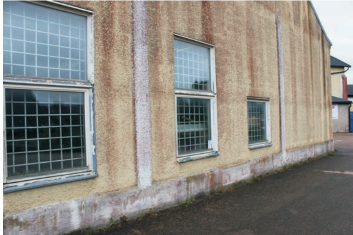
De "nya" fönstren på den västra delen av Sågbladsfabriken i nya fönsteröppningar.
