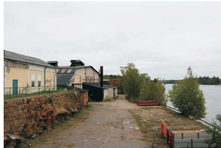
8. Den öppna platsen fortsätter förbi Martinverket och kontakten med, och utblicken över älven är påtaglig. Kopplingen mellan området och vattnet som kraftkälla och transportväg framstår här väldigt tydligt.
