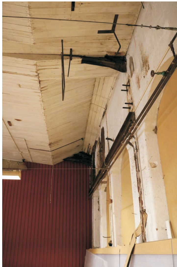
Detalj av tak visar det vitmålade innertaket i trä. Många detaljer från tidigare industriell verksamhet sitter kvar i väggar och tak. Även denna flygel hade ursprungligen en lanternin på taket som är borttagen idag.
