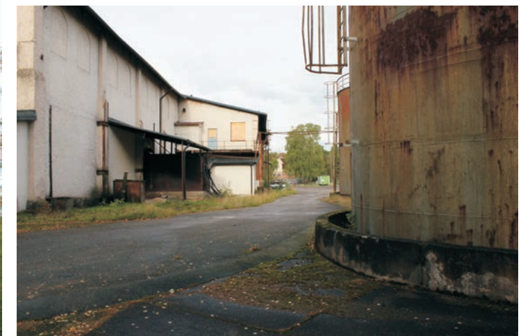
Utmed Martinverkets nordostfasad vinn ytterligare en utbyggnad. Laboratoriet eller som det senare benämns personalutrymmen. Personalbyggnaden beskrivs på annat håll separat. Notera att fasaden på Martinverket har en grövre puts än personalbyggnadens ändsida.
