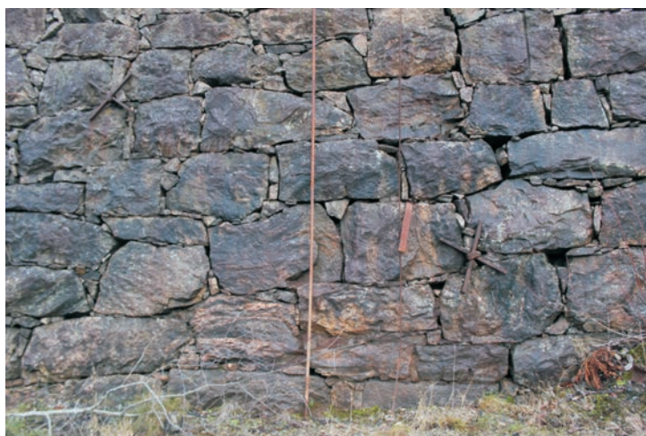
Närbild på murverket som omsluter Hyveljärnsfabriken och Sågbladsfabrikens högre belägna byggnader.
