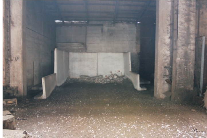
Den tillbyggda götugnen från 1950-talets slut ligger troligen här.
