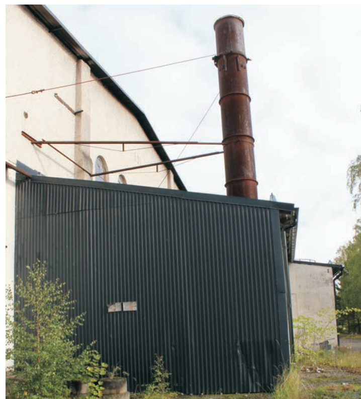
På byggnadens gavel är det en plåtfasad.
