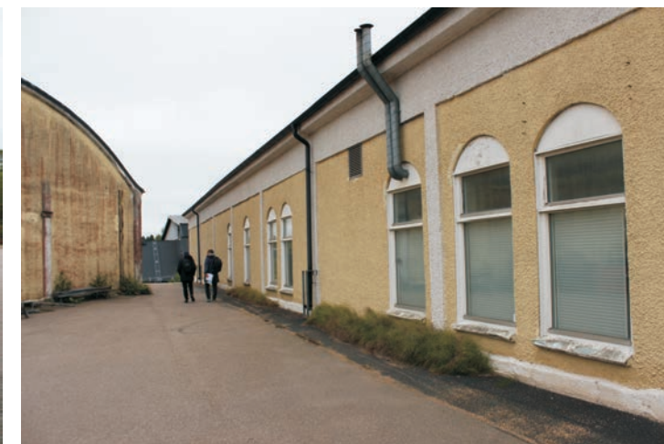
Här från andra hållet syns de nyare fönstren och den platsbildning som finns mellan husen.
