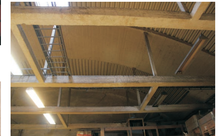
Taket liksom takstolarna är också av betong i stora delar av byggnaden.
