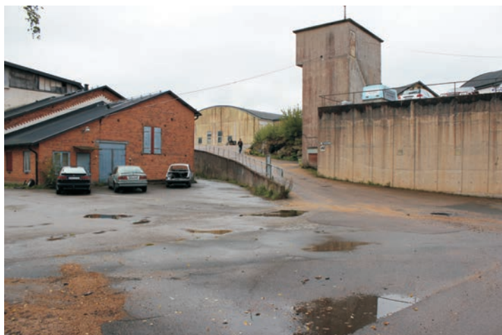
Platsen mot höjden med ett förrum vid Värmecentralen upplevs som en tät och spännande platsmiljö.
