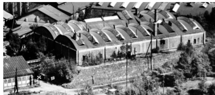
Ett utsnitt av ett äldre fotografi visar hur fasaden såg ut i väst när den var i tegel med putsade "ramar". Här syns även att taket inte är tunnvalvt i sin helhet i byggnadskroppen åt öst. Den är då fotot tas på 1930-talet uppdelad i fyra byggnadsdelar.
