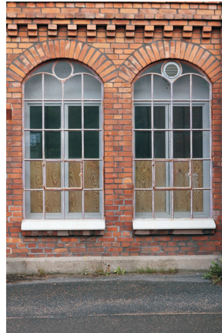
Originalfönstren med en öppningsbar del i nedre mitten. Det runda hålet i det högra fönstret längst upp har ventilation. Nya innanfönster ditsatta i modern tid.
