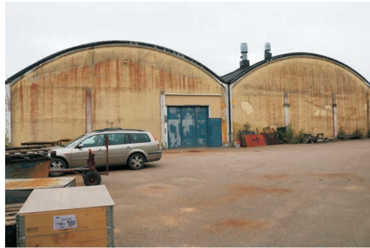
Hyveljärnsfabrikens gavlars söderut. I smutsränderna på fasaden syns rester av de utbyggnader som har funnits här tidigare. De torde funnits under senare år eftersom de saknas på ritningar från 1949 och 1957, men finns på avfotograferat ritningsmaterial av senare datum. Dessa fasader saknar fönsteröppningar helt.
