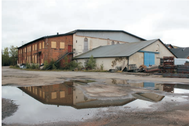
Tillbyggnaden åt vänster uppfördes troligen på 1930-talets slut. Byggnaden har bl.a. innehållit slipstenstillverkning. Det är en byggnad uppförd i tegel med vitputsade fasader. Den har ett stort grått plåttak. Den har två större skjutdörrar i gaveln.
