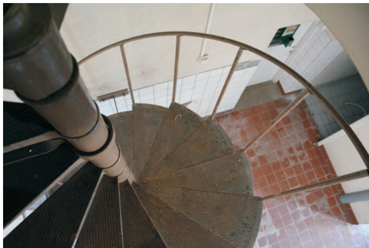
Spiraltrappan ovanifrån och ned.
