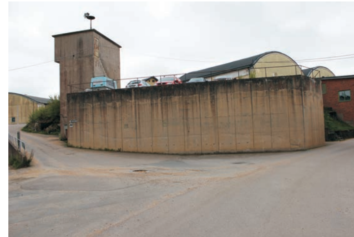
Kanske uppförs hissen med skyddsrum någon gång på 1950-talets slut i samband med att personalbyggnaden uppförs intill. Det är en med formstag platsgjuten betongkonstruktion för ett skyddsrum, ett garage och en hiss.
