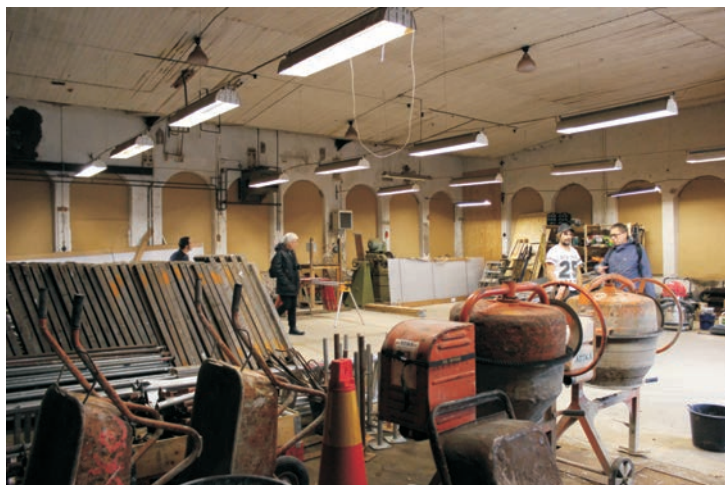
I den till ytan mindre byggnadskroppen mot norr är samtliga fönster igenstängda interiört. Innertaket är i original och vitmålat av trä. I denna lokal finns det trägol blandat med betonggol. Oklart om det har gått väggar där tidigare som förklarar gräns mellan trä och betong.
