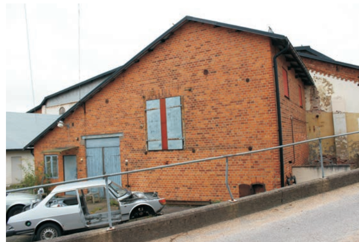
På tillbyggnadens högra sida syns två igensatta fönsteröppningar på övre våningen.
