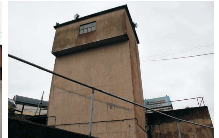
Hisstornet har ett fönster och ett överhäng i den övre delen. Det har troligtvis gått en trappa på utsidan.
