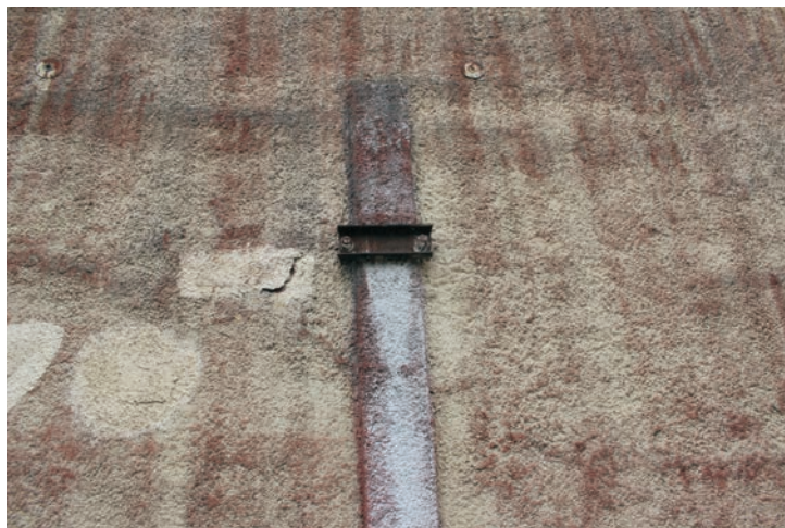
Närbild på utskjutande fält i fasaden.
