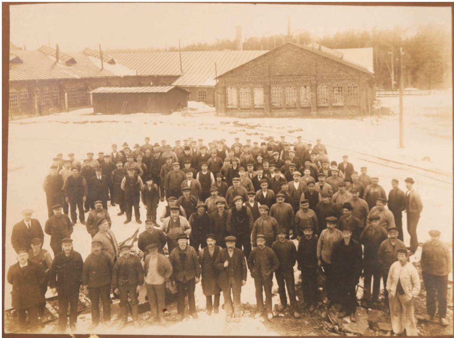
På den historiska bilden kan man se Filfabriken i ett tidigare skede med taklanterniner. Det går också att utläsa att hela taket varit belagt med plåt.
