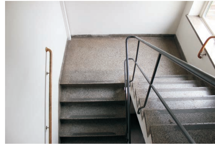
Interiört har trapphuset en trappa av terazzo och stramt utformade handledare och räcken i smide.
