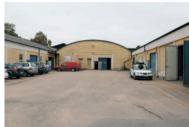
12. Kring gården ligger två av de typiska fabriksbyggnaderna med välvda tak i betong från 1910-talet; sågbladsfabriken och lokalen för avsnymning och förpackning. Ett tidigare mittskepp har rivits och utgör nu en öppen plats mellan de båda byggnadskropparna.
