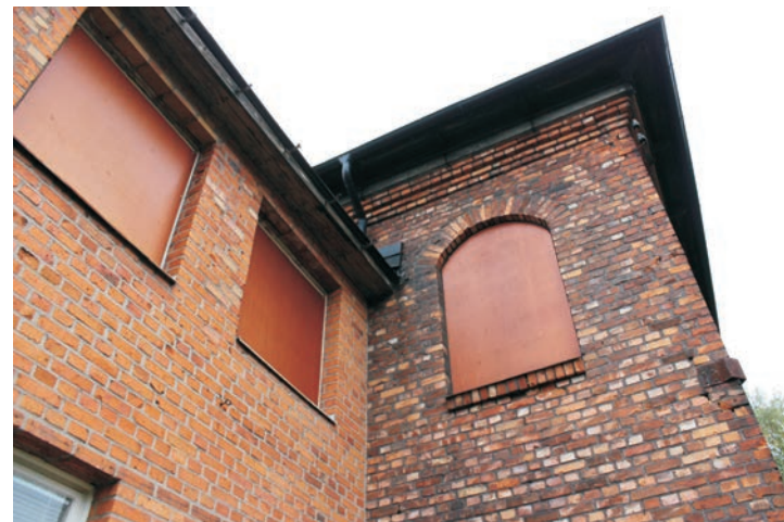
Här möts Personalbyggnaden och Transformatorbyggnaden med äldre och nytt rött tegel intill varandra. Samtliga fönster på Transformatorbyggnaden är igensatta liksom några fönster på Personalbyggnaden. Takfoten på Personalbyggnaden är avslutad som en takgesims.
