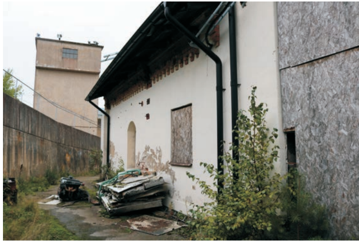
Den utbyggda värmecentralen i en våning med högt sadeltak. Fönstren är igensatta.
