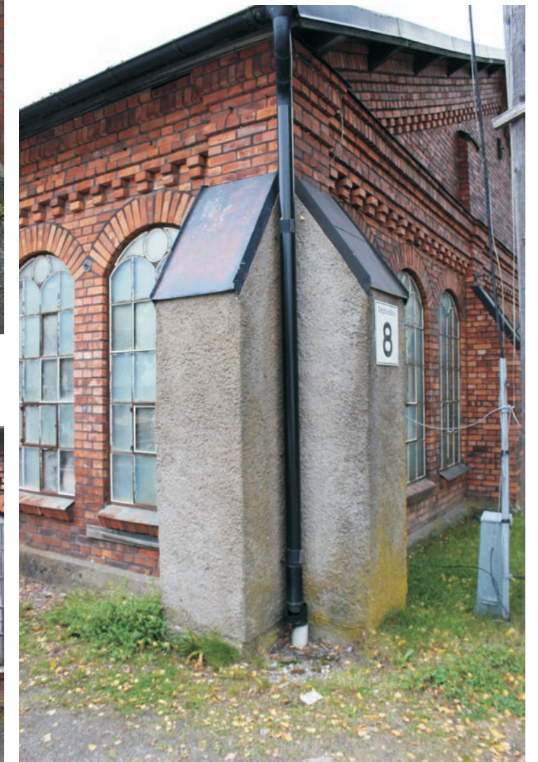
Här har av någon anledning strävpelarna blivit överputsade.
