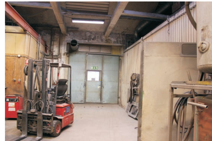
En modern port insatt i byggnaden.
