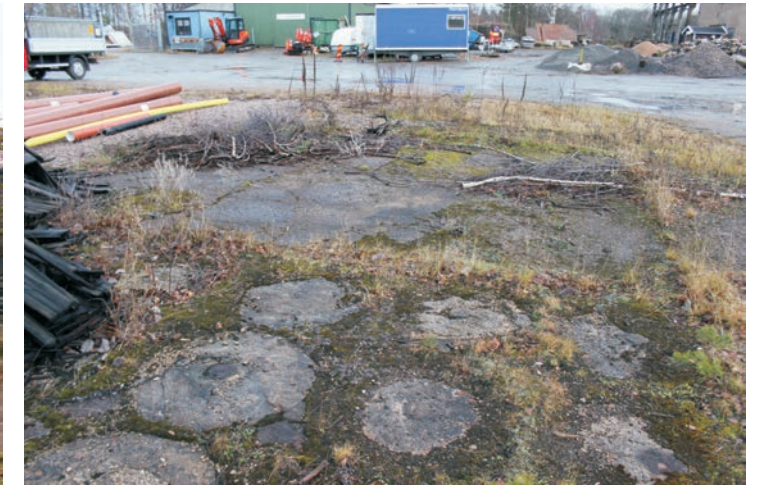
Slipstenar som markbeläggning vid den rivna Mekaniska verkstaden.
