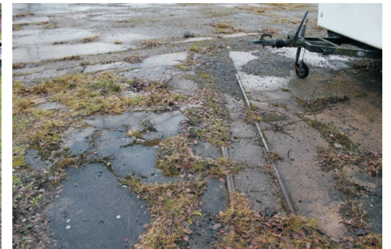
Spår av metallavgränsning i marken vid den rivna Mekaniska verkstaden.
