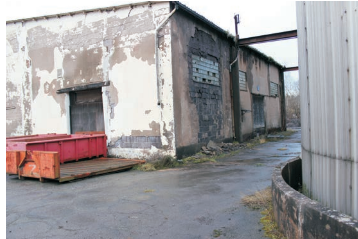
Tre högt belägna ljusinsläpp utförda i glasbetong finns på den sydöstra fasaden.
