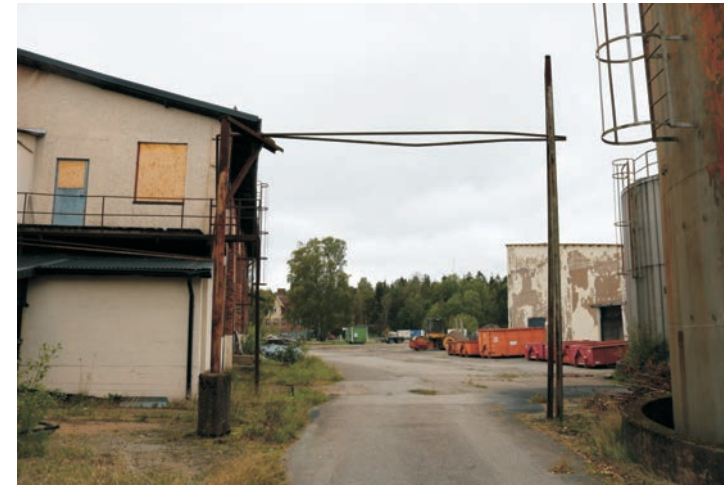
Vägen på andra sidan om Martinverket är bredare och ger långa utblickar mot områdets centrala delar. I bakgrunden skymtar delar av Kontoret fram.
