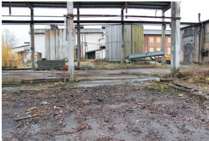
Närmare sågverket står ytterligare två runda oljecisterner i plåt.
