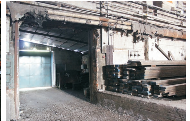
Utbyggda förstugan där utbyggnaderna åt nordväst kan nås. Rester av den industriella produktionen.
