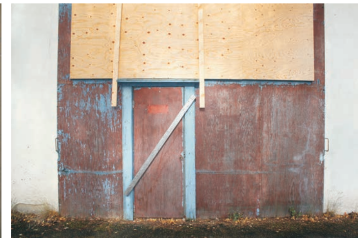
Igensatt port på utbyggnaden i sydost som troligen tillkom efter 1958.
