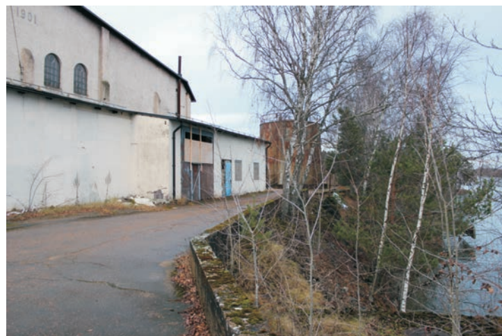
Utmed Göta Älv syns områdets hamn där skrotet och järnet kom in i produktionen på bruket. Här lämnade alla produkter Stridsberg & Biörcks område likaså. Oljesilon står som minnesmärke. Utbyggnaden från sent 1950-tal har troligen varit en personalbyggnad.
