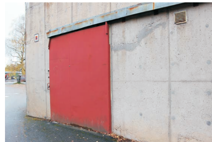
Porten i metall är av skjuttyp.
