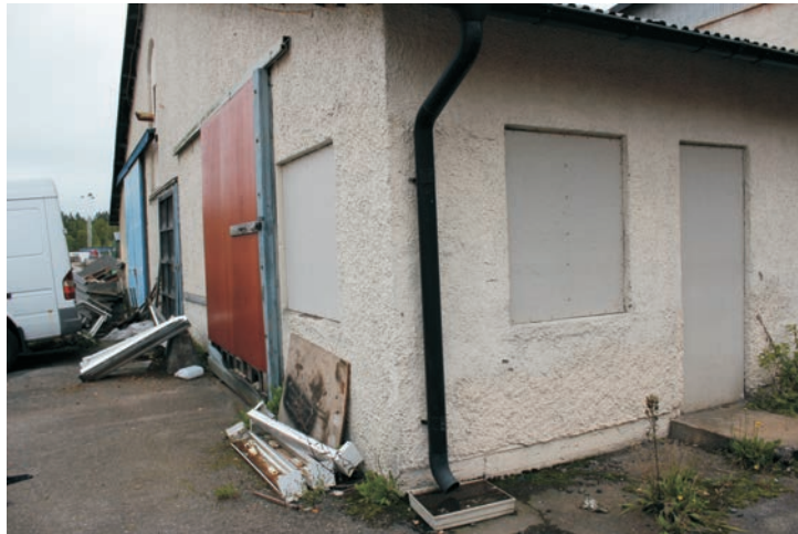
I långsidans fasad finns en dörr och ett fönster som är igensatta.
