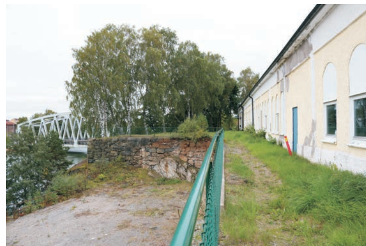
9. Nedanför sågbladsfabriken finns en öppen plats där en numera riven byggnad legat. Utrymmet avgränsas av älven mot öster och terrassmuren av natursten mot väster. Delar av området har uttjänta slipstenar som markbeläggning.
