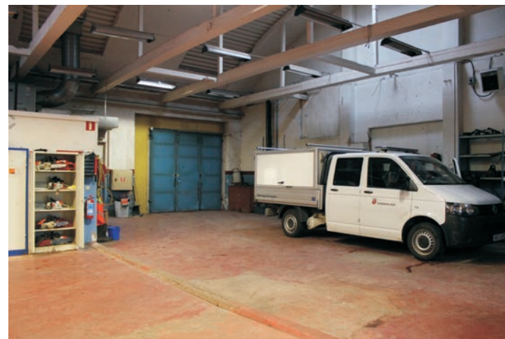
En av portarna inifrån. Den intressanta betongtakstolen har tidigare haft taklanterniner för ljusinsläpp.
