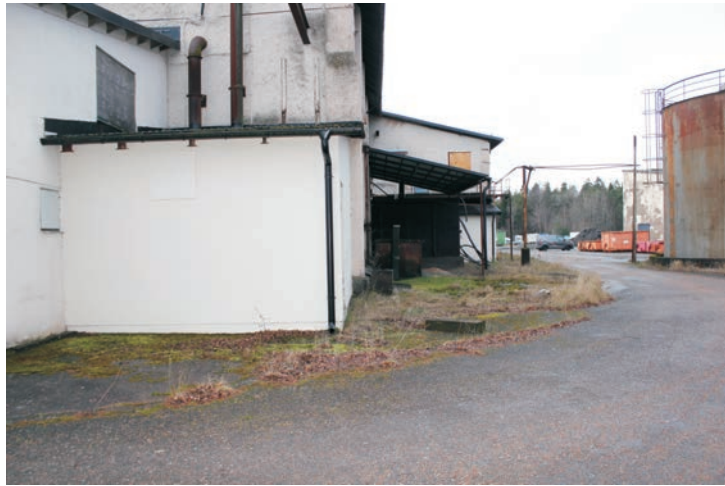
Ett skärmtak i plåt vid Martinverkets nordostfasad.
