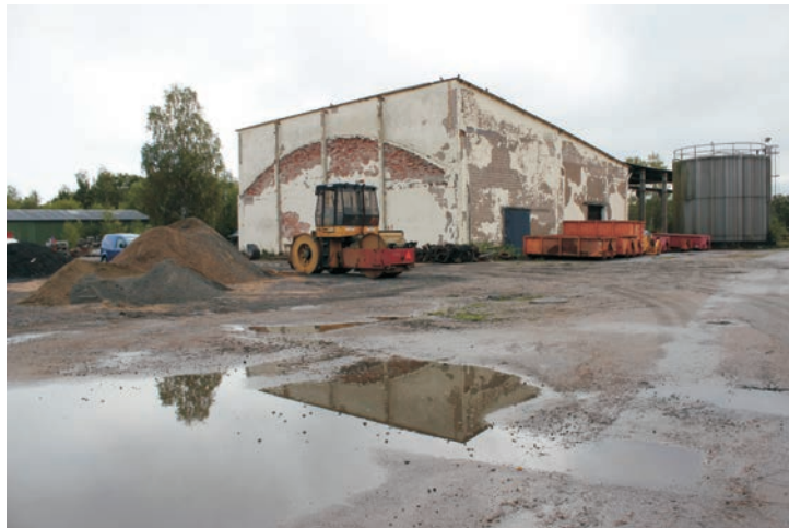
Uppfördes på 1960-talet och det har troligen varit ett gjuteri och valsverk på grund av byggnadens höjd. Väggarna är uppbyggda av betongblock och putsade på utsidan i ljus slätputs. På fasaden åt väst syns rester av den mekaniska verkstaden som troligen revs på 1990-talet.
