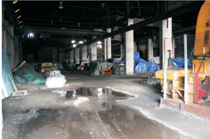
Inne i Martinverket finns en enorm golvyta, ett betonggolvtroligen. Takstolarna av järn var konstruerade av Fritz Söderbergs ingenjör-firma i Stockholm.
