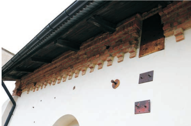
Den elegant mönstermurade takfoten på Värmecentralens utbyggda del från Martinverket.
