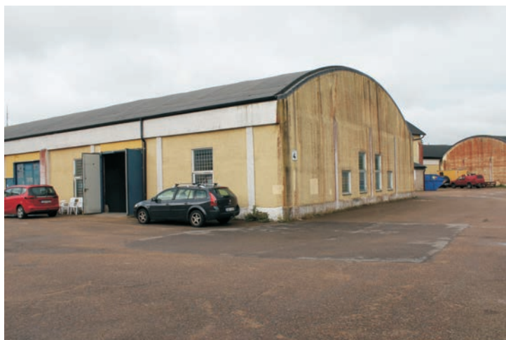
Den västra delen av den U-formade fabriken har såväl nyare portar som fönster i fasaden.
