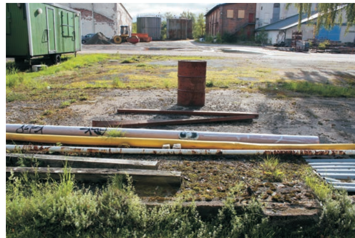
Rester från byggnadskroppars grundläggning.
