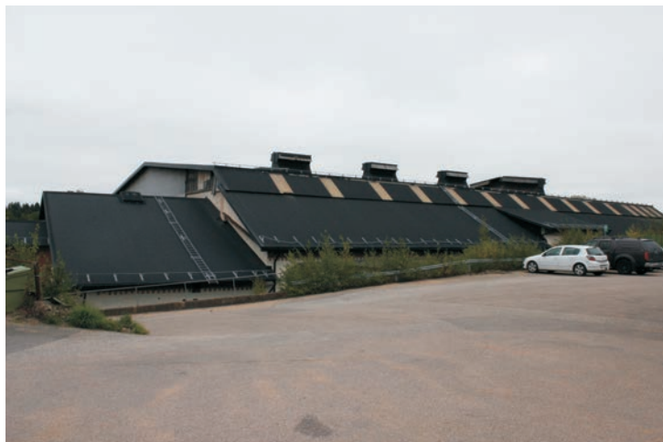
Här syns taket på Martinverket tydligt uppe ifrån Hyveljärnsfabriken's hylla.
