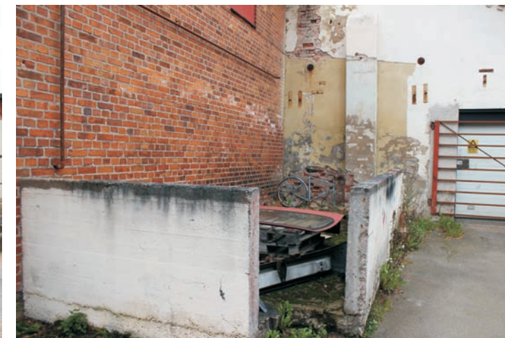
Ett betongfundament med betongväggar en bit upp. Oklart vilken funktion detta har haft. Rör sitter kvar på väggen.
