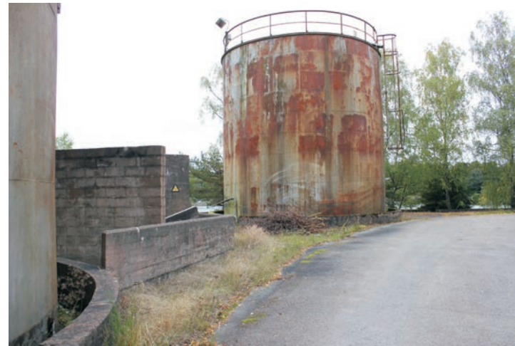
Oljecisternerna står på en betonggrund som sticker upp en bit över marken.
