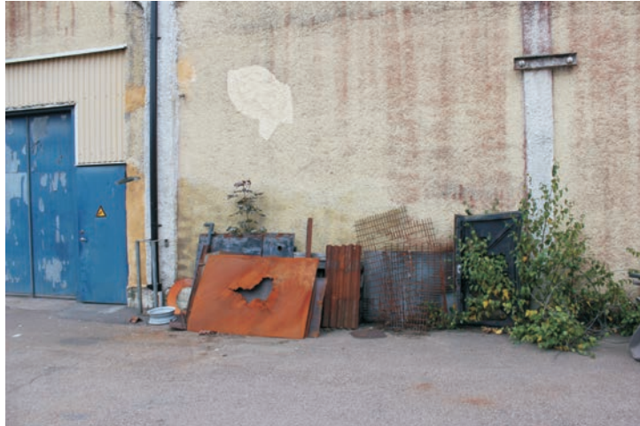
Lisener eller utskjutande fält i fasaden på byggnaden. Markerar ramverket av betong.
