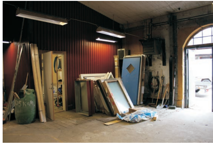
Den norra byggnadskroppen, med ingång från fabriksområdet, har även en inbyggd kontorsdel.. Vägg av plåt och enkla dörrar. Originalfönster över dörröppningen mot den lilla gårdsmiljön ger ett fint ljusinsläpp.
