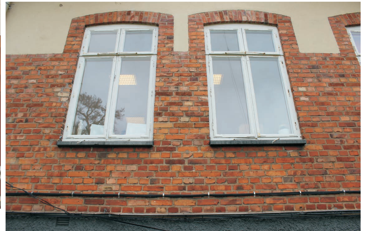
Fönstren i första våningen förefaller vara bevarade.
