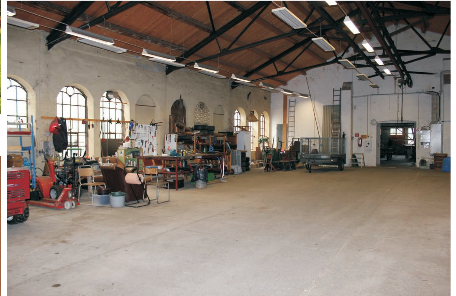
Industrihallen i den södra byggnadskroppen har stora ytor. Golvet är idag betong. Taket i trä med takstol i järn. Några av de rytmiskt återkommande fönsteröppningarna har murats igen. Taket är utbytt
