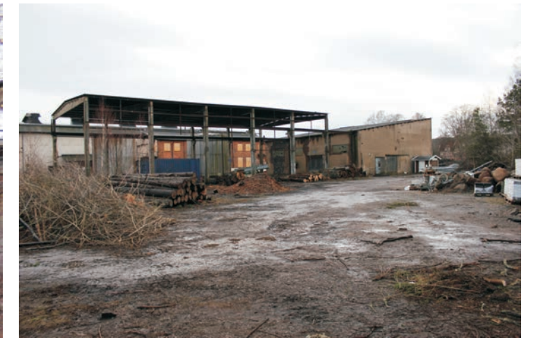
Från hörnet bakom Sägverket skymtar Kontoret till höger och Personalbyggnaden/Laboratoriet syns i mitten av bilden, liksom Valsverket.
