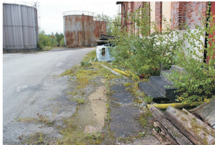
En slags lucka i marken vid laboratoriet/personalbyggnaden.
