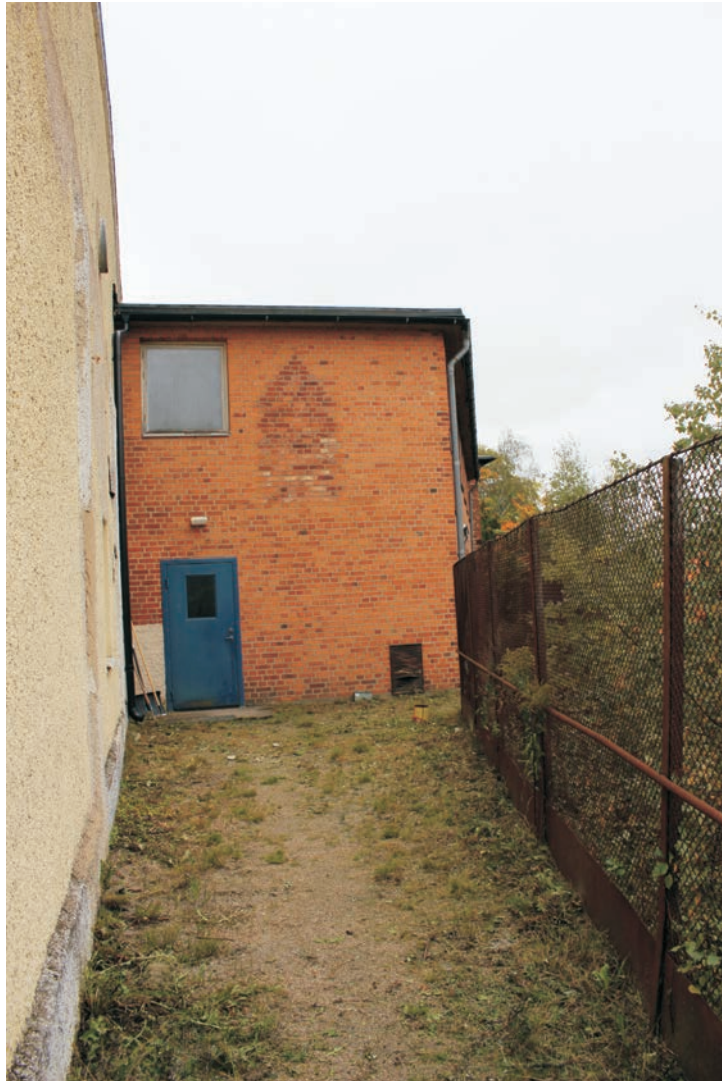
Personalbyggnaden från 1960-talet på baksidan mot järnvägen.
