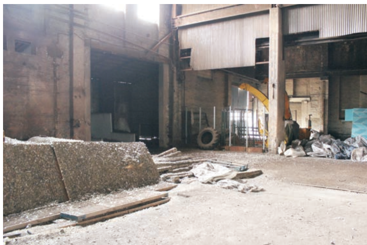
Martinverkets interiör åt sydost.
