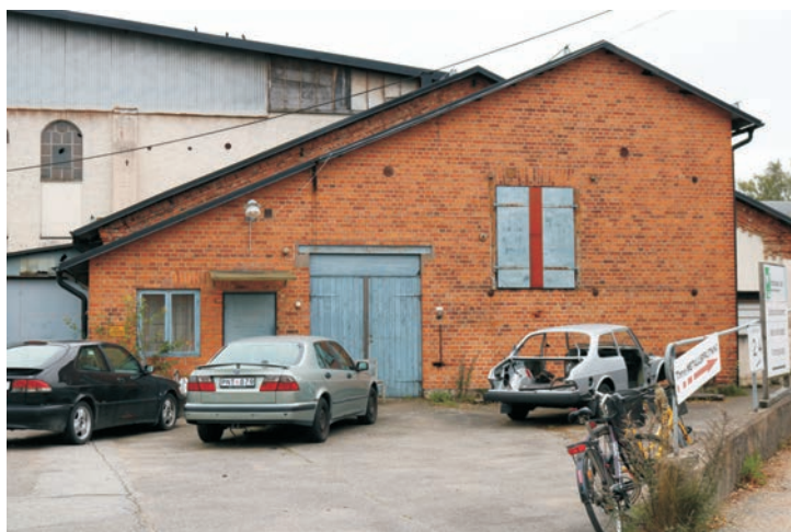
Värmecentralen från 1940-talet har röda tegelväggar och betonggrund. Sadeltaket är belagt med svart plåt. Dörrar och fönster kan mycket väl vara i original. Byggnaden har fått lite lustiga proportioner genom att sadeltaket inte fortsätter till höger.
