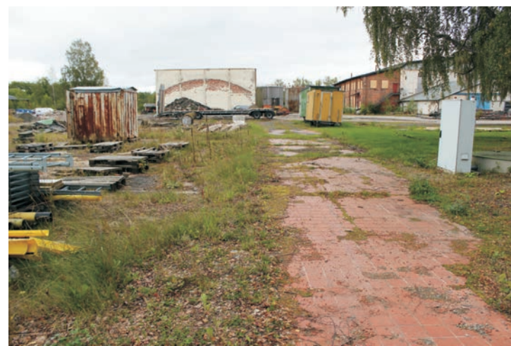
Spår från golvläggning vid byggnaden för den Mekaniska verkstaden.
