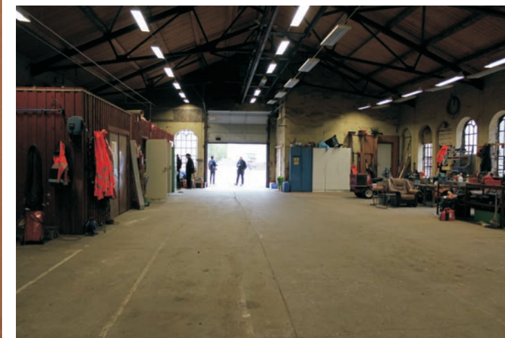
Industrihallen i den södra byggnadskroppen inifrån och utåt. Mot den vänstra långväggen finns platsbyggda kontorsutrymmen uppförda i trä, reversibla till sin karaktär. I det högra hörnet vid utgången finns ett mer permanent uppfört förråd/kontor.
