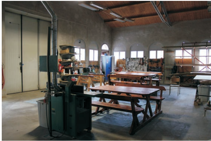
I den sydöstra byggnadskroppen finns en större port österut. Här har fönstren fått innanfönster och väggarna är putsade i grå ton. Golvet är ett betonggol. Även detta tak är utbytt och ej i original. Här är innertaket i trä med takstol i järn.
