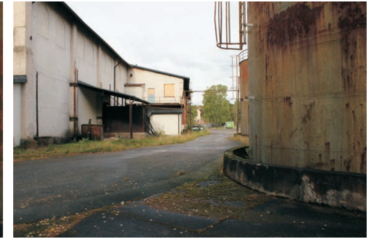
Närmare älven dominerar Martinverkets höga fasad och oljecisternerna blicksfältet. I bakgrunden syns delar av Kontoret.
