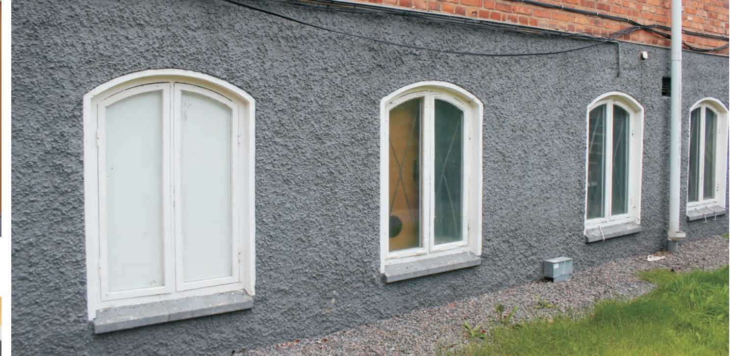
Några av fönstren i bottenvåningen har kvar sina ursprungliga fönsterhakar.
