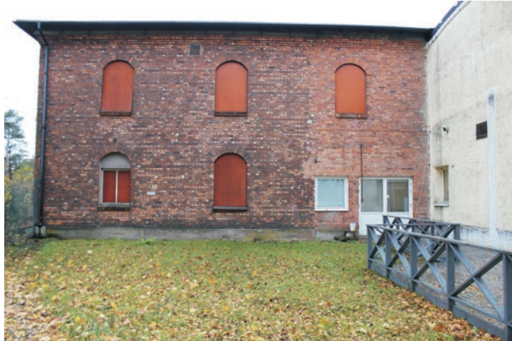
Transformatorbyggnadens fasad åt sydost. Här har personalbyggnaden utgång till en uteplats vid Göta älv. Fasaden i rött tegel med mönstermurning över de rundbågade fönstren och viss mönstermurning vid takfoten. Sockeln är i betong. Taket är belagt med papp.
