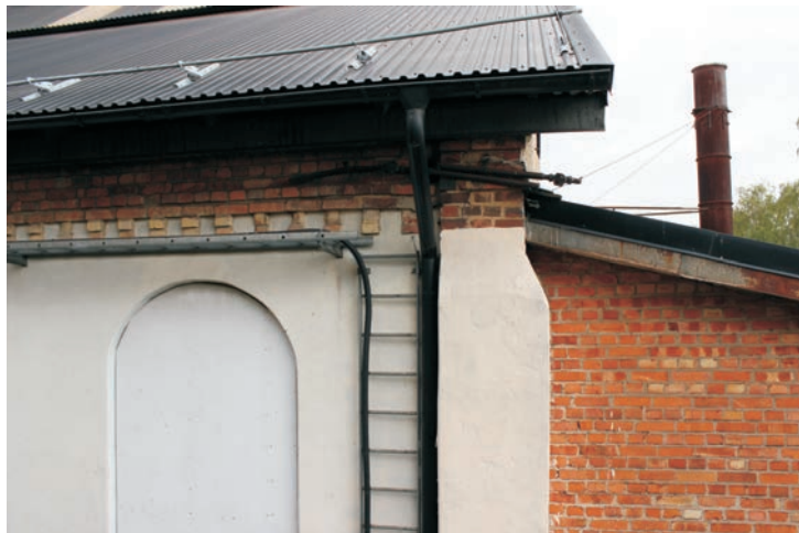
Mötet mellan Martinverkets fasad och en mindre utbyggnad mot sydost.
