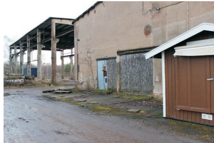
På den nordvästra fasaden finns två igensatta öppningar.
