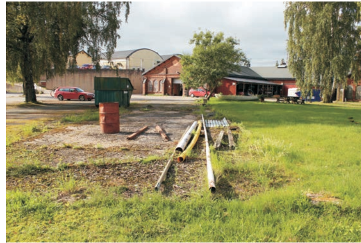
Inifrån områdets parklika plats skapas en rumslighet av byggnadens karakteristiska form. Den U-formade byggnadskroppen ramar in miljön.
