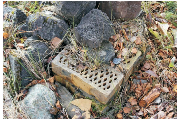
Högar med äldre byggmaterial och kasserad betong.
