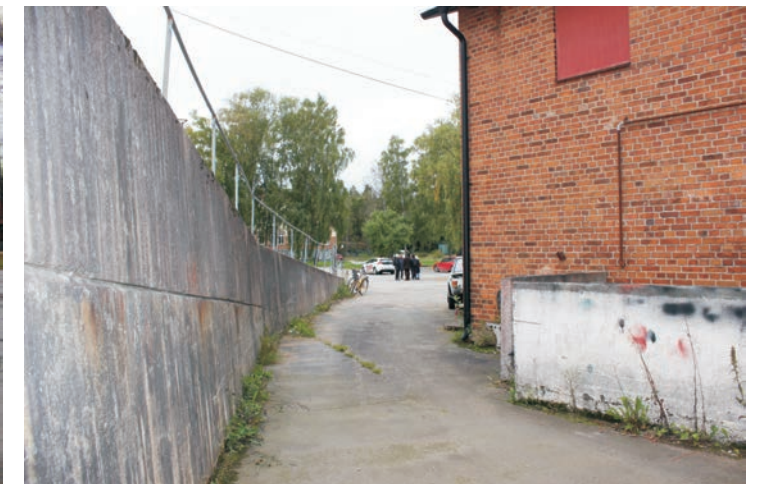
Gränden mellan uppfarten till Sägblads- och Hyveljärnsfabriken och Värmecentralen böjer spänningsfullt av och döljer ända till slutet vad som väntar runt hörnet.
