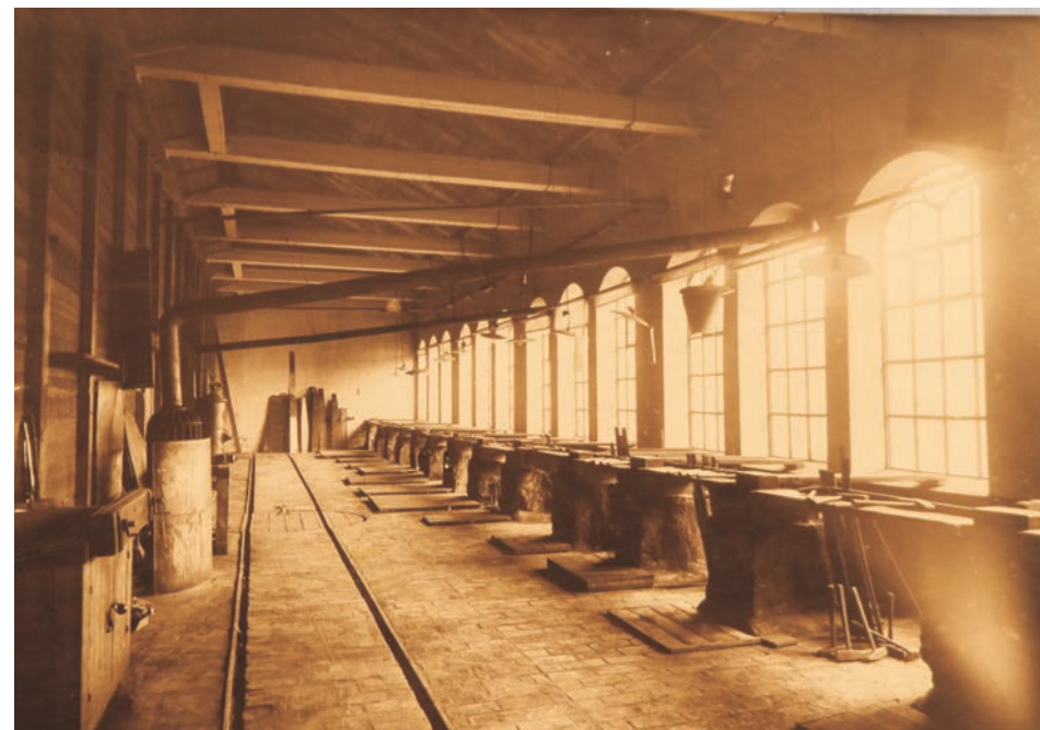
Fönsterband i Sägbladsfabriken.
