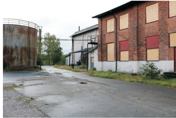
7. Längs Martinverkets fasader och den tillbyggda laboratoriebyggnaden sträcker sig en fabriksgata från områdets centrala delar i riktning mot älven. Resterna av det fd sågverket och cisterner ramar in stråket.
