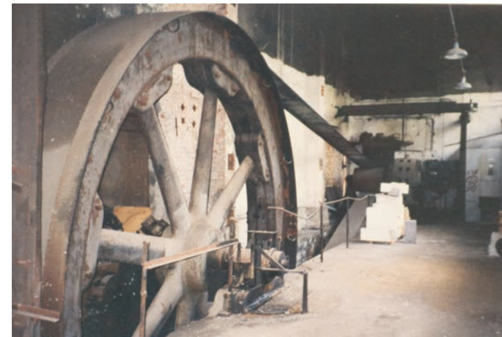
Svänghjulet i maskinhallen innanför Martinverket från äldre foto.
