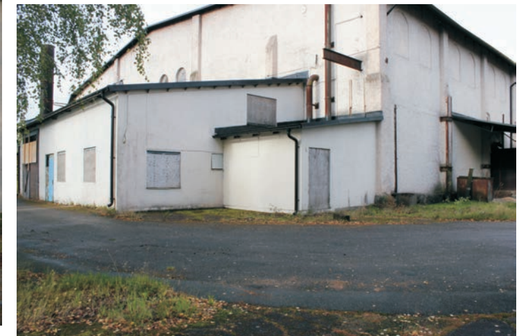
Martinverkets andra ände av sin sydostfasad har även en mindre påbyggnad intill det som kan ha kommit på 1950-talets slut. Här finns en liten utbyggnad på en ritning från 1949 så den kan troligtvis härröra från någon tid före denna tidpunkt. Som synes är alla fönsteröppningar igensatta.
