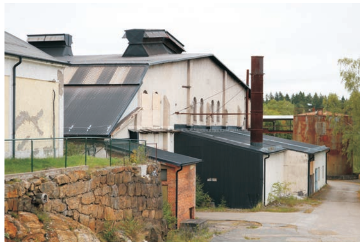
Några fönsteröppningar finns fortfarande kvar och de är mycket lika Filfabrikens fönster. På taket finns någon typ av ventilationsöppningar kvar. Få av takets lanterniner är bevarade. Det var ursprungligen fyra långa taklanterniner över hela byggnadens längd men idag finns bara några få taklanterniner bevarade i mindre skala.
