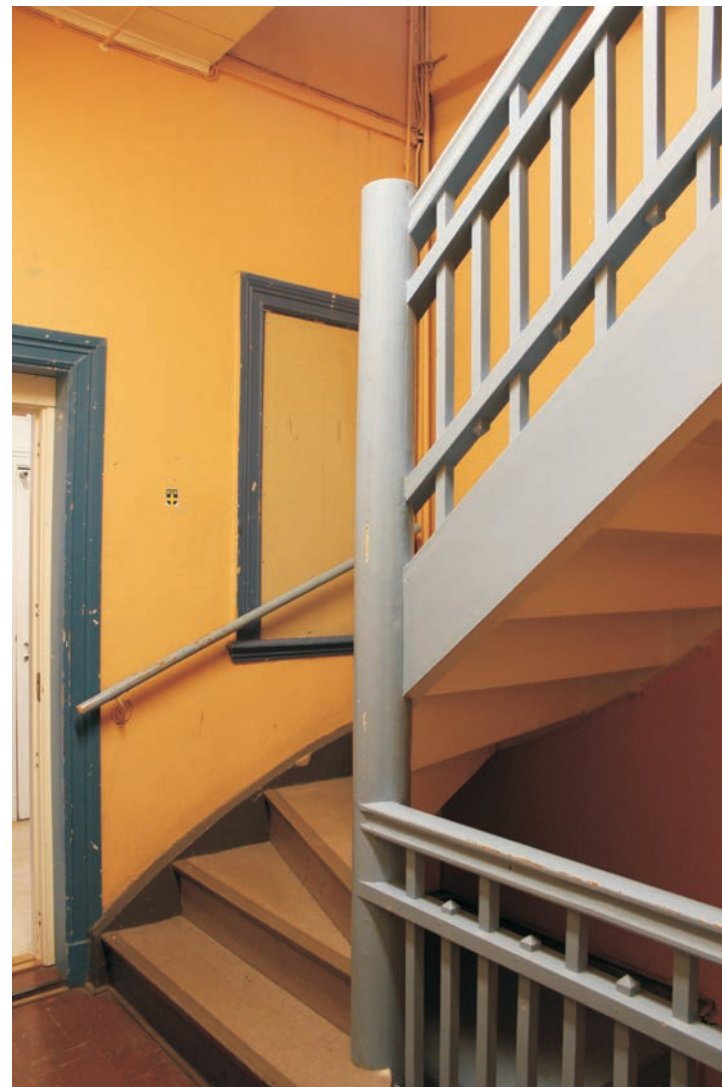
Trapphus mellan våning ett och två.
