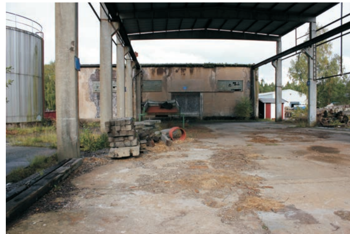
Sågverkstaket är klätt med plåt och utfört i betong.
