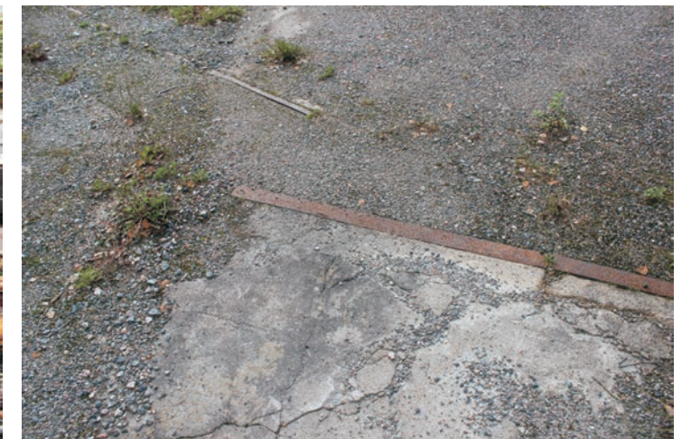
Gränser i metall vid byggnation av något slag.
