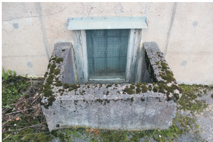
Fönstret med betongkonstruktionen framför.
