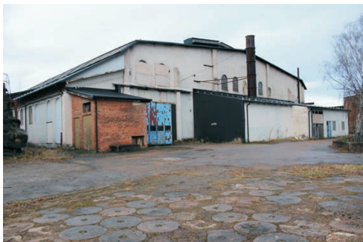
Martinverkets sydostfasad förefaller ha förlorat delar av sin tegelornamentik. Snedsträvbyggnaden för svänghjulet har den kvar. Sammanlagt sju ströpelare på den stora fasaden som är putsad i sin helhet. 1958 byggs en ny götugn och det är troligt att utbyggnaden vi ser idag med skorsten härrör från den tiden.
