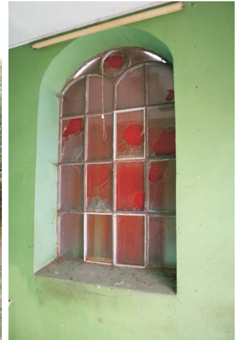
Här syns originalfönstren som är samma modell som de övriga i de äldre byggnaderna. De är järnspröjsade rundbågiga fönster.
