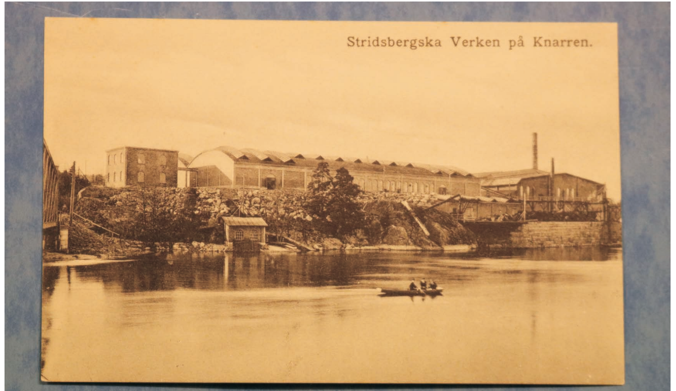
På det äldre fotografiet syns alla taklanterniner, men också tegelfasaderna, liksom de höga spröjsade fönstren och byggnader som har försvunnit eller byggts ut. I förgrunden ett pumphus. Transformatorsbyggnaden har ännu inte blivit klar.
