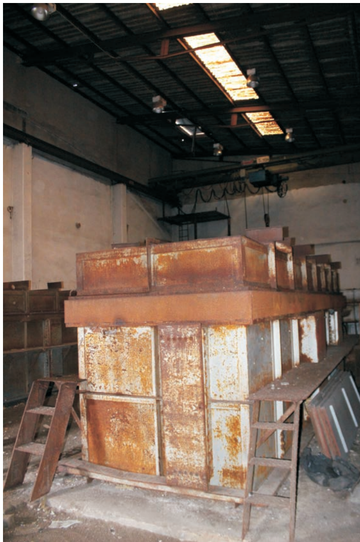
Här syns takfönstren som släpper in lite ljus ned på den kvarvarande inredningen.
