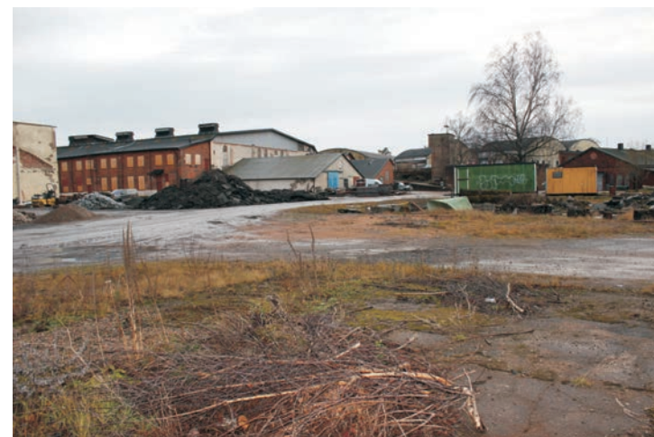
Utblick mot sydost visar hur Sägblads- och Hyveljärnsfabrikerna ligger högre än övrig bebyggelse.
