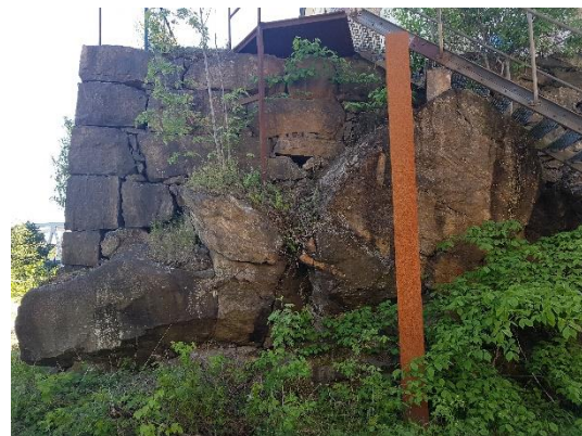
Mur 2 vid punkt B.
