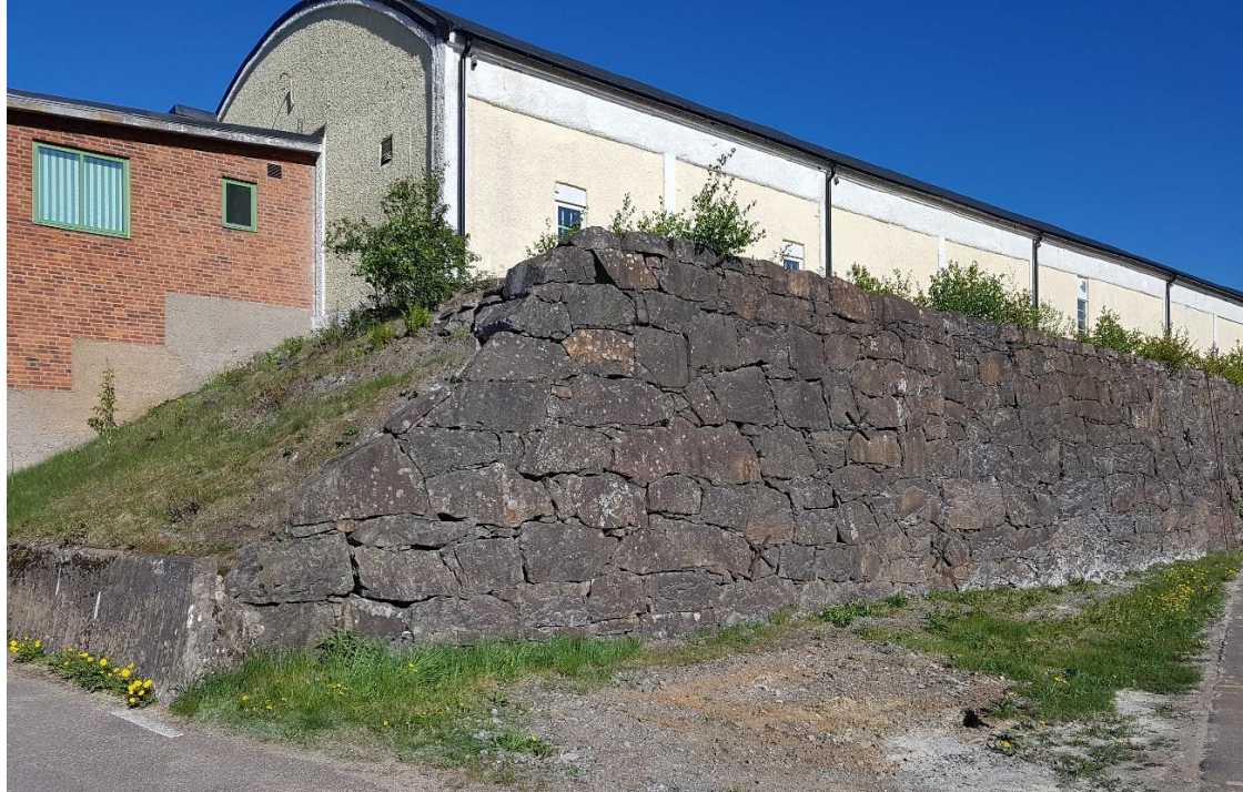
Översiktsbild över mur 1 från norr.
