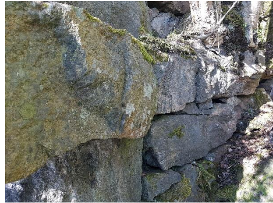
Bakmur i avslutning mot norr.
