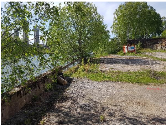
Räcke och betongmur.
