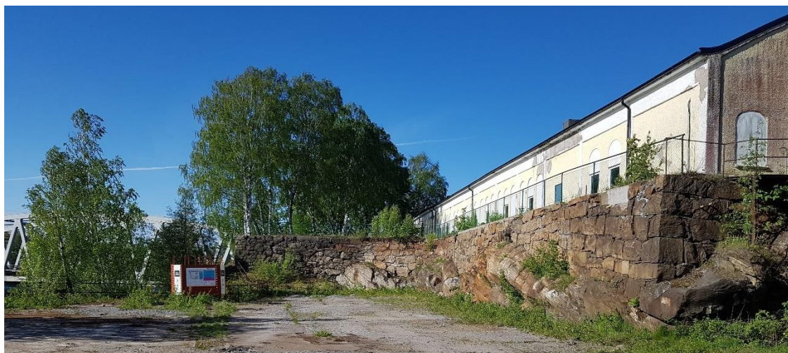
Översiktsbild över mur 3, stäcka B-D.
