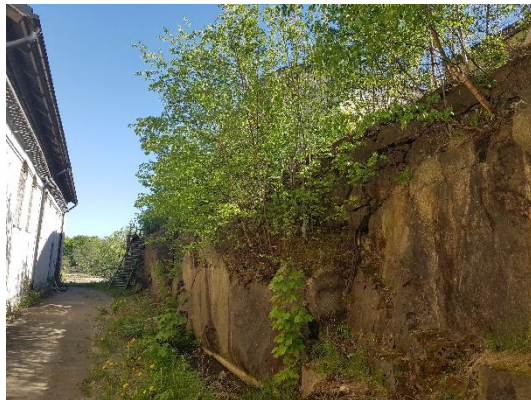
Översiktsbild över mur 2 vid punkt A.
