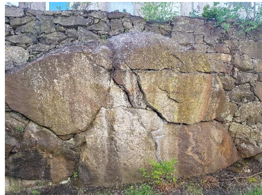
Sprickbildning och sättning i berg.
