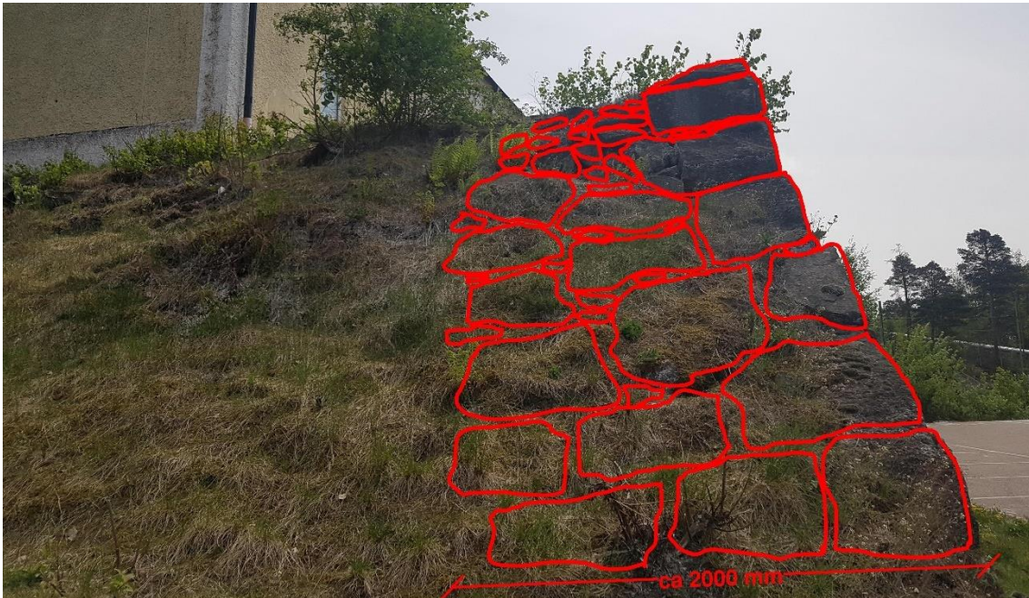
Principsektion av murens uppbyggnad utifrån bild på mur 1.
