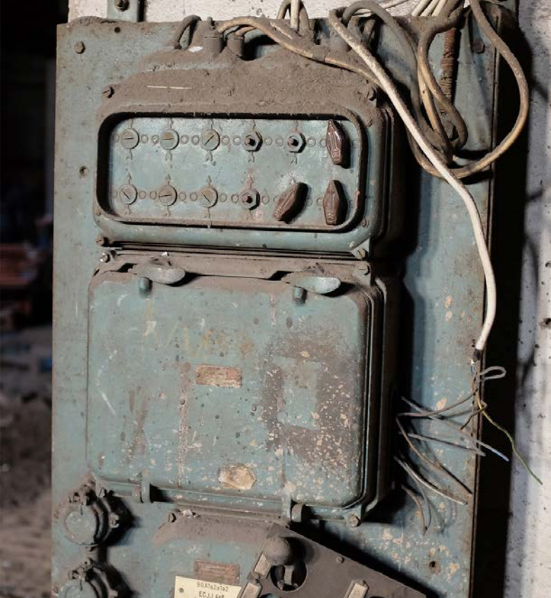
Bild 59. Detalj inifrån Martinverket.
