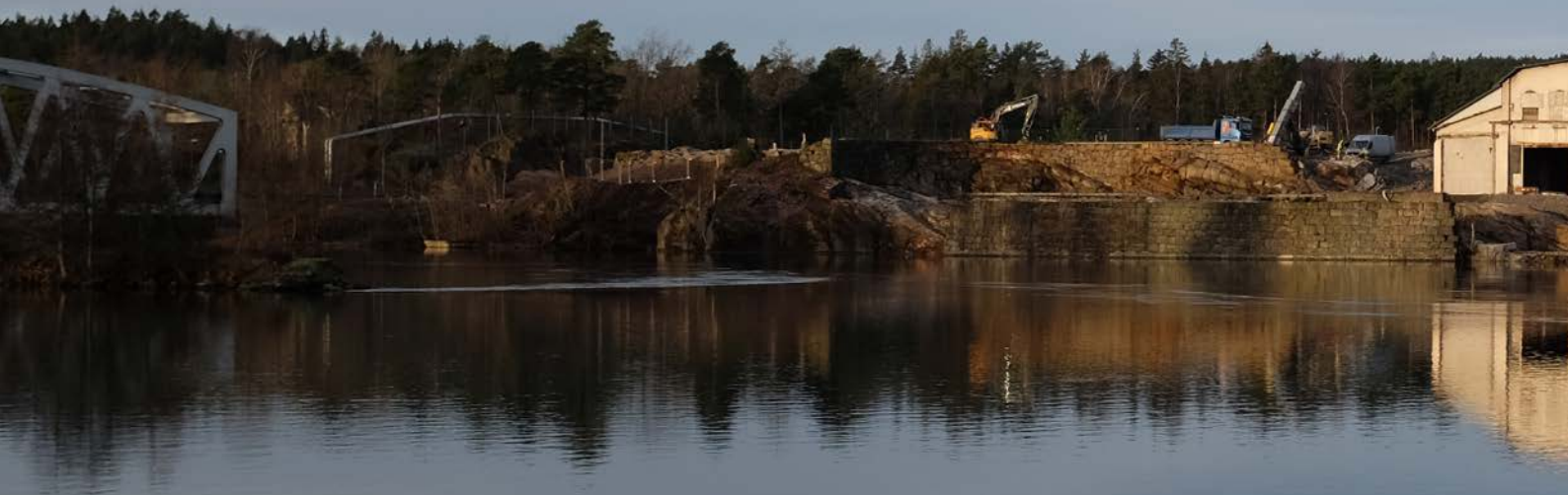
Bild 18. Vy över planområdet sett från andra sidan Göta älv under pågående saneringsarbete i början av februari 2020
