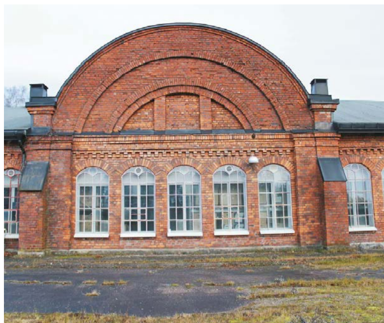
Bild 35. Del av filfabrikens fasad mot järnvägen. (Melica, 2018)
