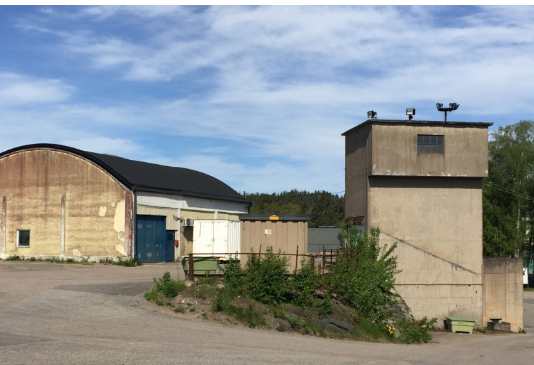
Bild 45. Hisstornet och del av Hyveljärnsfabriken (2019)
