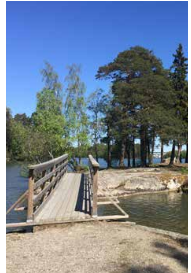
Befintlig bro ut till en liten ö
