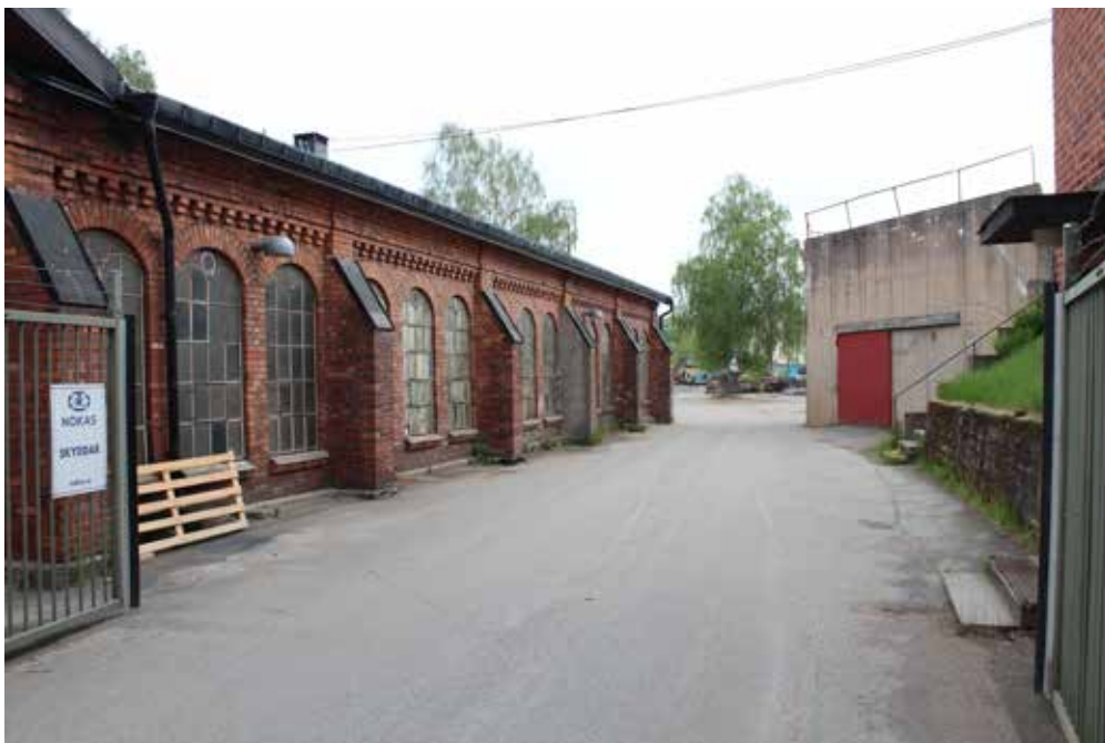
Entrén till Stridsbergsområdet med filfabriken till vänster och hyveljärnsfabriken till höger i bilden.
