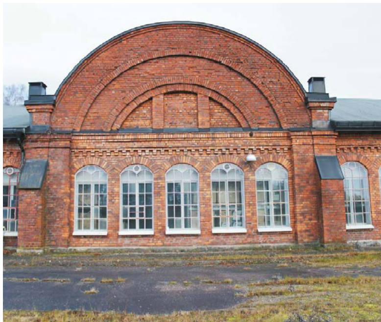
Bild 35. Del av filfabrikens fasad mot järnvägen. (Melica, 2018)
