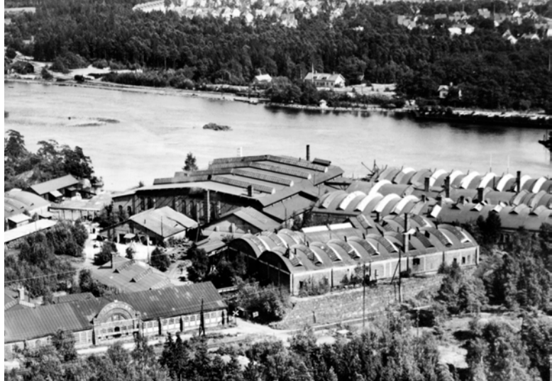
Bild 32. Byggnadernas gamla taklanterniner (Innovatums bildarkiv)
