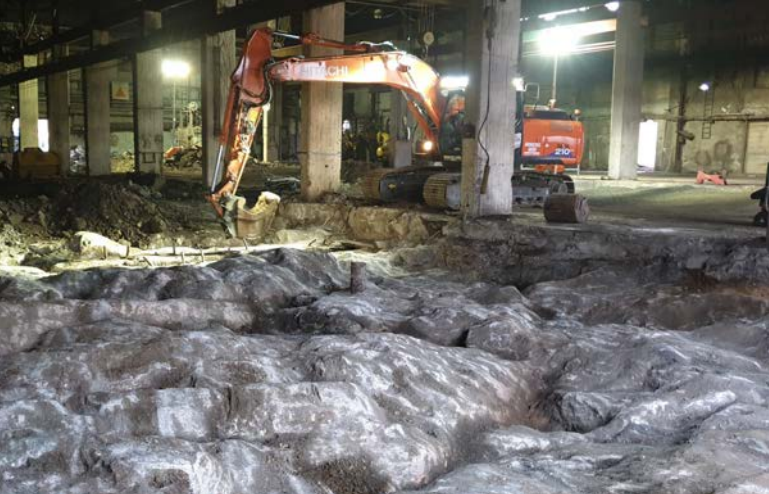
Bild 57. Pågående saneringsarbete inne i Martinverket. På bilden ses hur marken sanerats ner till berget. Rena massor läggs sedan på och till slut är tanken att gjuta ett betonggolv.
