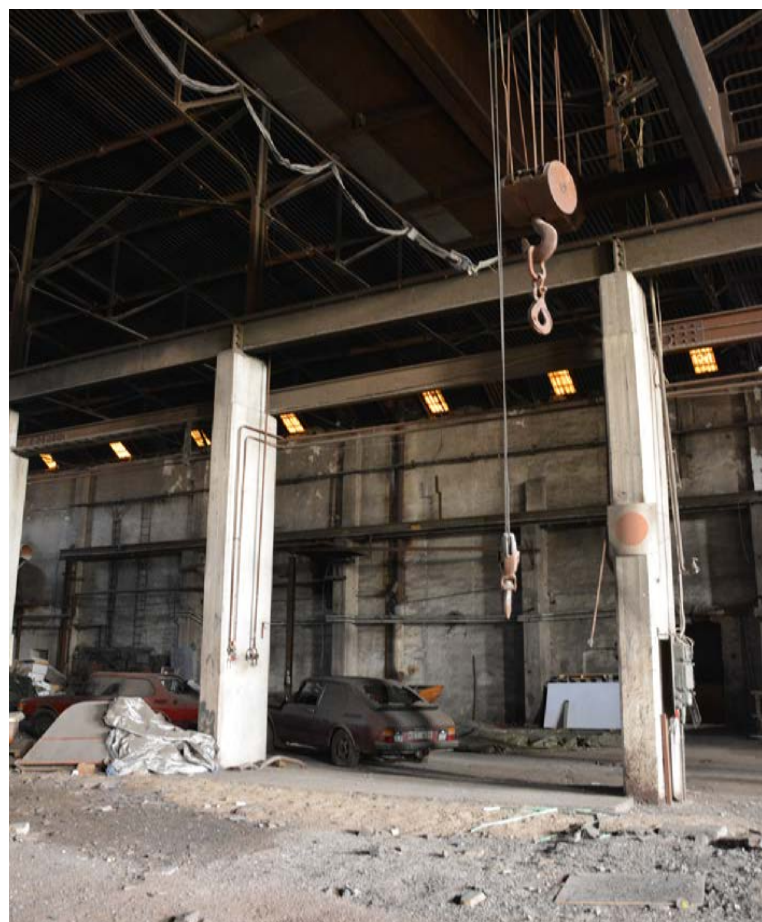
Bild 43. Traverser och interiöra detaljer i Martinverket (2017)
