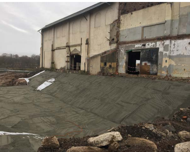
Bild 58. Pågående saneringsarbete längs Martinverkets långsida som vetter mot kommande brofäste. På bilden ses hur marken återställs, först genom geotextil (vita ytor som skymtar) och sedan rena massor. Marken kommer återställas till att ungefär bli i nivå med Martinverket.
