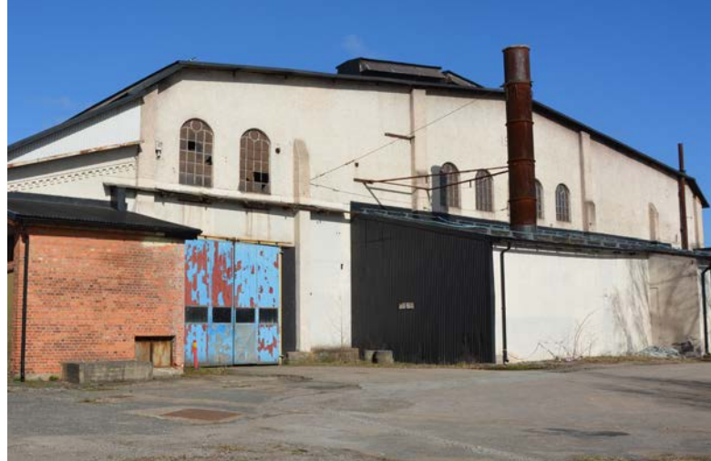
Bild 41. Martinverk, fasaden mot älven (2017)
