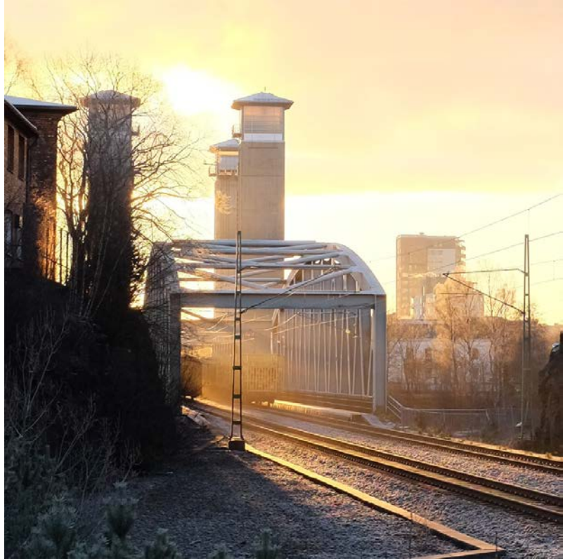
Bild 54. Tågbron. Nu rivna industribyggnader skymtas i bildens vänsterkant.
