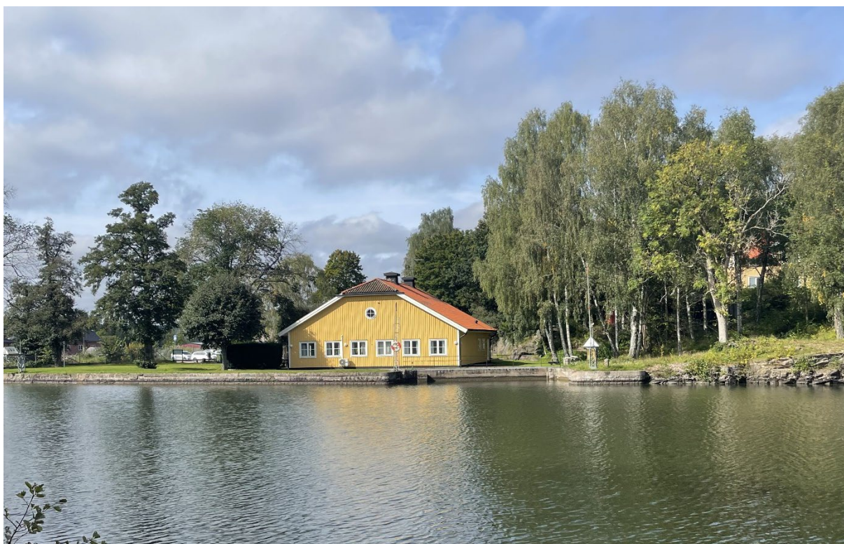
Figur 42. Vy från dragvägen, på andra sidan Bergkanalen, som visar byggnad på Olidan 4:9.
