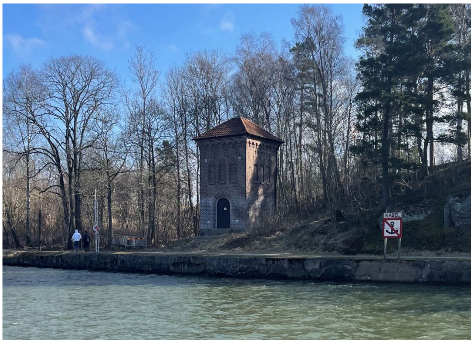
Figur 34 Transformatorstation på Olidan 4:8 från tidigt 1900-tal
