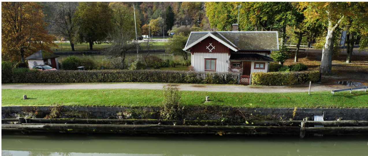
Figur 36 Vaktbostäderna vänder sig mot kanalen. Låga häckar ramar in bostädernas trädgårdar, men skärmar inte av dem från kanalmiljön. Här syns vaktbostaden vid Klaffbron med en utformning som var gemensam för kanalbolagets byggnader under sent 1800-tal och tidigt 1900-tal. Dessa bostäder är oerhört betydelsefulla för förståelsen av den historiska slussmiljön.
