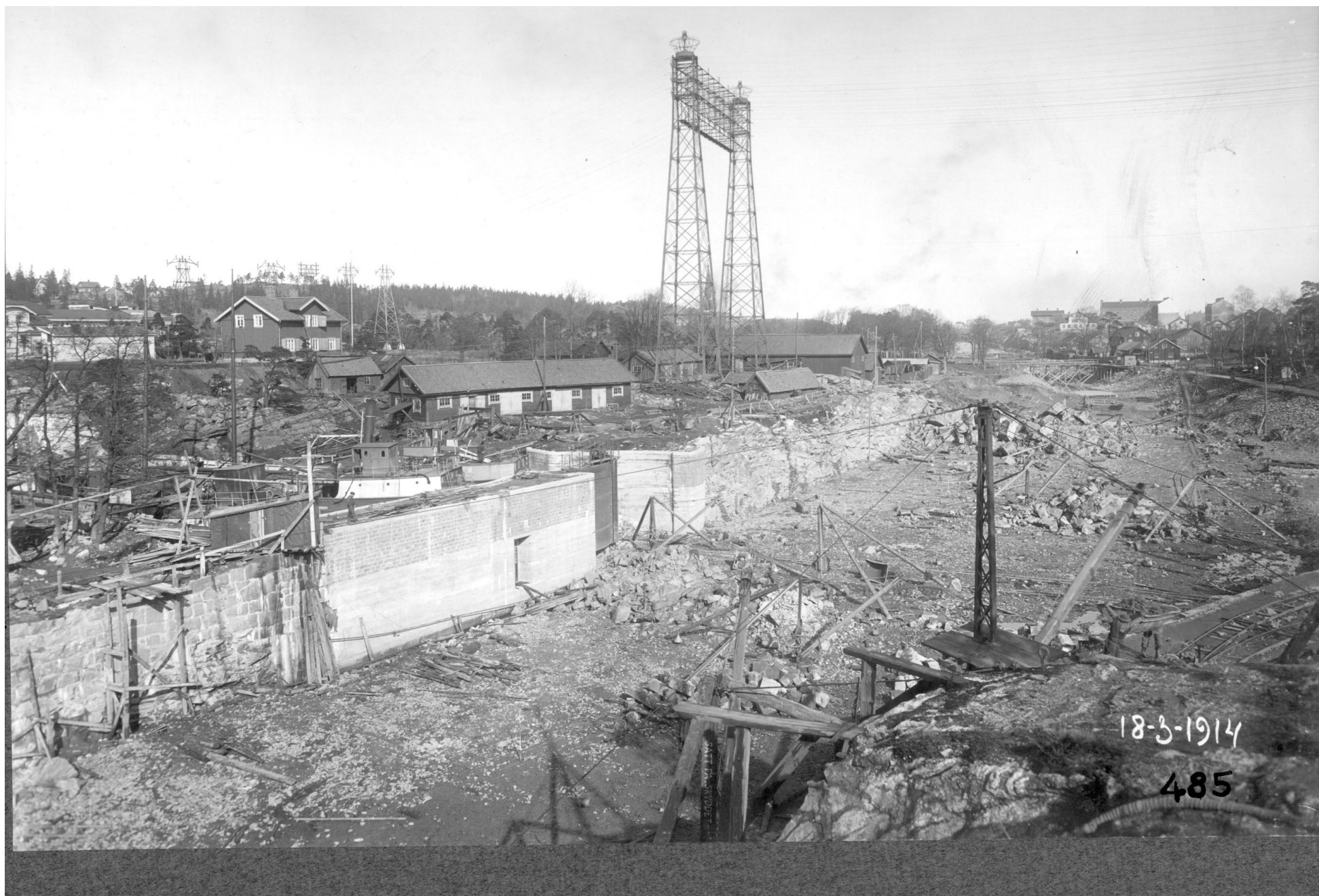
Figur 58 Bergkanalen under byggnad 1914. Här syns konstruktionen av dockan och dess murar som skiljer sig från de övriga kanalmurarna. Sjöfartsverket
