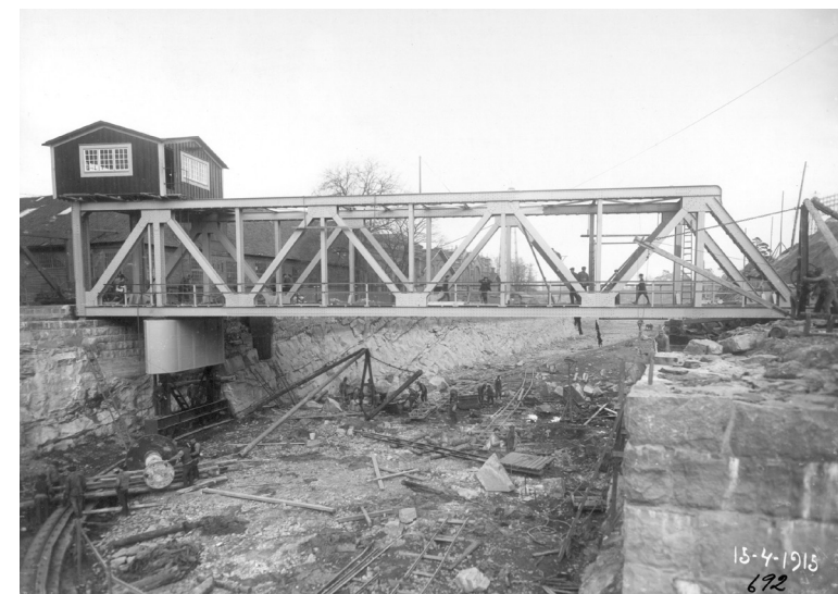
Figur 12 Konstruktionen av Nohabs nya understödda svängbro för tunga järnvägstransporter närmar sig färdigställandet år 1915. Sjöfartsverket
