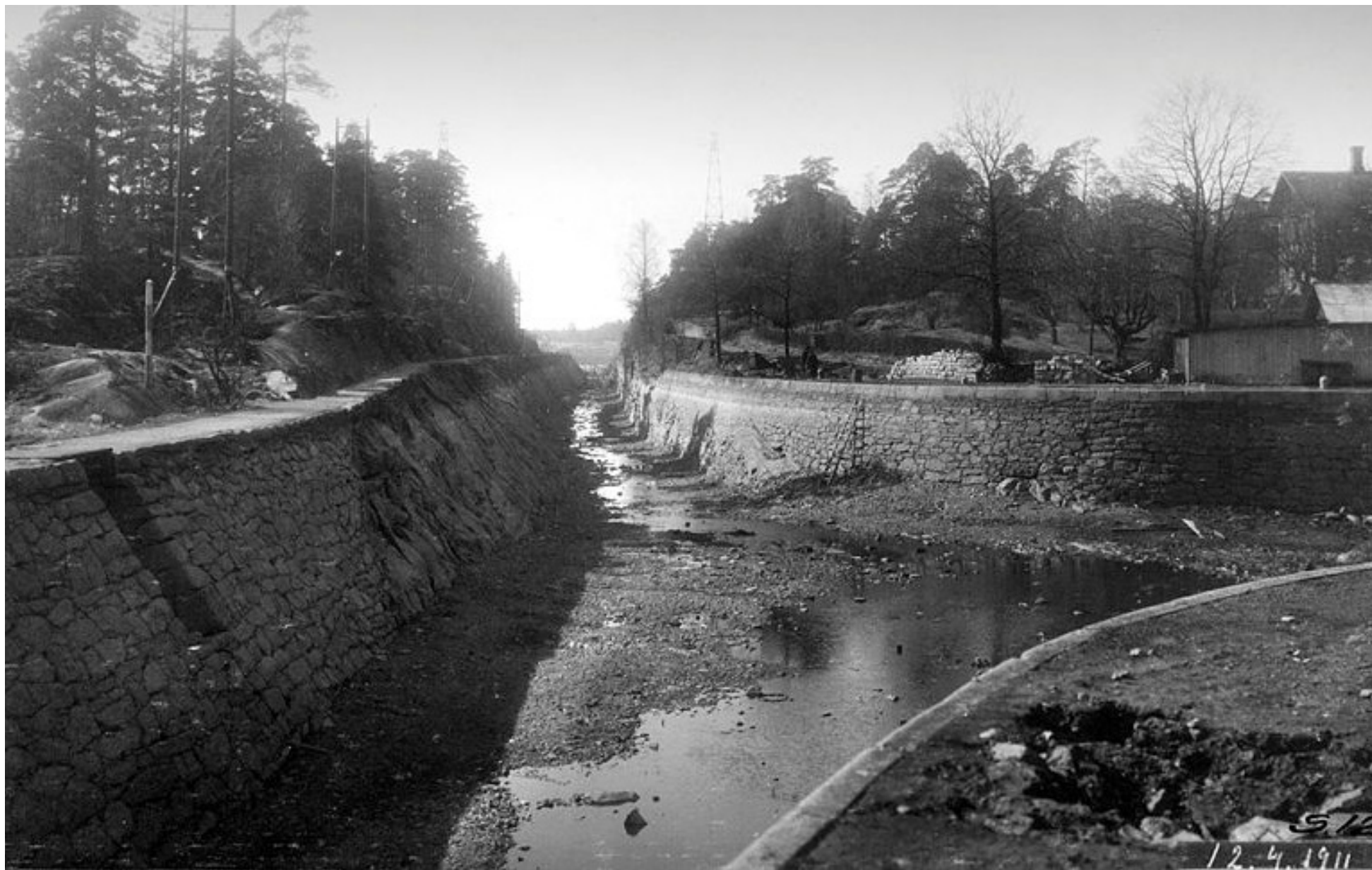
Figur 51 Vy av gamla bergkanalen sedd mot söder vid Olidebassängen, före 1910-talets breddning. Olidans gård längst till höger, foto från 1911. Sjöfartsverket
