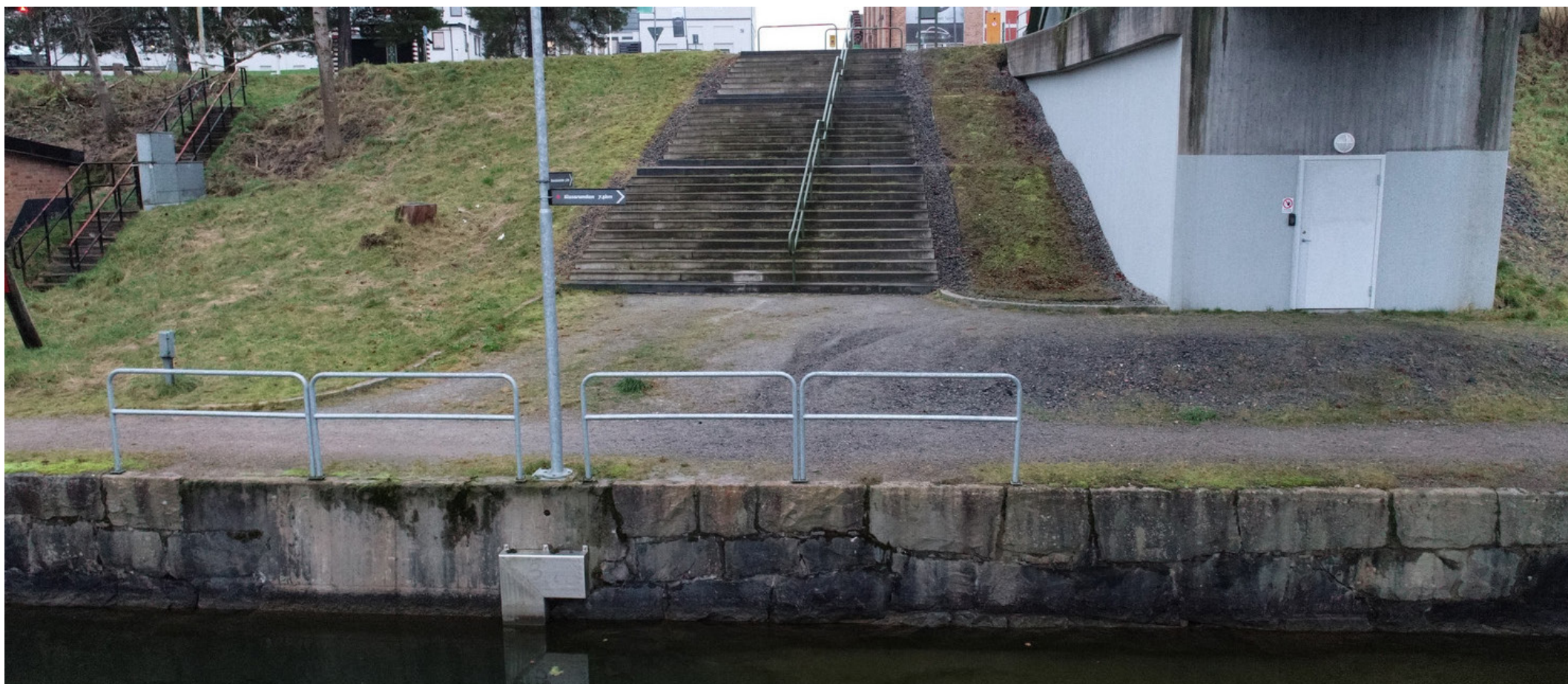
Figur 67 Överst t.h. mindre teknikbyggnad med traverskran från ca 1930-1950 som hört till Vattenfalls verksamhet. Stor bild nederst: dragvägen vid Olidebrons östra landfäste med trappan som leder ned till vägen. Även här finns lagningar i muren med betong. Modernt räcke och stolpe har satts upp som inte är anpassade till kanalmiljön i övrigt. Bron kommer att demonteras i samband med byggnationen av den nya Västergärdetbron men trappan bibehålls.
