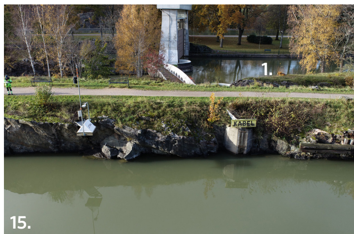
15. Söder om Klaffbron - bergskärning Nuläge: Kanter av bergskärning, avbärare av trästockar. Kabelanordning i betong
