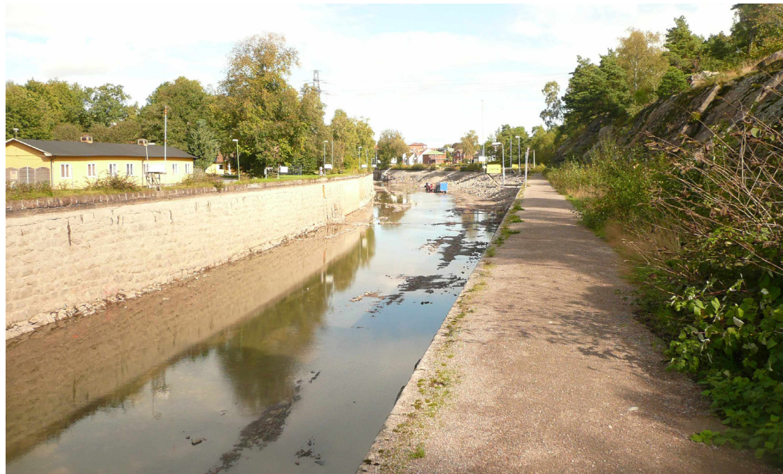
Figur 55 1916 års vertikala kantmurar utmed kanalens västra sida i riktning mot dockan. Dessa murar på västra sidan kommer att försvinna då inloppet till nya slussen läggs här. Dragvägen, till höger i bild berörs inte av breddningen.
