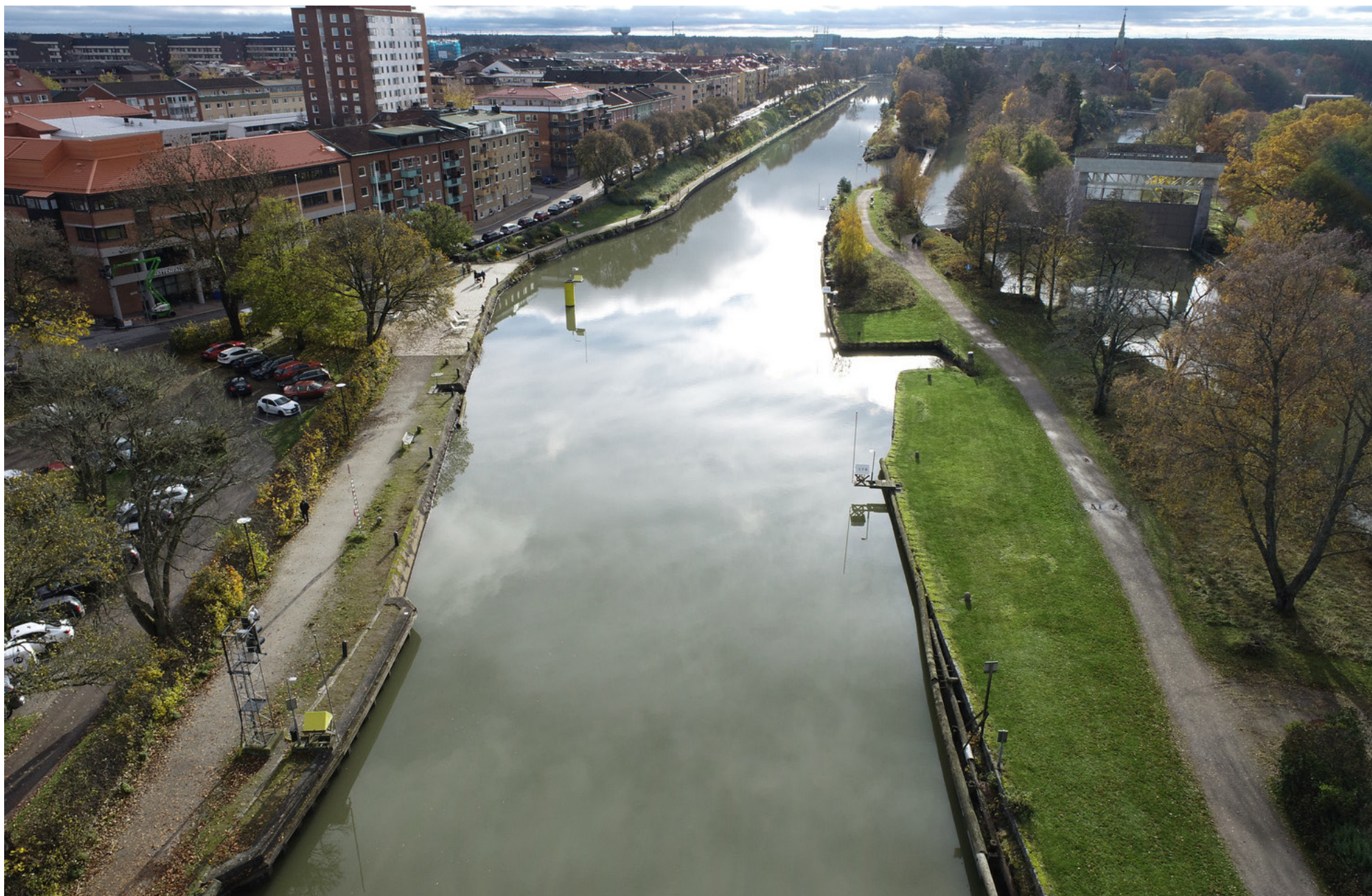
Figur 47 Drönarfoto. Bergkanalen mot söder från området vid Klaffbron. Till vänster dragvägen som längst norrut genomgått vissa förändringar. Till höger promenadvägen och parkmiljön utmed kanalen. Nederst till höger anas brovaktbostadens trädgård. Det tidigare inloppet till bolagskvarnen är en tydligt framträdande struktur och längre söderut viker den gamla kanalsträckningen från 1800-talet av och fortsätter väster om Kanalön in mot kyrkan. Här syns även hur promenadvägen löper över den smala norra banken.
