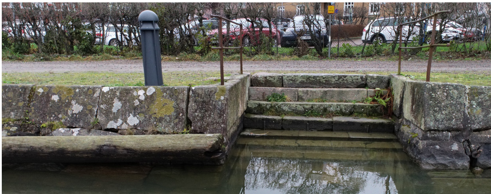
Figur 72 Inom sträcka 31. Här finns äldre välbevarade kanalmurar kvar. Den trappa med järnräcke som finns bevarad är en detalj viktig att slå vakt om, liksom den välarbetade kanalmuren. Muren bevaras då sträckan inte påverkas.
