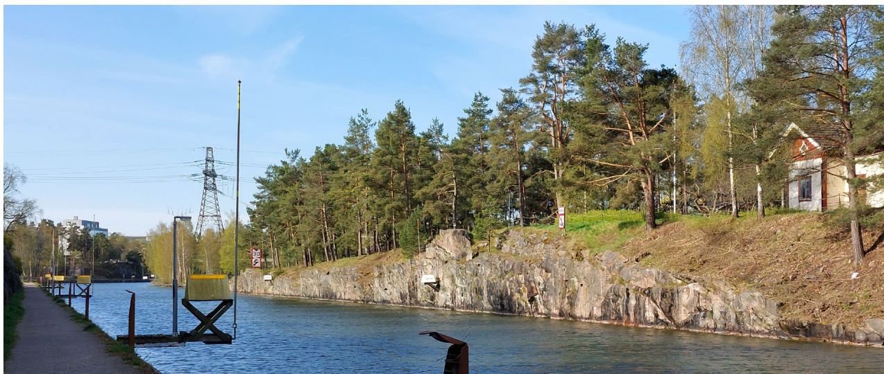
Figur 32 Utmed Kanalön utgörs kanalens kanter huvudsakligen av bergskärning.
