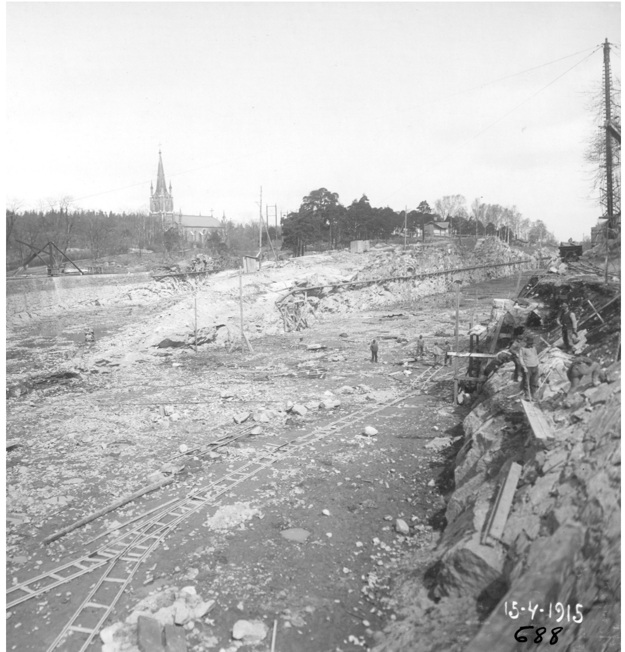
Figur 61 Bergkanalen anläggs 1915. Fotot visar bergskärningen och Kanalön som skapades genom den nya dragningen av Bergkanalen. Vaktbostaden ligger väl synlig på den nya ön.
