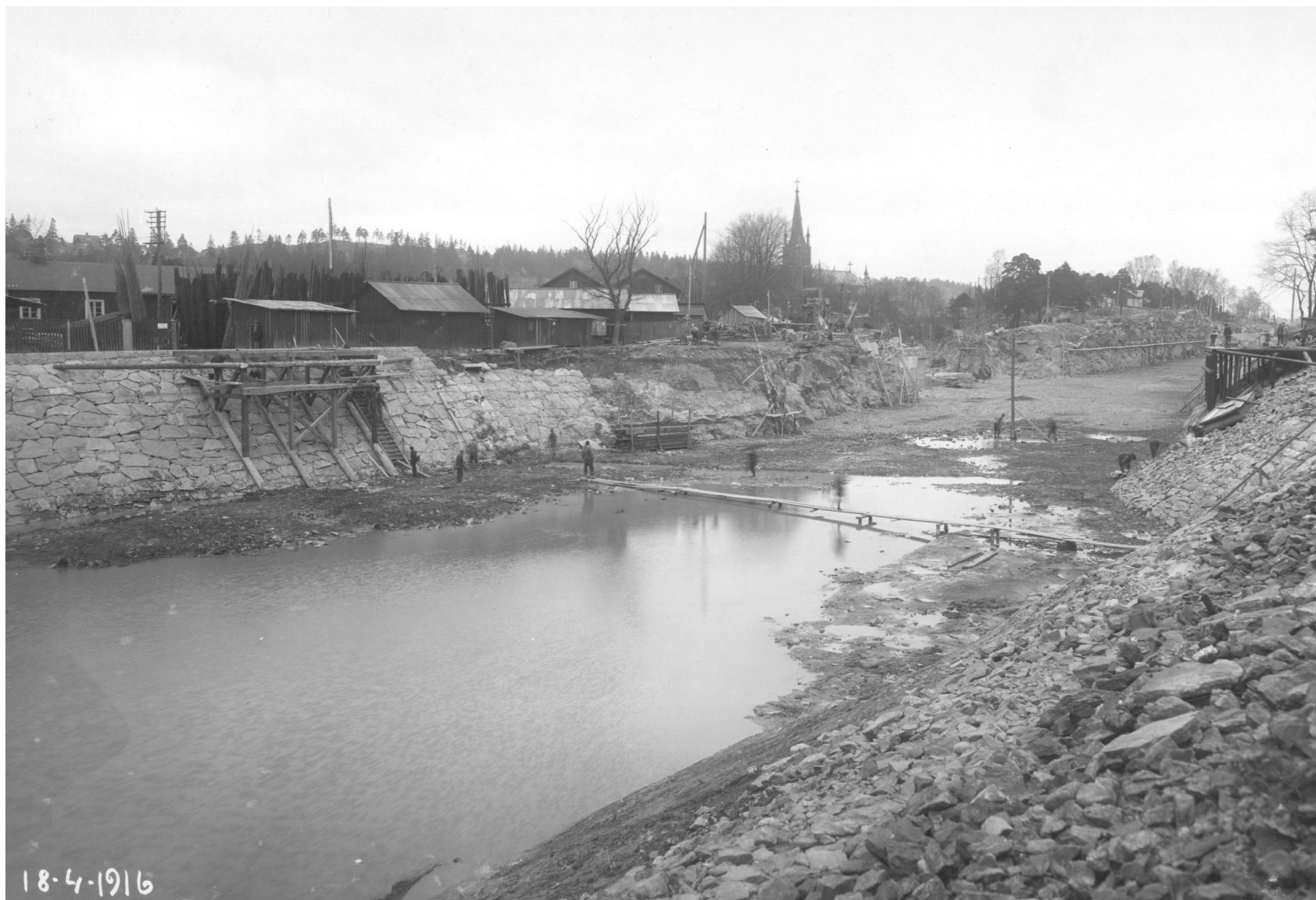
Figur 59 Bergkanalen under byggnad med glacismur i området strax söder om Kanalön. Den Södra Banken mot gamla Bergkanalen har ännu ej byggts. Sjöfartsverket.
