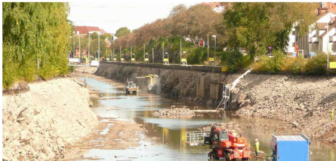
Figur 25 Dragvægen utmed Österlånggatan då kanalen var tömd. Till höger tar resterna av den ursprungliga glacismuren vid. Den närmaste dragvægdsdelen med betongförstärkningar påverkades under 1970-talets arbeten och har återuppbyggtts med hjälp av armeringsjärn som kramlor.
