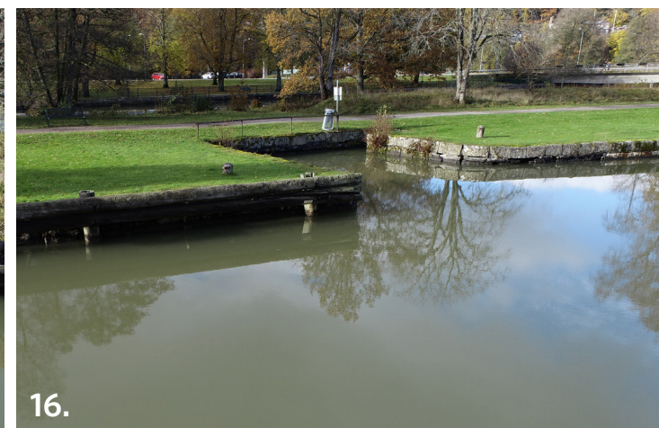
16. Söder om Klaffbron - Vid f.d. inloppet till bolagskvarnen Nuläge: Söder om inloppet: Kantskoning av betong. Själva strukturen av inloppet har en äldre välbevarad stenskoning och trappa med smidesräcke. Norr om inloppet finns en stenskoning med svängd form.
