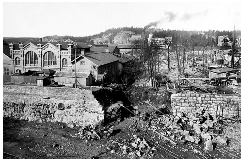
Figur 19 Breddning inför 1916 års Bergkanal. Murning pågår mellan Dockan och Nydqvist & Holms numera rivna verkstad. Foto: Annie Wallén år 1914. Innovatum.
