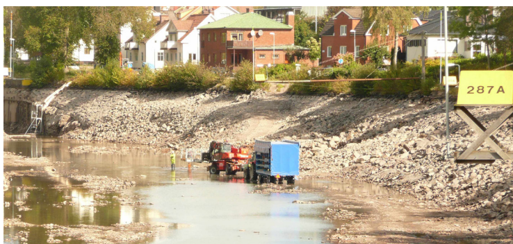
64 Figur 68 Foto från tömd kanal. Den ursprungliga glacismuren har bibehållit sin form men är till stor del raserad.
