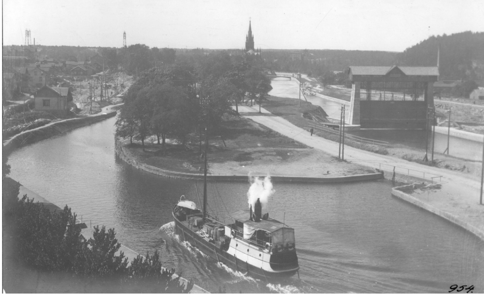
Figur 14 Fotot är taget från en plats i närheten av Klaffbron en kort tid före bygget av 1916 års Bergkanal. Kanalkanterna kring inloppet till bolagskvarnen var redan före breddningen stenskodda. Hamnvaktbostaden på bilden hade ännu ej flyttats från östra sidan av kanalen till sitt nuvarande läge. Sjöfartsverket
