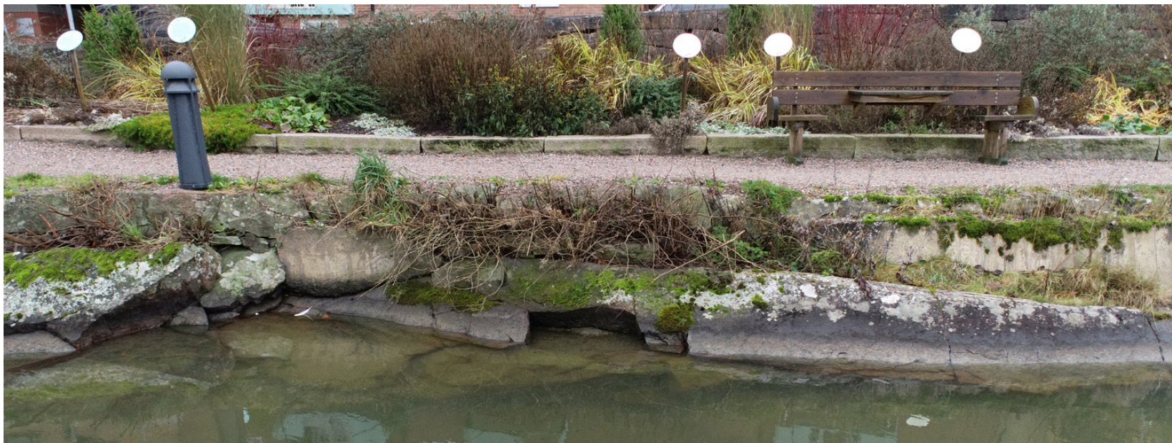
Figur 70 Inom sträcka 30 finns en parkanläggning utmed kanalen. Promenadvägen löper utmed parken. Strandskoningen är här av blandad karaktär med större stenblock, murdelar och betongkanter. Sannolikt har kanten tillkommit i samband med tidigare breddningar på 1970-talet.
