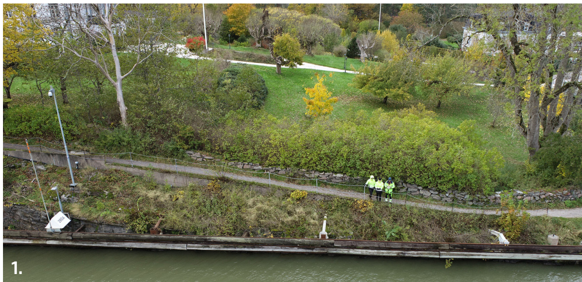
1. Bergkanalen söder om Olidebassängen Nuläge: Där den nya anläggningen ansluter mot befintlig kanal, utgörs kanalkanten av bergskärning, och ovanpå den en slänt. Avbärare i trä täcker bergskärningen. Nära Olidebron vidtar murar, sannolikt från 1800-tal. Det är främst murkrönen som syns ovan vattenytan.
