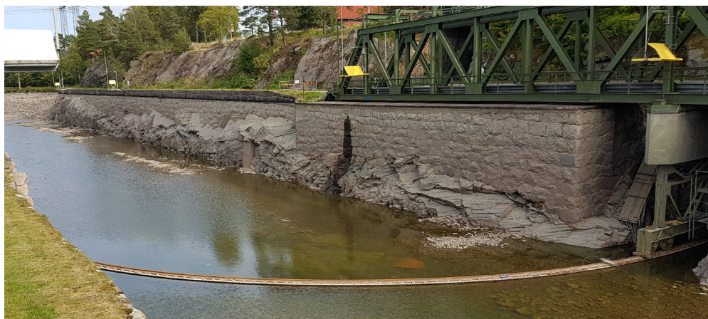
Figur 64 Bergkanalen mot norr i höjd med NOHAB:s svängbro med dragvägen till höger. Fotot är taget då kanalen var tömd vilket gör att murar och berg under ytan är synliga. I fonden längs till vänster anas ett parti av kanalen där dragvägen är borta och där kanalanten består av av krosslänter som enligt uppgift från Sjöfartsverket tillkom på 1970-talet.
