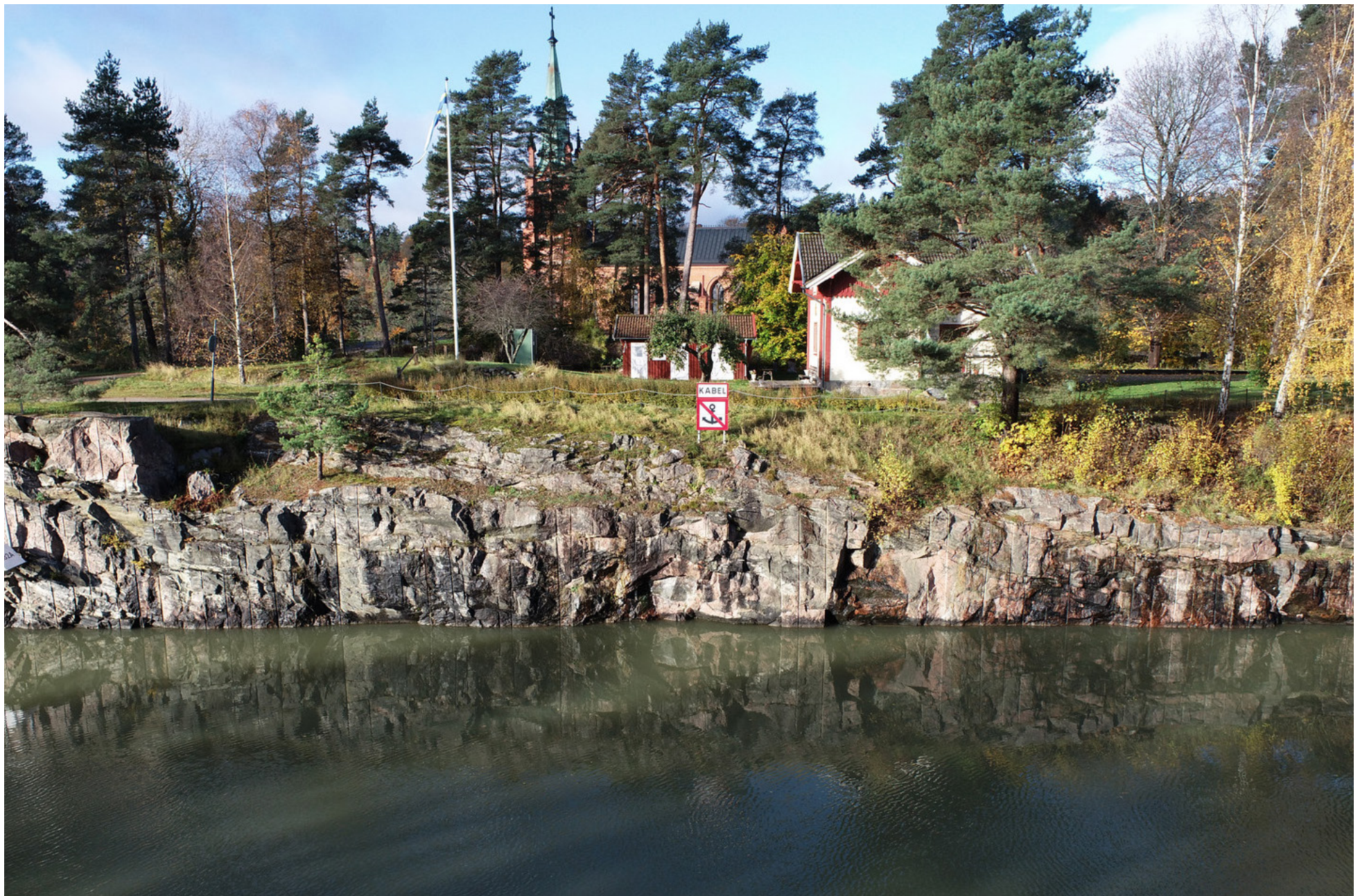
Figur 62 Bergskärningen utmed Kanalön idag.
