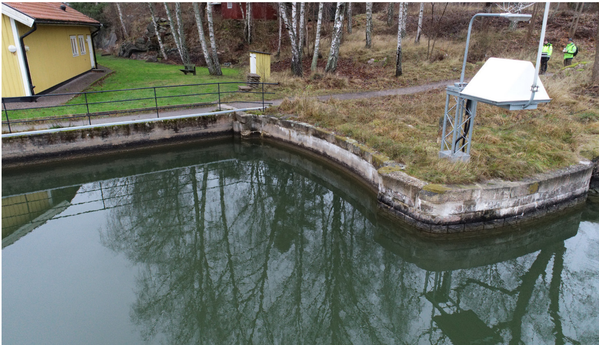
Figur 56 Dockan. En torrdocka har funnits på platsen redan vid 1800 och 1844 års anläggningar och byggdes på en plats där det tidigare låg ett vattendrag. I samband med 1916 års anläggning byggdes dockan om. Vingmurarna kring dockan är utförda med betongkonstruktioner under vattnet och på dem naturstensmurar. Dockan är idag igenfylld och dess portar ersatta med en betongkonstruktion. Dockans murar och form vittnar dock än idag om dess funktion och är en värdebärande karaktär. Då en ny dammkonstruktion tillkommer här föreslås att dockans övre murdelar märks upp, demonteras och monteras som en struktur på den gräsyta som anläggs efter att nuvarande byggnad har rivits.
