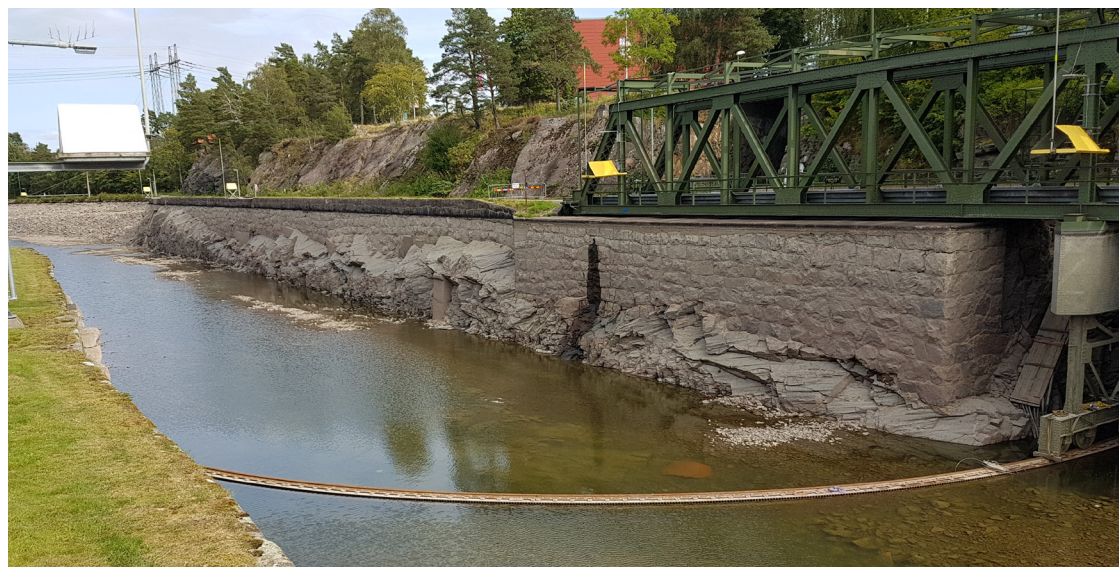
Figur 26 Dragvægen och svängbron vid tömd kanal. De välbevarade murarna framträder tydligt. Dessa murar bevaras. Inga ingrepp ska göras varken i dragvægsmurar eller murarna till brofundamentet.
