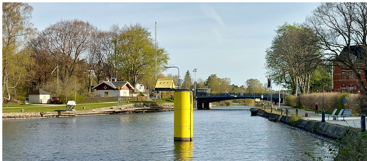
Figur 33 Söder om Klaffbron vidgar sig kanalen och sidorna utgörs av flera olika murtyper. Här finns 1916 års dragvägsmur, glacismur, 1800-talsmur vid inloppet till f.d. bolagskvarnen och modern spontkaj.
