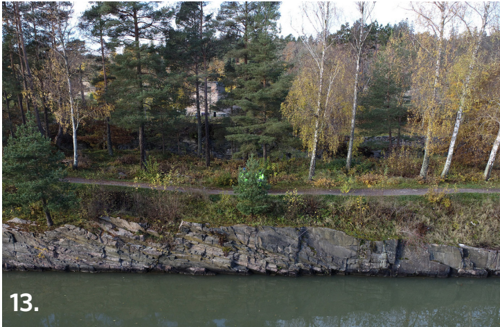
13. Kanalöns norra del fram till norra banken Nuläge: Bergskärning.
