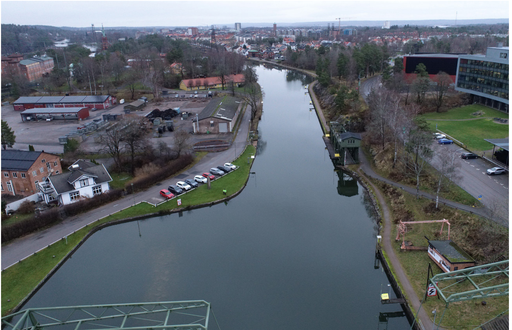
Figur 46 Drönarfoto. Bergkanalen mot norr från området vid Olidebassängen. Nohabs svängbro och dragvägen på den högra sidan.
