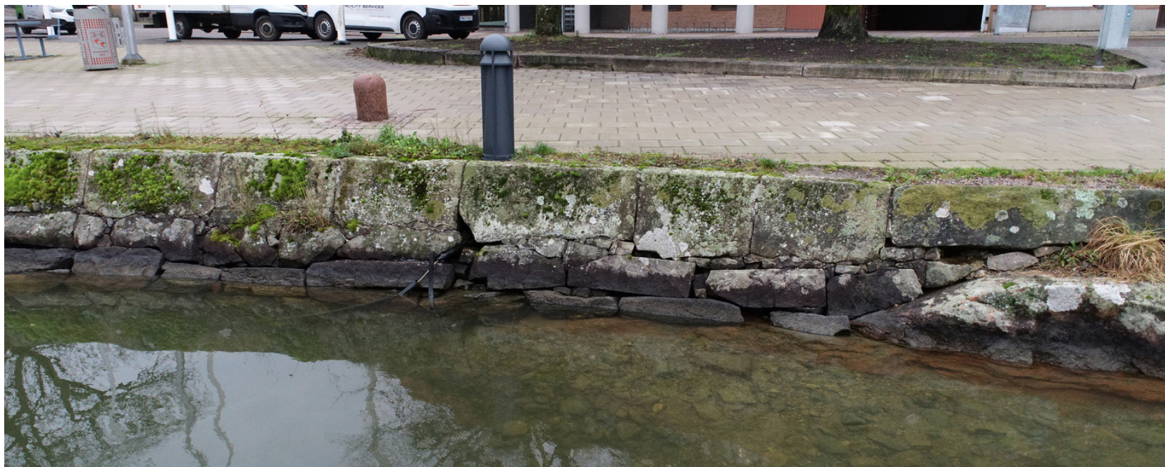
Figur 71 Inom sträcka 31. Här finns äldre välbevarade kanalmurar kvar. Flera stenpollare är bevarade. Promenadstråk med grusväg och gräsytor utmed kanalen. Längst i söder en yta med betongsten .
