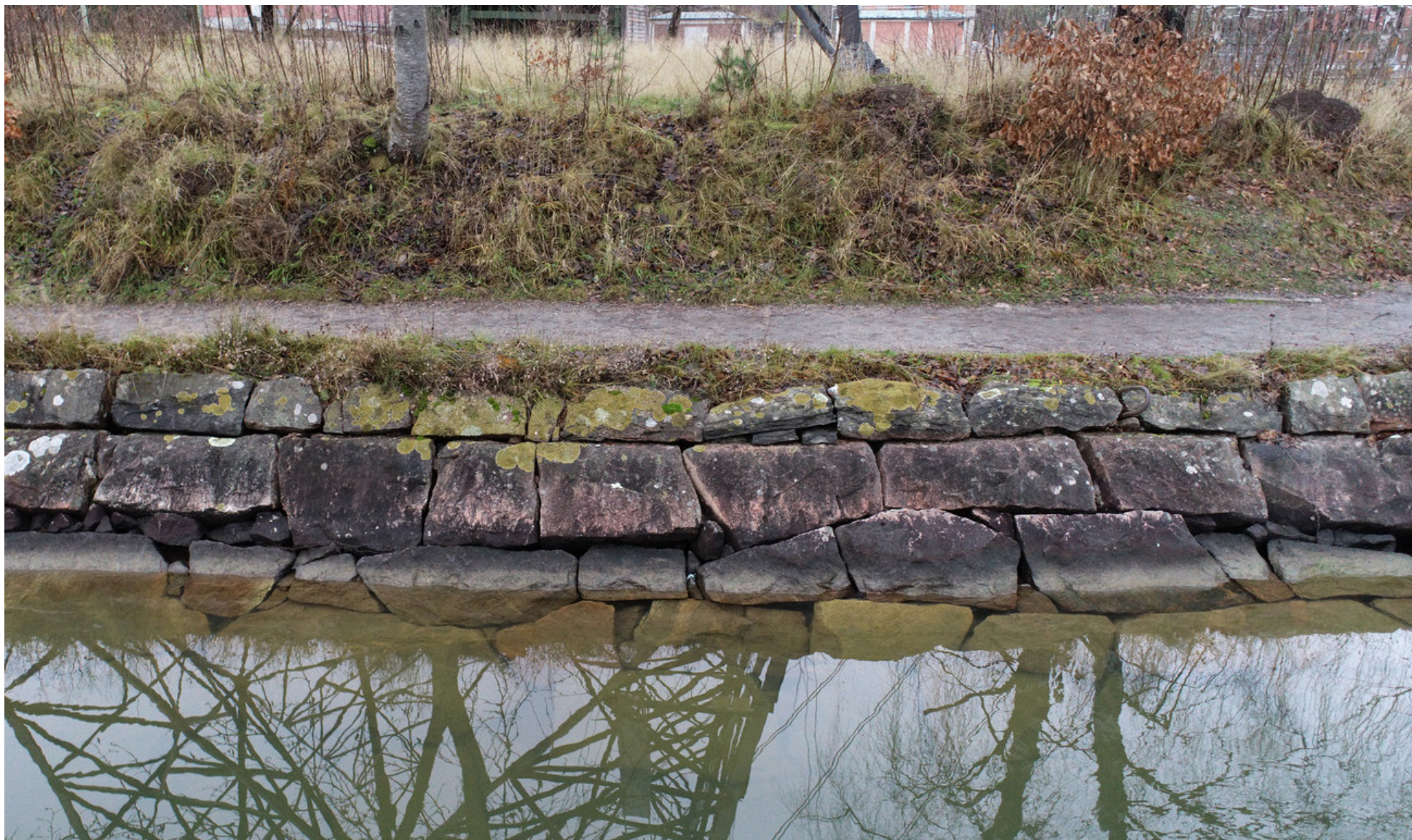
Figur 57 Väl utförda glacismurar från 1916 som är en värdebärande karaktär, mellan södra banken och bergskärningen söder om dockan. Här under kraftledningen. I och med att murarna inte kan återuppbyggas i sin helhet i nytt läge kommer de inte märkas upp, men stenmaterialet tas tillvara och återanvänds då murarna byggs om med befintliga stenar i den övre delen. Murarna ska ha samma utseende och lutning som de befintliga glacismurarna och byggs upp med befintliga stenar ned till 0,5 m under lägsta vattennivå så att karaktären bibehålls.
