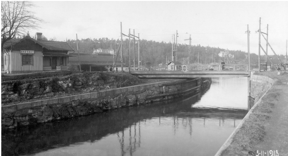
Figur 16 Brovaktstugan före 1916 års breddning av 1800-talets Bergkanal. Bron är en föregångare till 1916 års Klaffbro som 1959 ersattes av den nuvarande klaffbron. Sjöfartsverket
