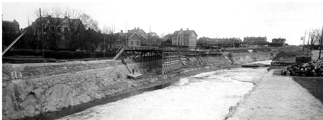
Figur 34 Samma delområde sett från motsatt vinkel mot söder vid färdigställandet av 1916 års slussled. Här syns både glacismurar och vertikala kaj- och dragvägsmurar som följer bergskärningens topografi. Sjöfartsverket.
