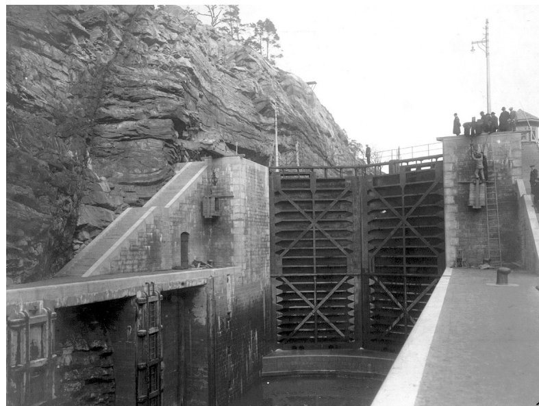
Figur 108. Slussportar fotograferade 1918. Sjöfartsverket.
