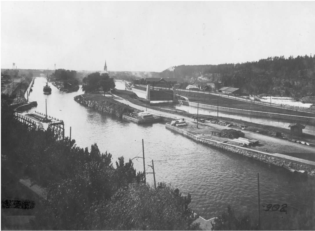
Figur 65. Bergkanalen sannolikt kring tiden för färdigställandet . Dragvägar är anlagda utmed kanalens östra sida. Sjöfartsverket.
