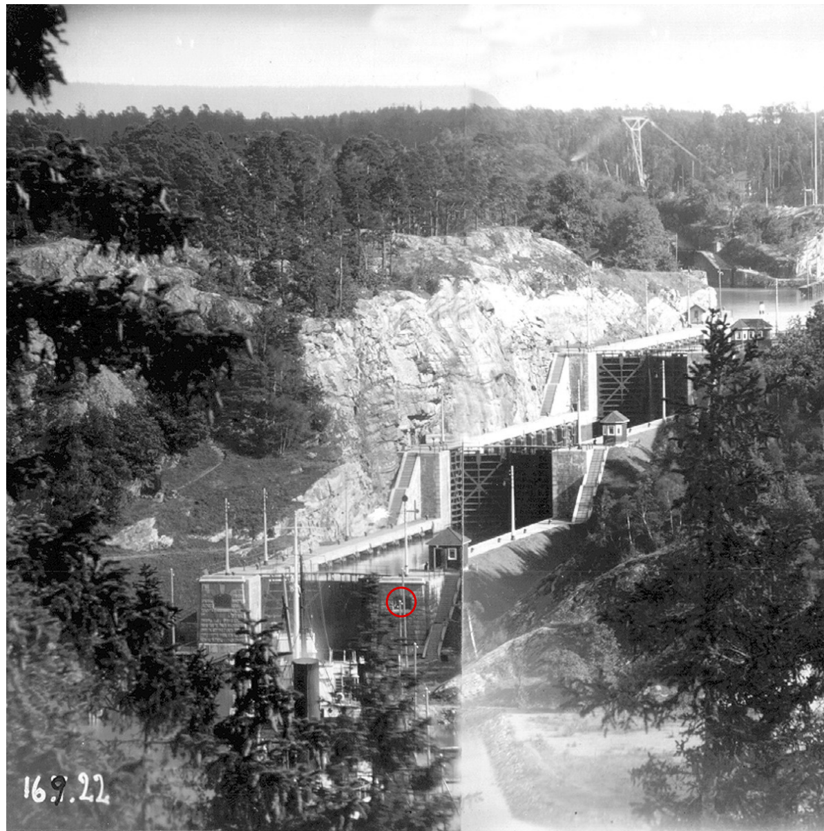
Figur 44. Den mäktiga slussstappan sedd från Göta Älv, 1922. Vid varje port står en liten spånklädd manöverhytt. En intressant detalj är att det ska finnas en tidskapsel bakom den högra skylten (inringad i rött) vid entrén till slussen. Sjöfartsverket.
