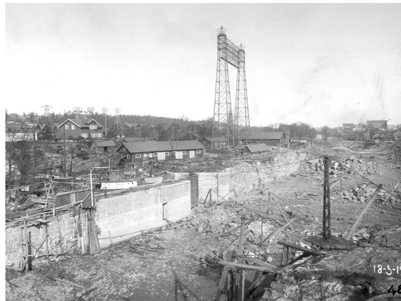
Figur 76. Den ombyggda Torredockan 1914. Sjöfartsverket.
