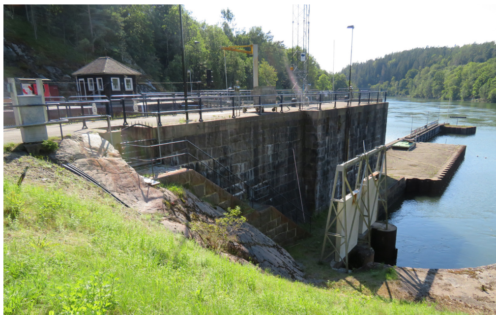
Figur 107. Slussmurar och trappor samt en av manöverhyttorna från 1916.
