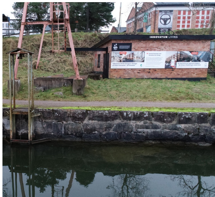
Figur 20 Pumphuset och traverskranen.
