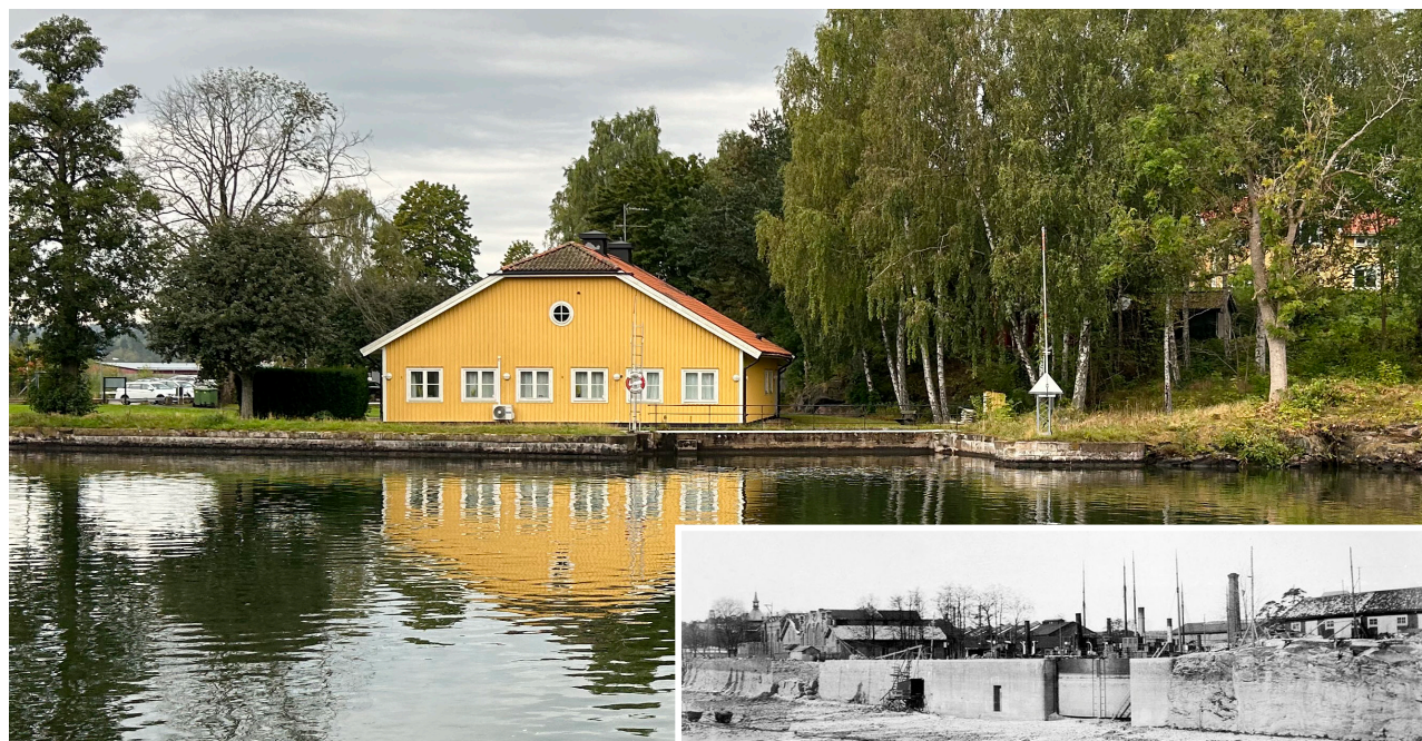
Figur 18 Byggnaden sedd från kanalen. Kajkantens utformning avslöjar placeringen av dockans f.d. slussport. Den infällda bilden från ca 1915 visar tömd kanal och torrdockan som lades igen på 1970-talet. Delar av Dockans murar är fortfarande idag synliga i marken.
