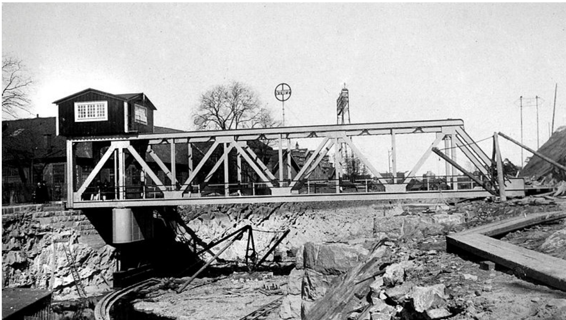
Figur 2 Foto från 1915 på Nohabs välbevarade svängbro för järnvägstransporter som tillkom i samband med breddningen av Bergkanalen och ersatte en äldre svängbro. Bron är av en enarmad, understödd konstruktionstyp med ovanpåliggande manöverhytt som sannolikt är relativt unik i sitt slag. Sjöfartsverket
