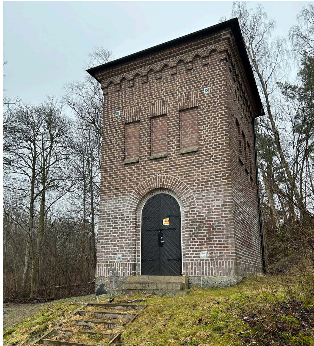
Figur 11 Transformatorbyggnaden sedd från dragvägen.
