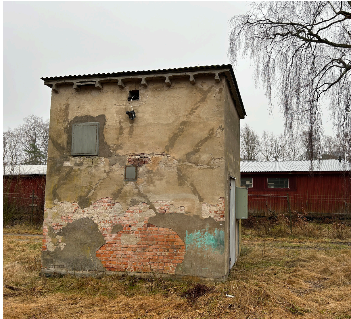
Figur 22 Den mindre teknikbyggnaden med sällsynt takkonstruktion av prefabricerade modulelement i betong.
