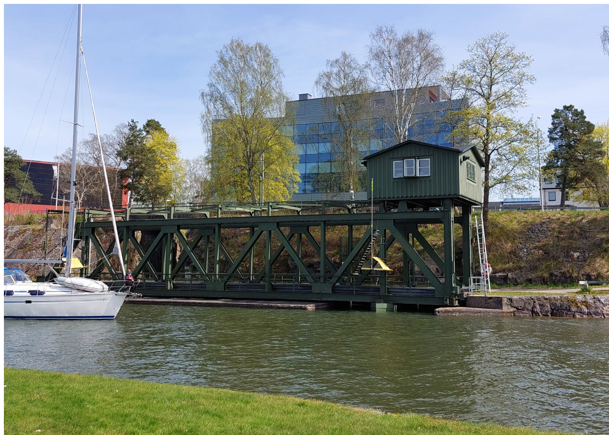
Figur 12 Svängbron med ovanpåliggande maskinhus.
