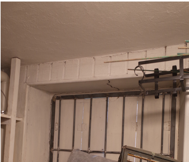
Äldre pärlspontpanel och dragspelsluckor för fönstret i ett mindre rum mot norr.
