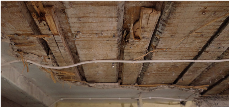
Putsat innertak på brädbotten och vassmatta.
