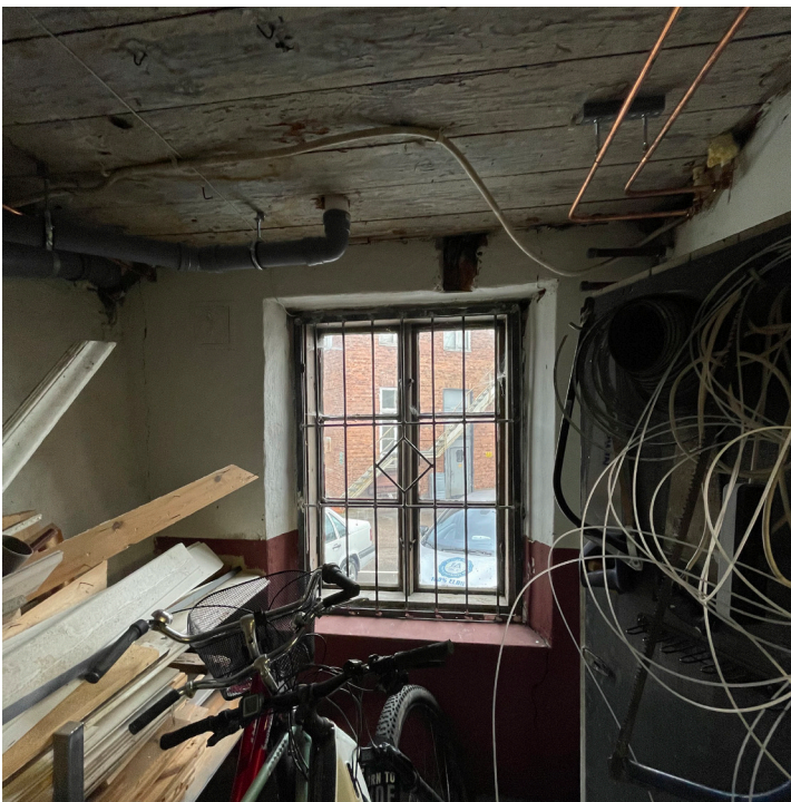
Ett av de yttre rummen med fönster som vetter mot fabriksområdet. Bäcklätt äldre innertak med flagnande färgskikt, sannolikt limfärg. Inbrottsgallren är sentida.
