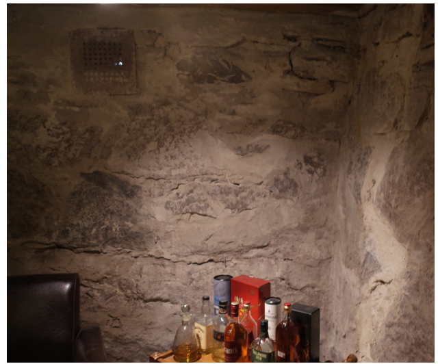
Blottad gråstensmur i ett av källarrummen som saknar fönster. Sannolikt användes det förr som matkällare.
