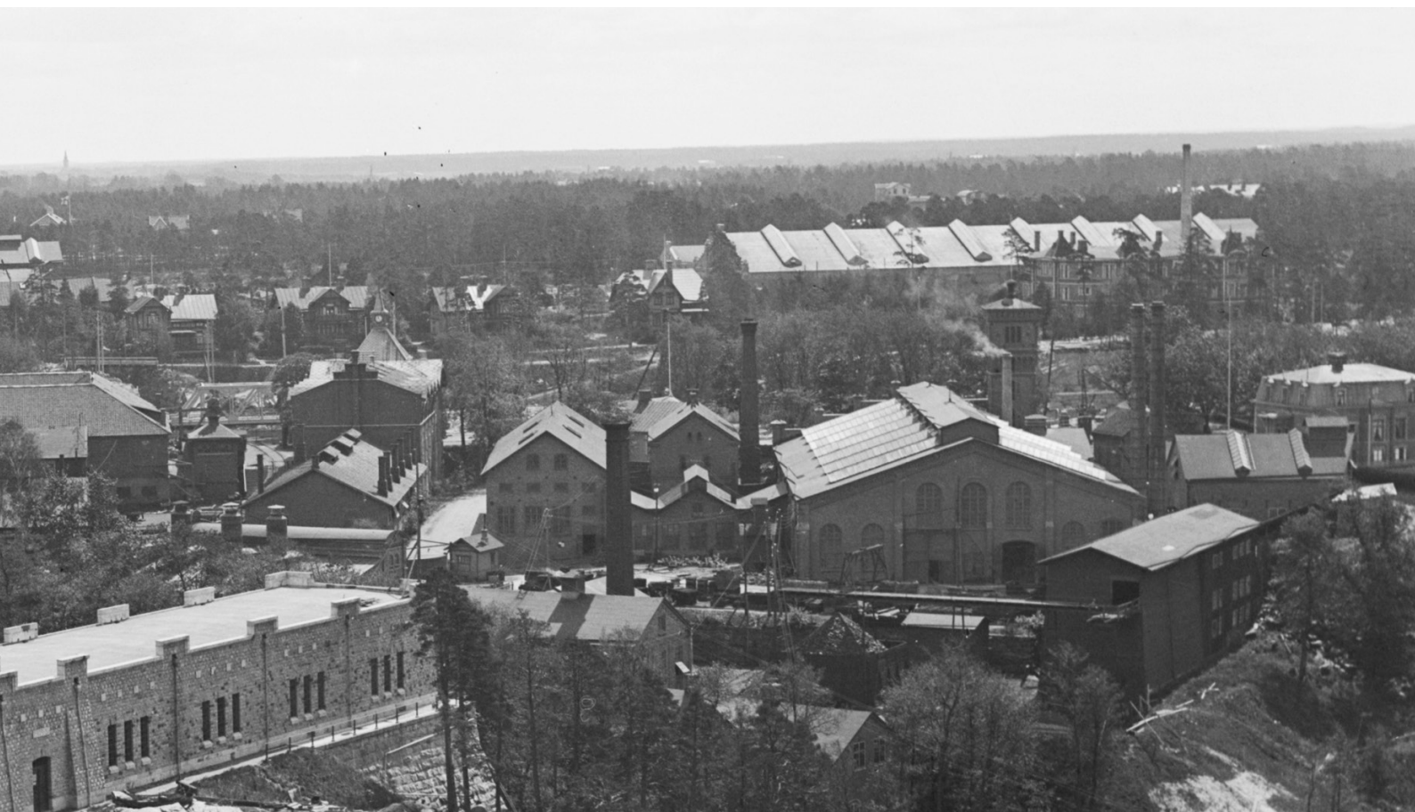
1910-tal. Nohabs fabriksområde sett från norr. Skuggans tak skimtar fram bakom fabriksbyggnaderna. Källa: Digitalt Museum
