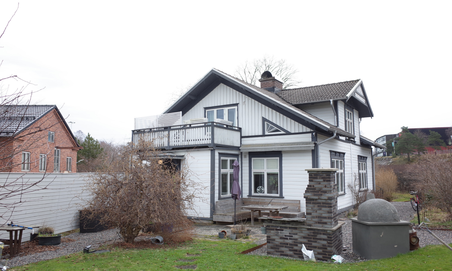
Tomtens västra del med ny uteplats. Gaveln har inbyggd entréförstuvist med balkong.
