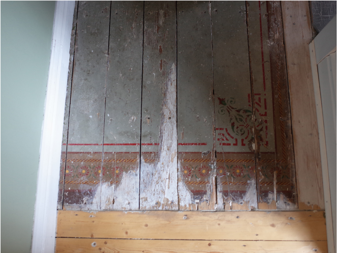
Målat golv med friser och hörnornament vid den västra entrén. Golvet avslöjar en äldre rumsindelning som förmodligen var av korsplanstyp.
