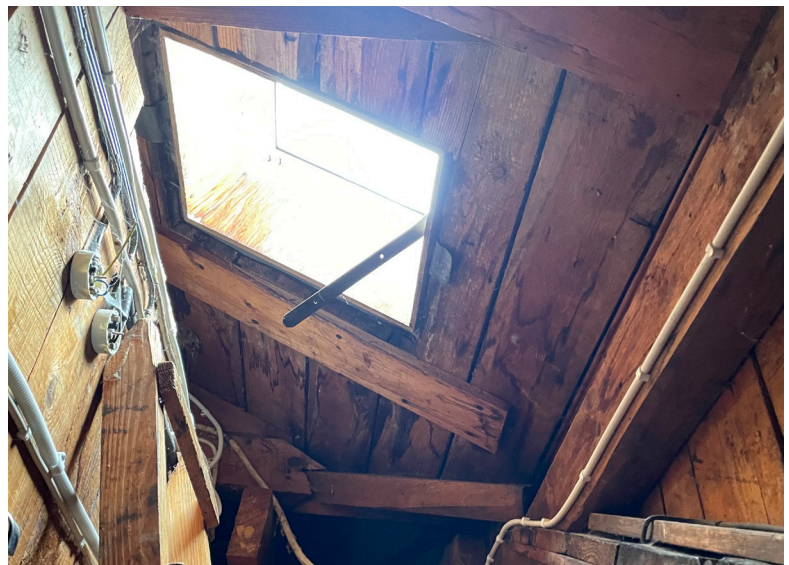
Takkonstruktion och takfönster i påbyggnaden mot norr.
