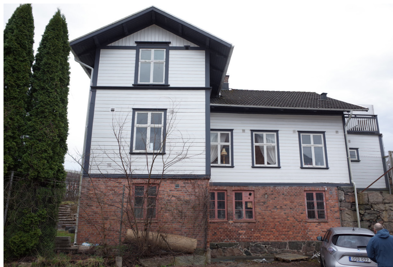
Skuggans baksida med den höga tegelsockeln, stödmuren och påbyggnaden.
