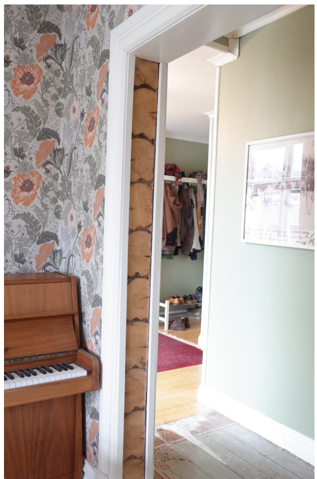
Förstorad rumsöppning där timmerstommen lämnats synlig. Nederst till höger syns det äldre målade golvet.
