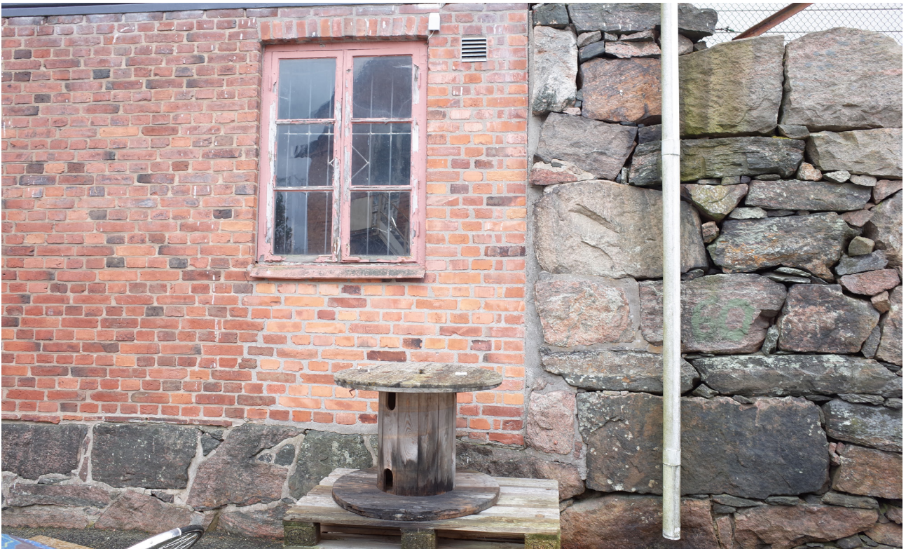
Hög tegelsockel och kallmuradgråstensmur som vetter åt den gamla fabriksmiljön på byggnadens nordsida.
