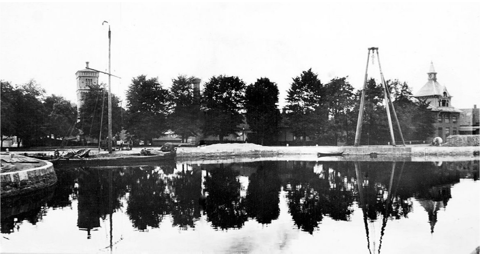
Verkstadssässan med Nydqvist & Holms gamla vattentorn, mastkran och huvudkontor. "Mellan träden skymtar ingenjörsbostaden Skuggan, där ingenjör H. Setterberg bodde. I bassängen ligger en äkta så kallad älvbåt eller pese. Dessa båtar voro lastdryga och gick ofta med kollaster." Foto från sent 1800-tal eller 1900-talets början. Foto och text från Walter Göranssons bildsamling. Källa: Innovatums bildarkiv
