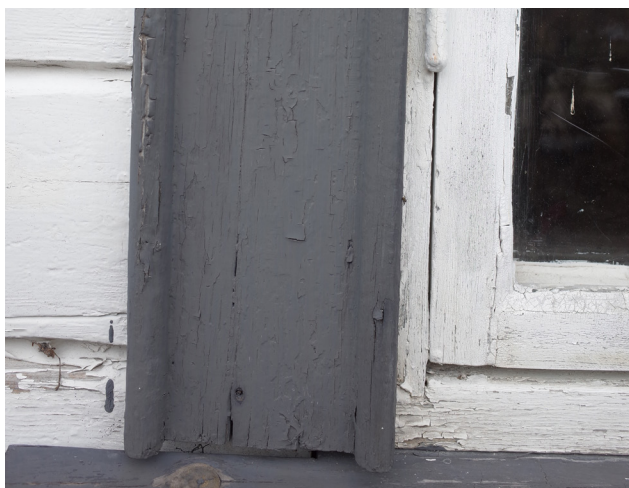
Profilerad fönsteromfattning på sydfasaden
