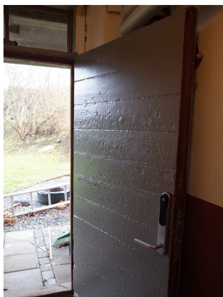
Källarens entrédörr med liggande brädfodring är förmodligen ursprunglig från 1870-tal..
