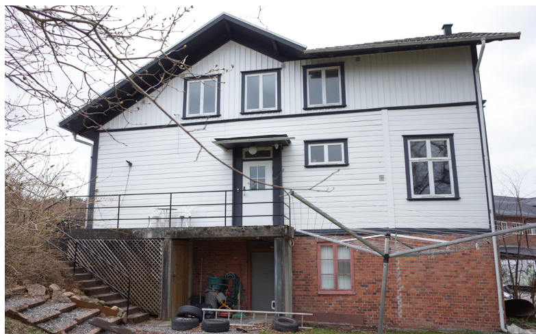
Skuggans östra gavel med entré och påbyggnad från tidigt 1900-tal.
