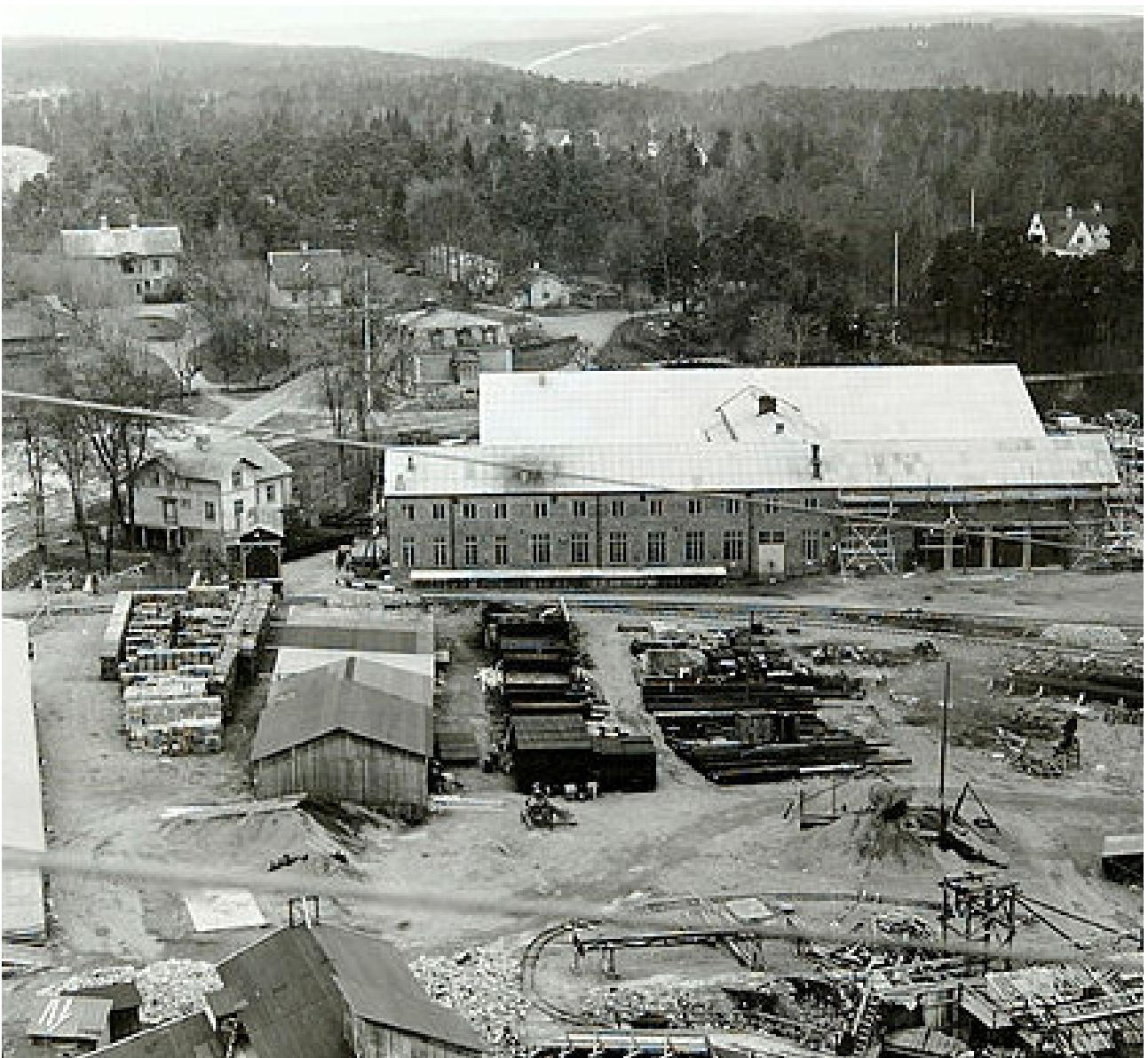
Miljön omkring Olidanbassängen ca 1945. På fotot syns samtliga fyra byggnader som utreds för påverkan av den nya slussleden. Skuggan under träden i mitten till vänster om fabriksbyggnaden. Källa: Innovatums bildarkiv.
