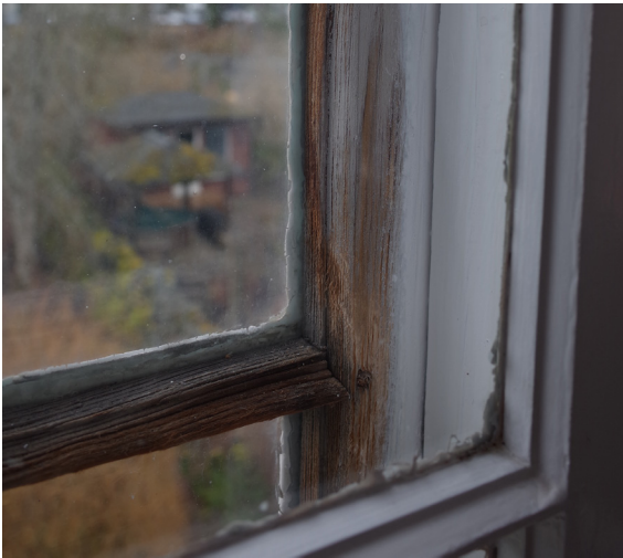
Äldre bevarat fönster på sydvästra gaveln. Ytterbågen är förmodligen från ombyggnaden 1877.
