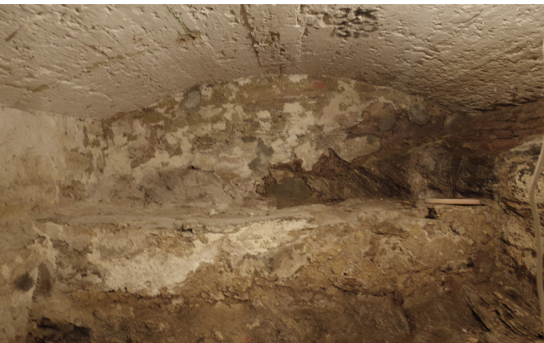
Det innersta rummet, delvis uthugget ur berggrunden. I taket syns spår efter gjutformsbrädor.
