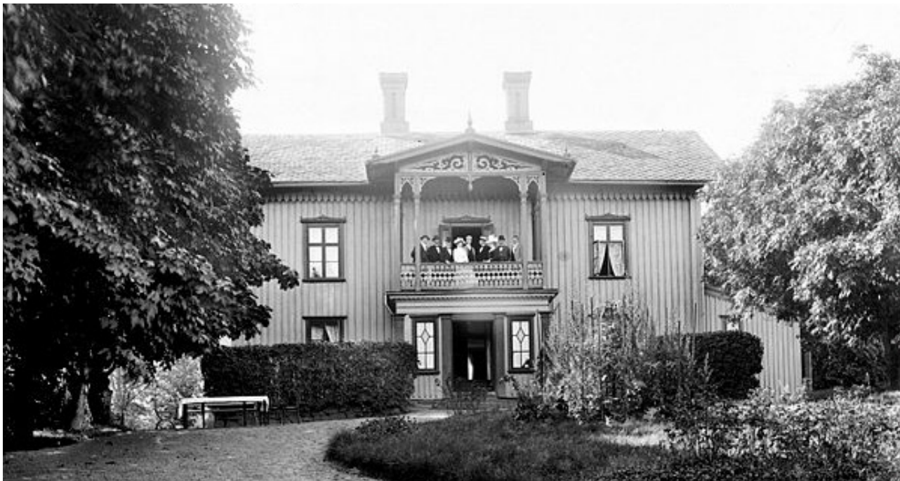
Mangårdsbyggnaden efter ombyggnaden 1877. Troligtvis sent 1800-tal eller omkring sekelskiftet 1900. I nuläget har byggnaden i stort sett samma utseende med undantag för detaljer som kulör, taktäckning och skorstenar. De dekorativa spirorna på balkongtakets vindskivor liksom markeringarna av de övre fönsterfodrens krön saknas idag. Källa: innovatums bildarkiv.
