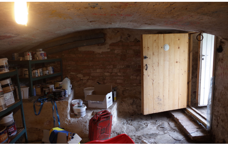
Tunnvalvstak och stenlagt golv i källaren.
