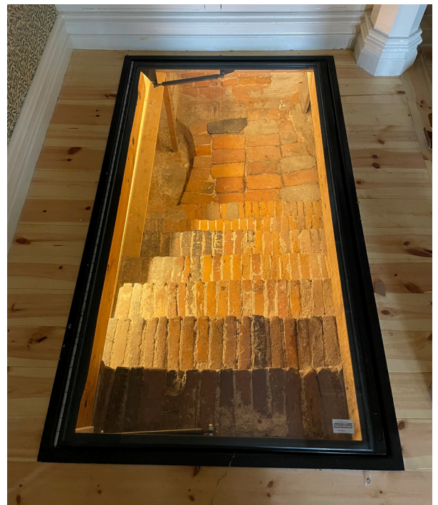
I entréhallen har en ny glaslucka lagts över källarnedgången.
