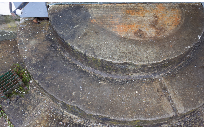
Entrétrappan är eventuellt den ursprungliga från byggnadens uppförande 1787.
