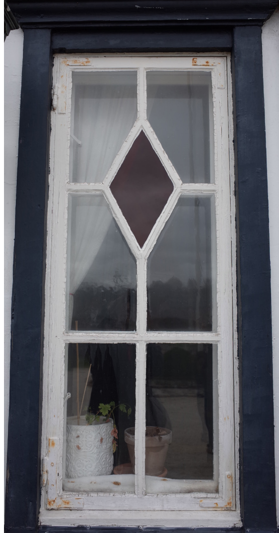
Äldre spröjsat fönster på entréns förstuga. Sannolikt från ombyggnaden 1877
