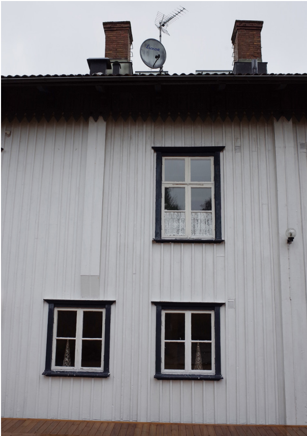
Tillägget av ett extra fönster mitt i en tvärgående timmervägg vittnar om det tidiga behovet av en större matsal.
