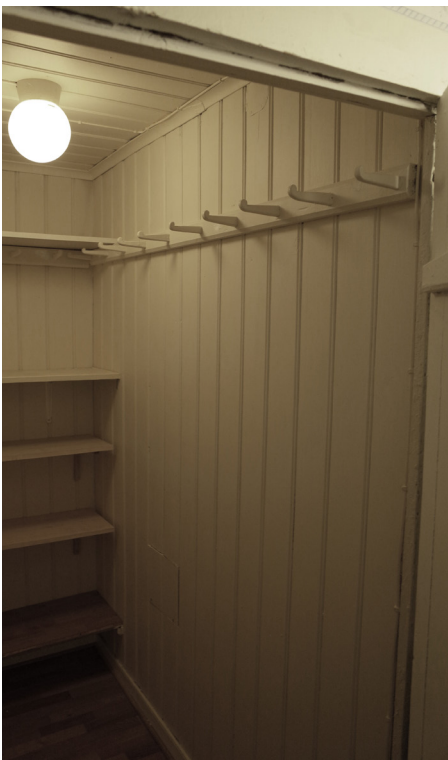
Inbyggt förvaringsutrymme med hängare på vinden
