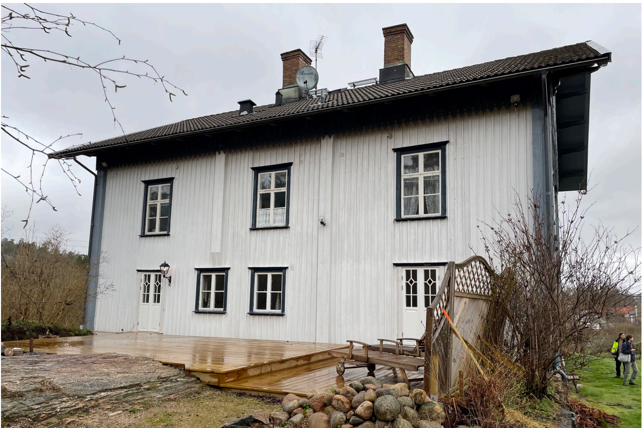
Baksidan i sydväst. Ny altan och dörrar.
