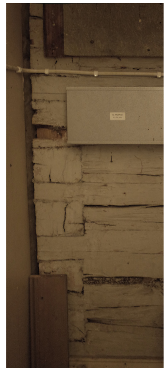
Frilagd del av timmer konstruktionen.
