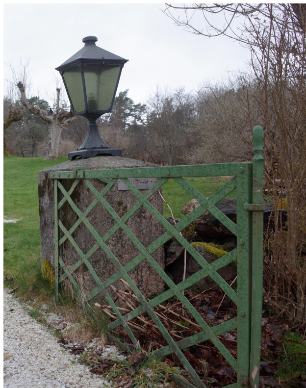
Smidesgrind med flätverk och bastant grindstolpe i granit vid infarten till gården.
