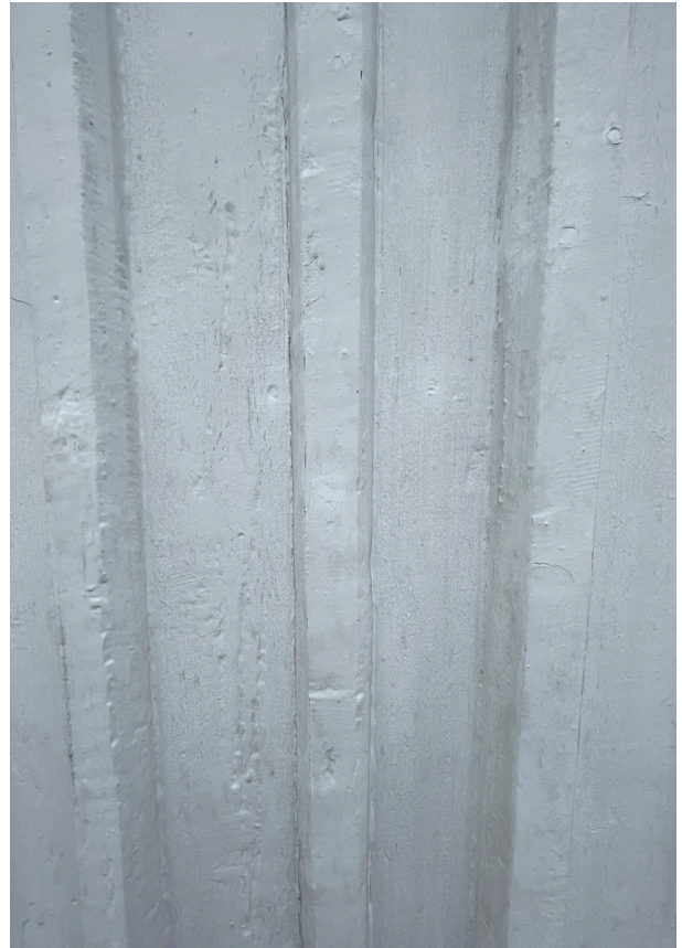
Fasadens locklistpanel är sannolikt från 1877, delar av det nedre partiet är troligtvis ännu äldre.
