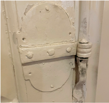
Äldre plattjärnsgångjärn, norra kammaren.
