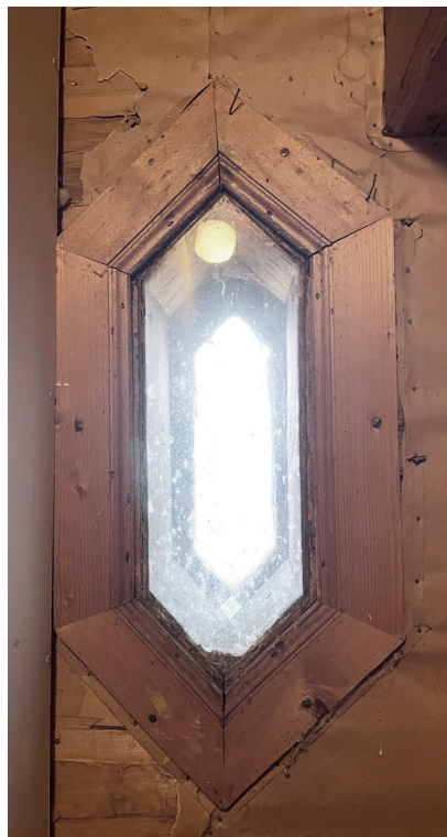
Sidovindarnas ljusinsläpp med en innerruta som fått profilerade foder. Avståndet till den yttre rutan är stort
