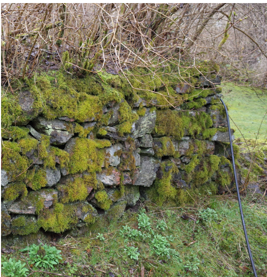
Äldre terrassering uppförd med sten från kanalbygget.
