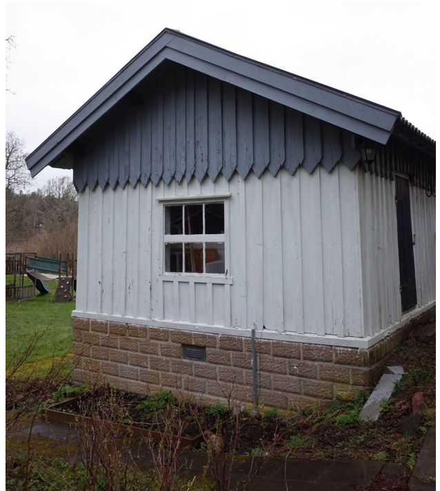
Vedboden har en sekundär fasadbeklädnad som hämtat inspiration från mangårdsbyggnaden.
