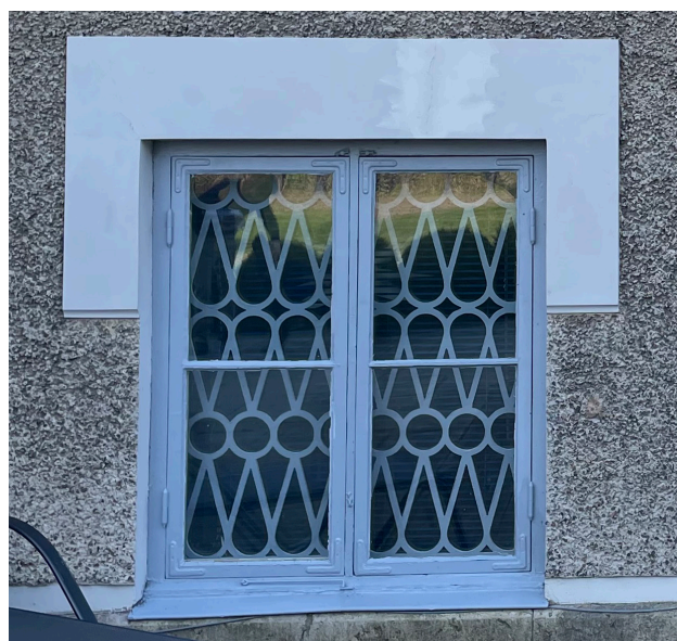
Omsorgsfullt utformat inbrottsgaller innanför källarfönstren.
