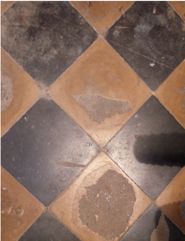
Slitet klinkergolv i källaren.
