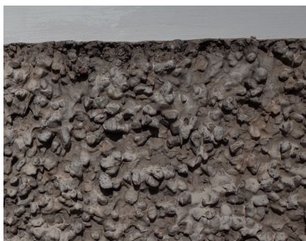
T.v. Fasadens sprit-puts med grov ballast.
