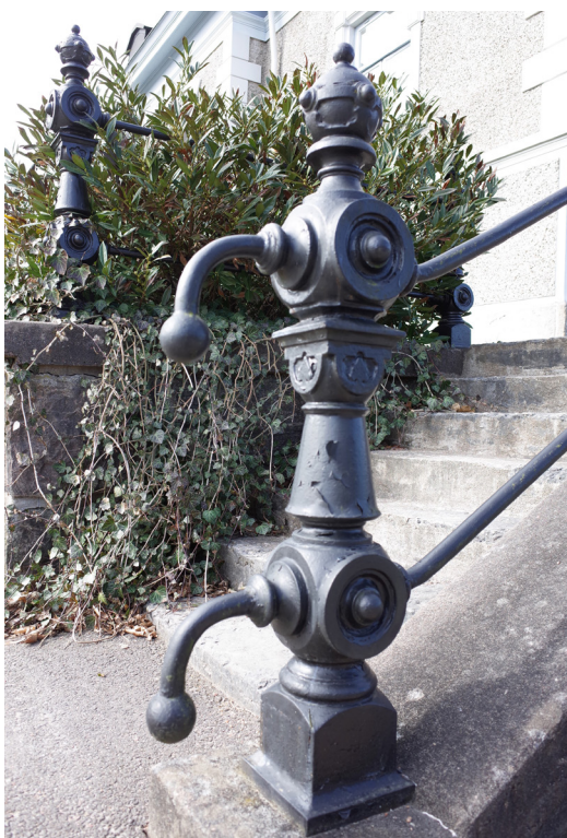
Framsidas skulpturala trappräcke och stolpar med ett massivt, industriellt uttryck som sannolikt tillverkats lokalt hos Nohab.
