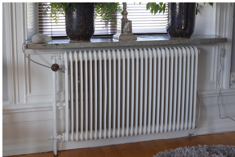
Fönsterparti med hög sockellist, profilerade foder, fyllningspanel och äldre radiator.
