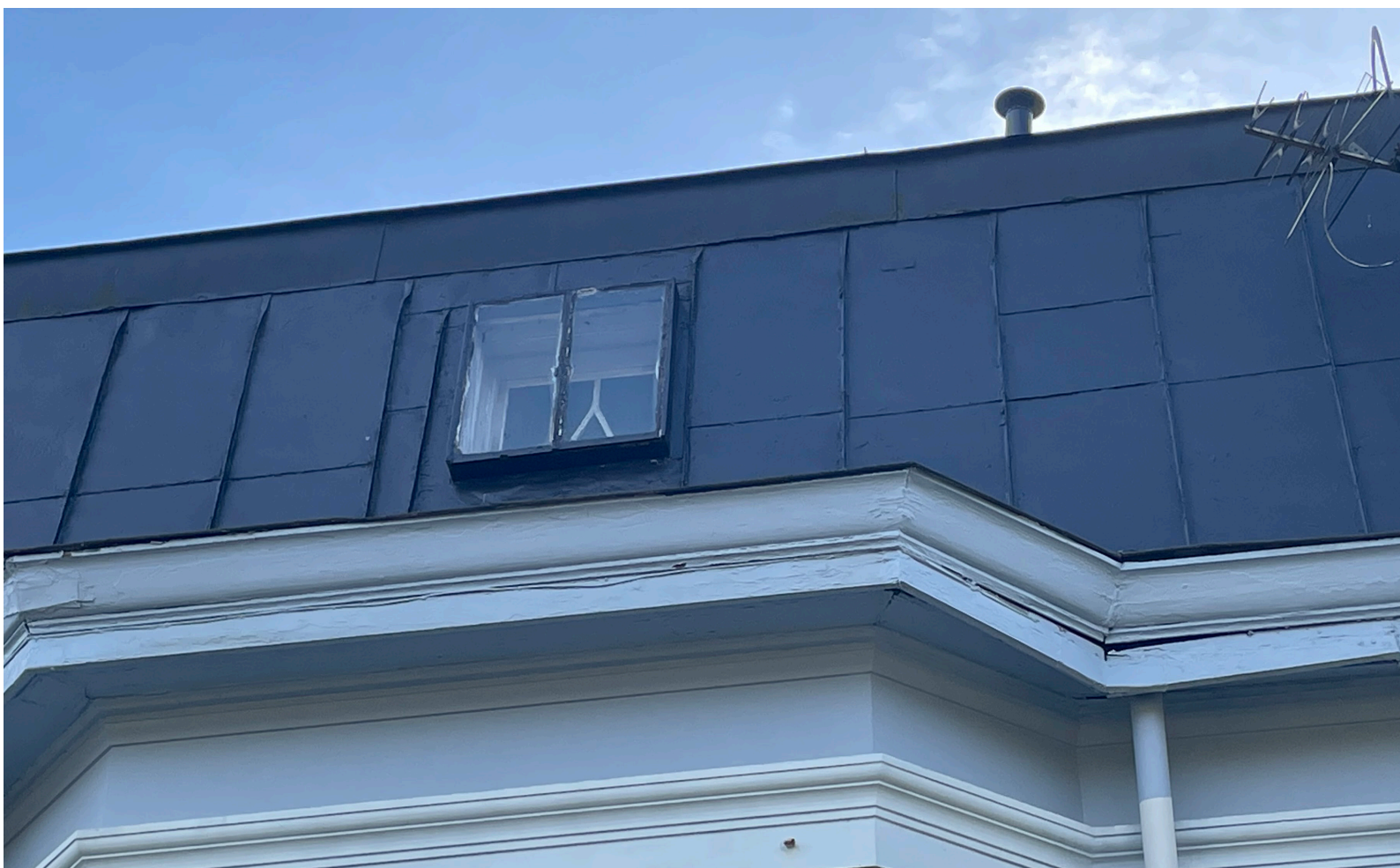
Trapphusets äldre takfönster och skivtäck plåt som förmodligen är från 1890. Sannolikt är även takfotens gesims och listverk ursprungliga.
