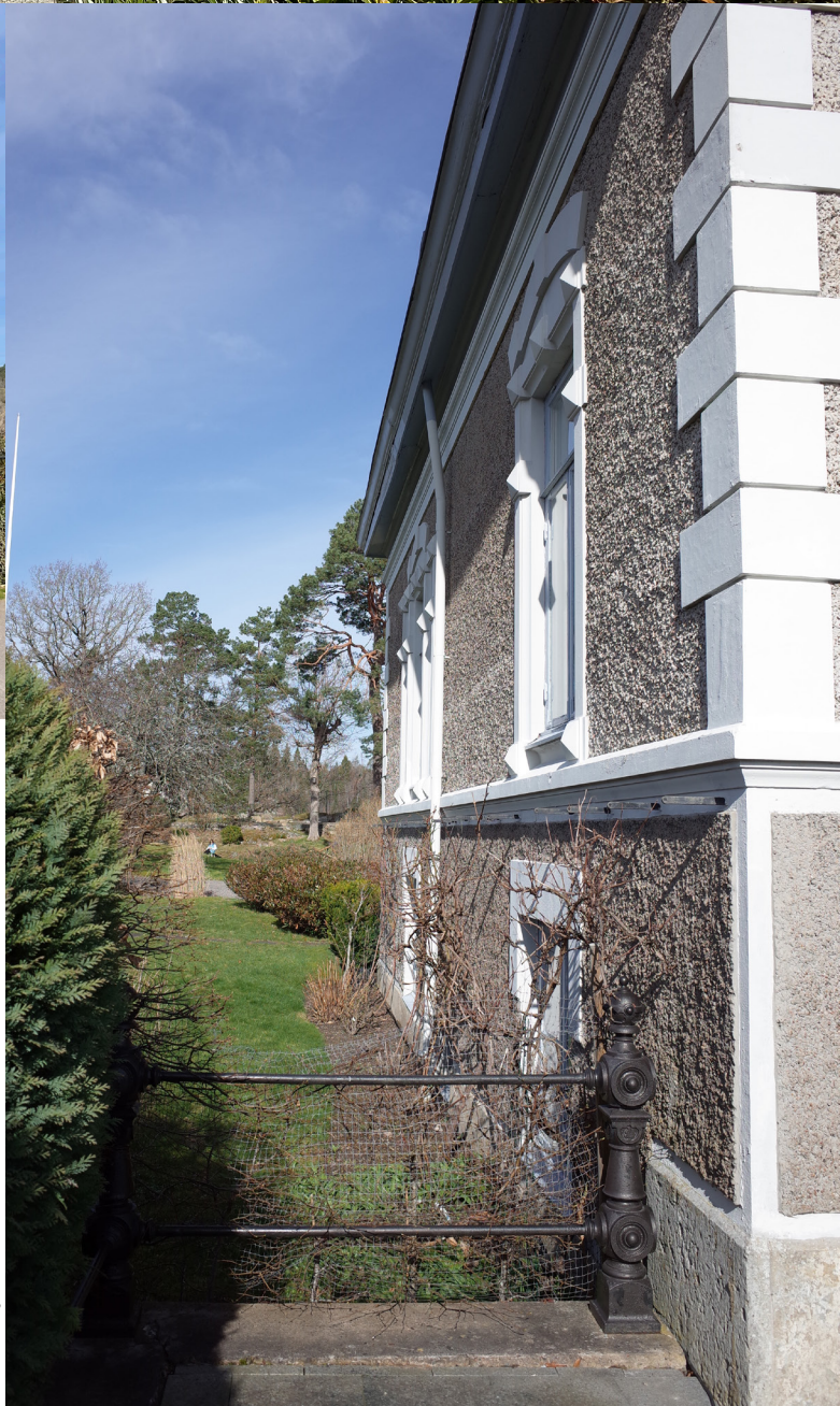
T.h. Västra fasaden.
