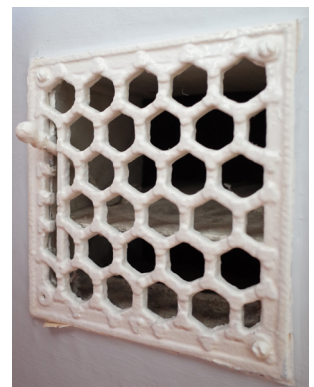
Gammal varmluftsventil på övervåningen.
