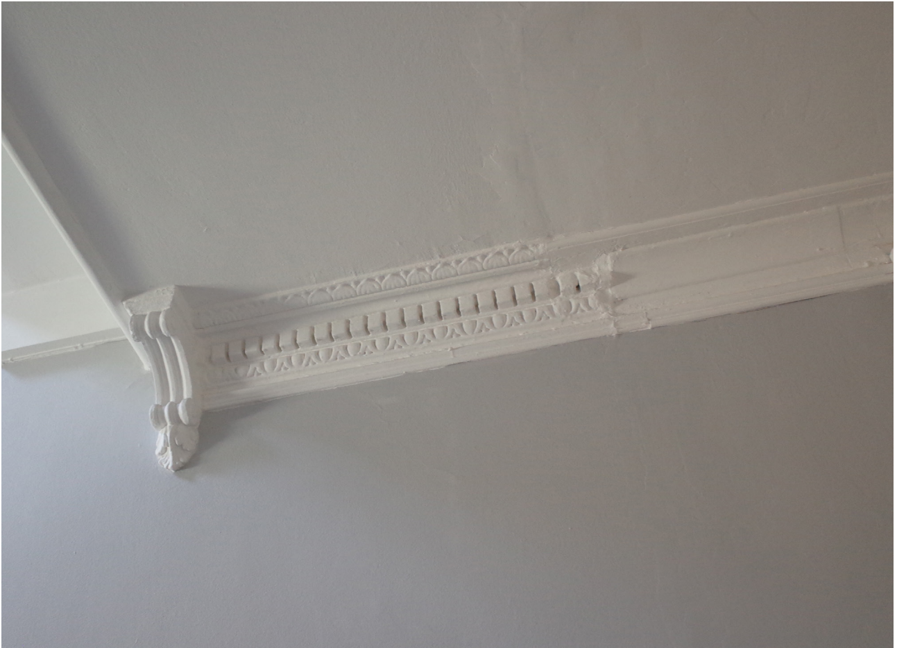
Rester av en rikt utsmyckad stucklist i trapphuset.
