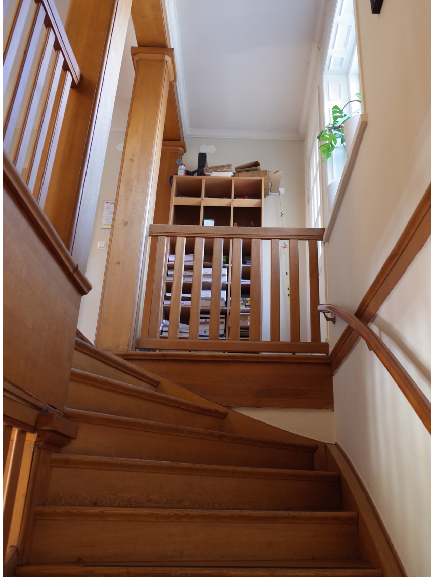
Erik Hahrs trappa byggd av ek.
