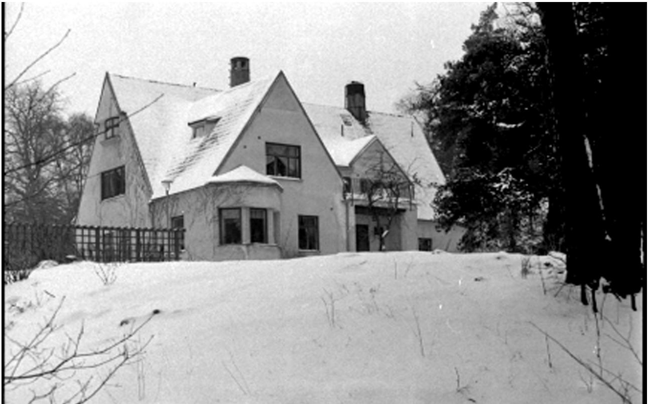
Skogsvreten vintern 1985. De ursprungliga, småspröjsade fönstren är utbytta mot en modernare typ vars karmar och bågar har en mörkare kulör. Källa: Digitalt Museum
