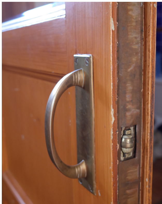
Huvudingångens innerdörrar är ådringsmålade och har enkla mässingshandtag.
