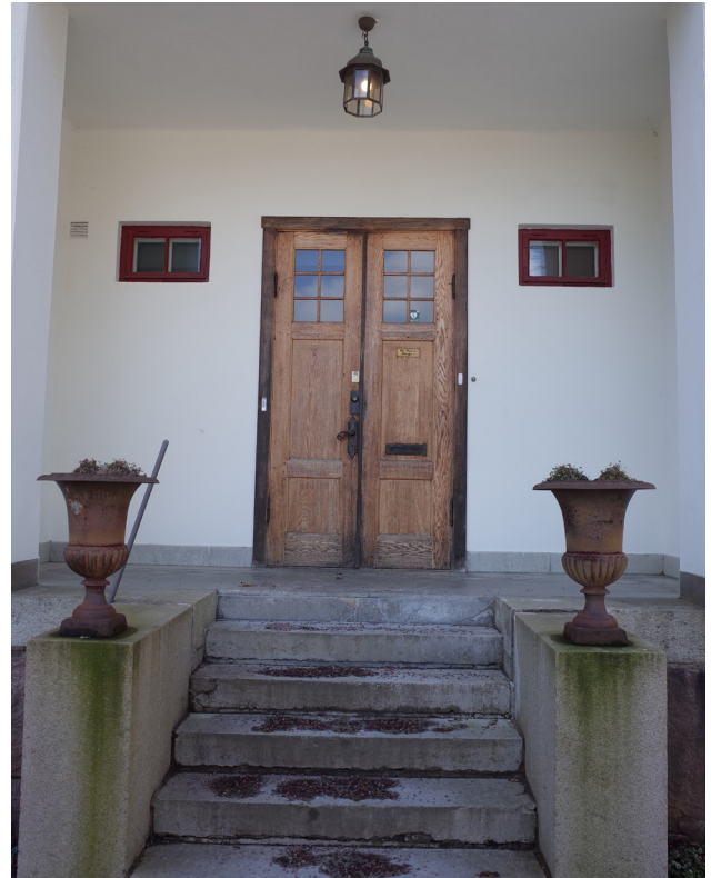
Huvudentré och kalkstenstrappa med robusta sidostycken i granit och gjutjärnsurnor.
