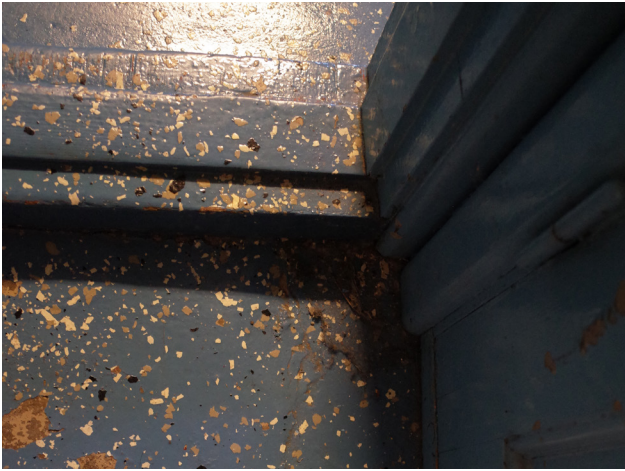
Det gjutna källargolvet har ett blått, terazzoimiterande färgskikt
