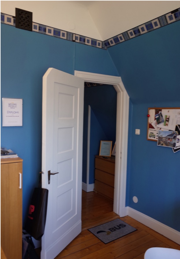
Avfasade dörrblad vid sluttande innertak i övervåningens gästrum.
