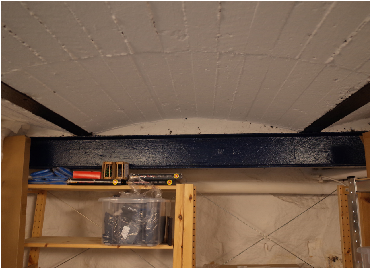
I källaren framträder bottenvåningens bremerbjälklag med stålbeamer och tydliga spår efter gjutformsbrädor.
