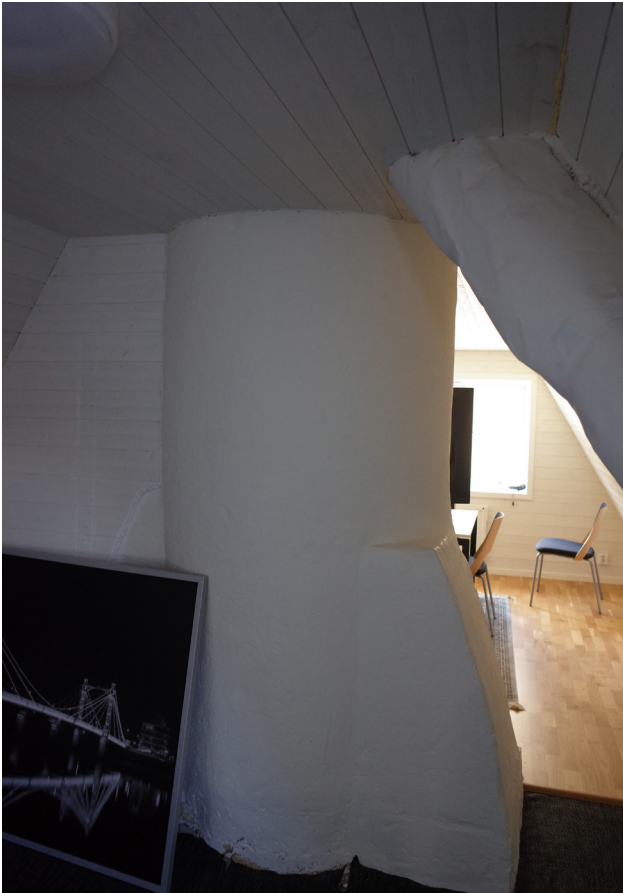
Vindsvåningen med cylindriska murstockar har nyligen inretts och isolerats.
