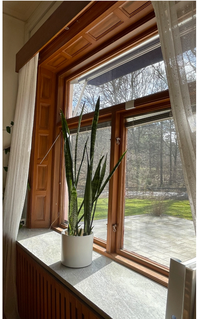
Påkostade fönstersmygar och radiatorskydd i trä med fönsterbänk i sten. Fönsterkarm och bågar har fått stå trärena och oljats.
