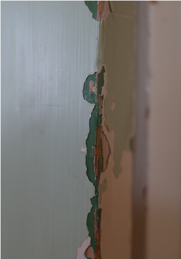
Äldre färgskikt på en innerdörr i köket.
