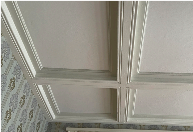
Plafondtaket i matsalen på bottenvåningen är ursprungligt.
