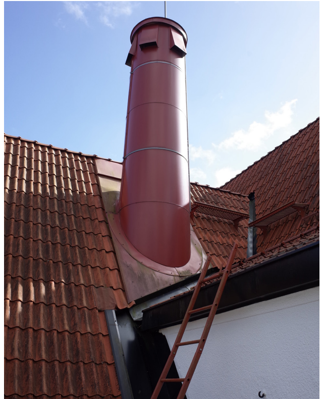
En av de två karaktäristiska, cylinderformade och numera plåtinklädda skorstenarna.
