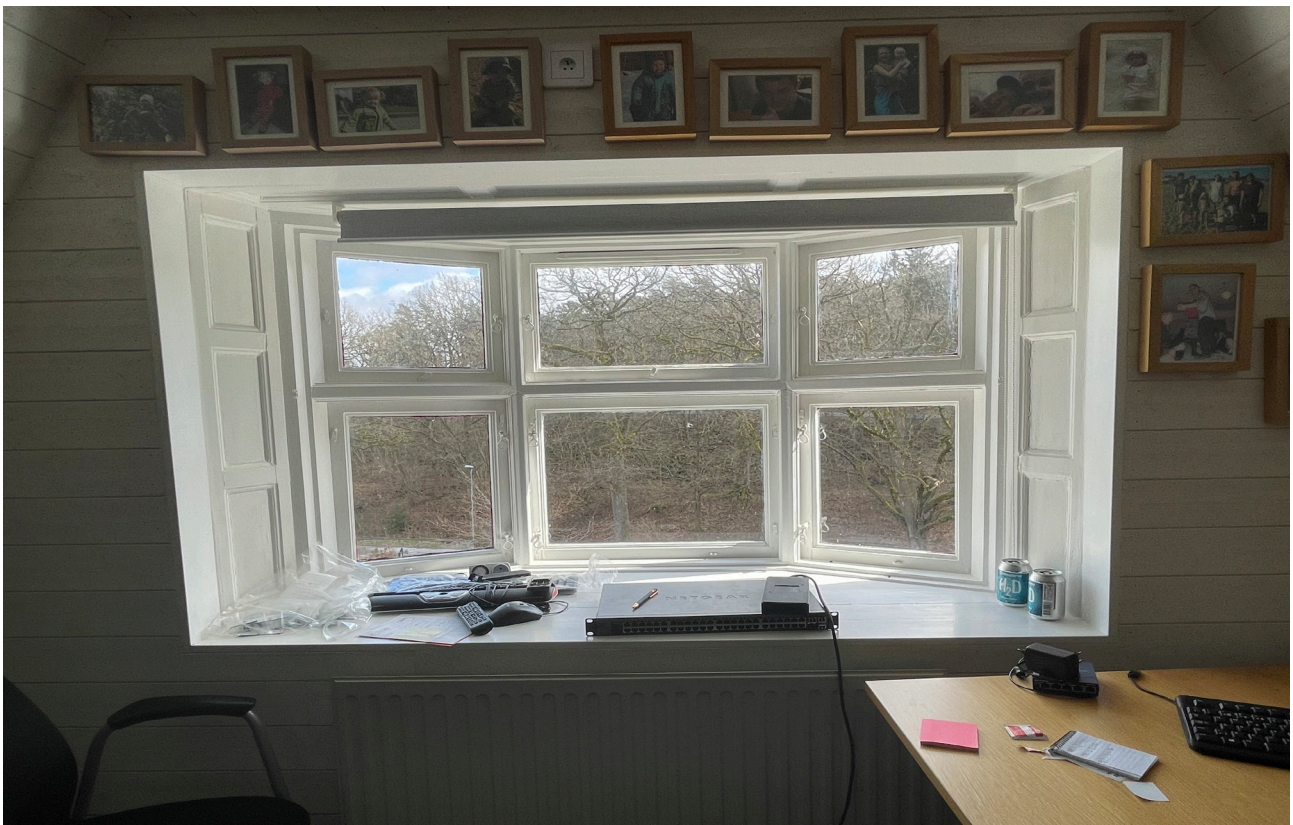
Detta var förr det enda inredda rummet på vinden. Enligt uppgift ska det endast ha använts sommartid. Det utbuktande fönsterpartiet tillhör byggnadens södra gavelröste.
