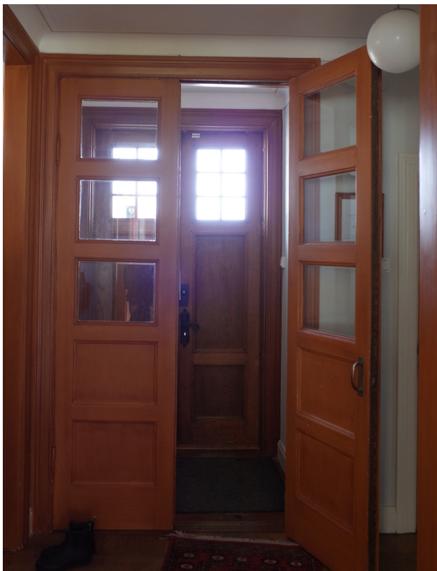
Huvudentrén har ådringsmålade innerdörrar och foder för att imitera ek.
