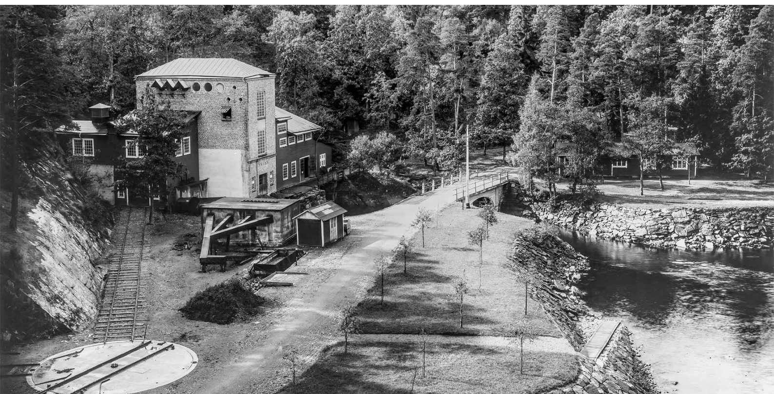
Den provisoriska kraftstationen vid Olidehålan som föregick Olidanverket. Efter uppförandet av kraftverket nyttjade Nohab byggnaden som turbinprovvningsstation. Foto 1923. Källa: Innovatum
