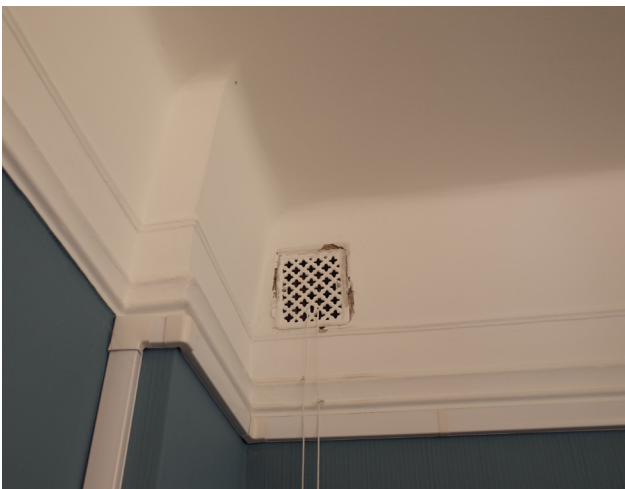
Smäckra stucklistprofiler vid övergången från vägg till tak.
