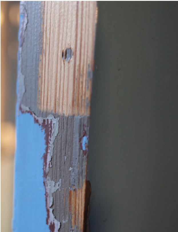
Äldre färgskikt på innerdörr i källaren.
