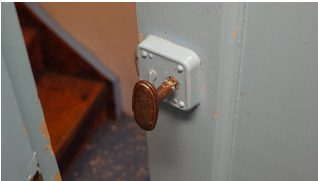
Innerdörr i källaren med äldre låskista och äggformat vred.
