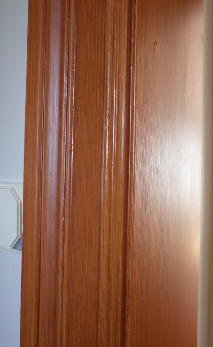
Ådringsmålat dörrfoder som eventuellt ska efterlikna den äkta ekinredningen.
