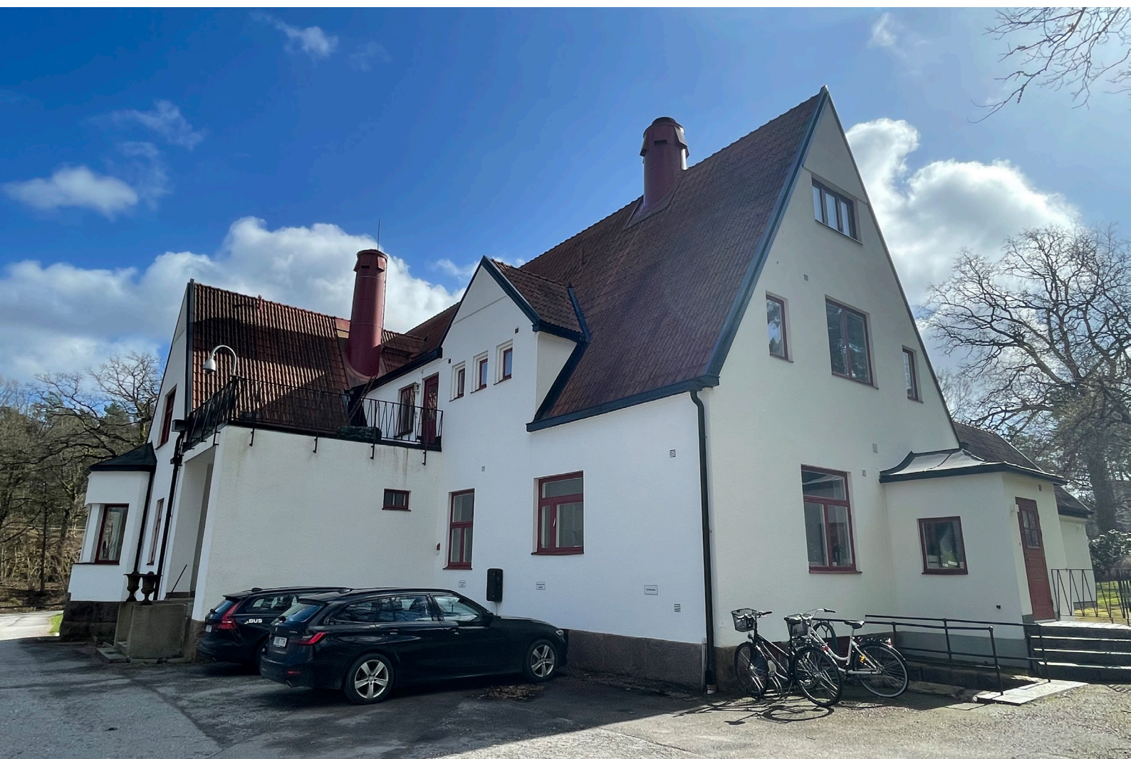
Nordvästra fasaden med köks- och källaringång.
