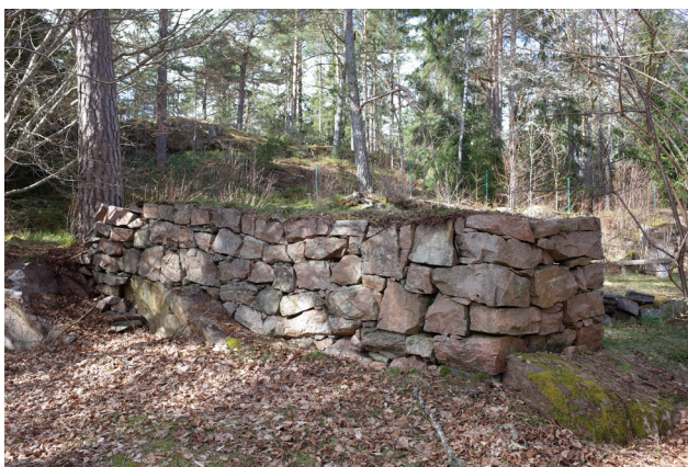
Kallmur av sten som troligtvis huggits på plats. Okänd funktion.
