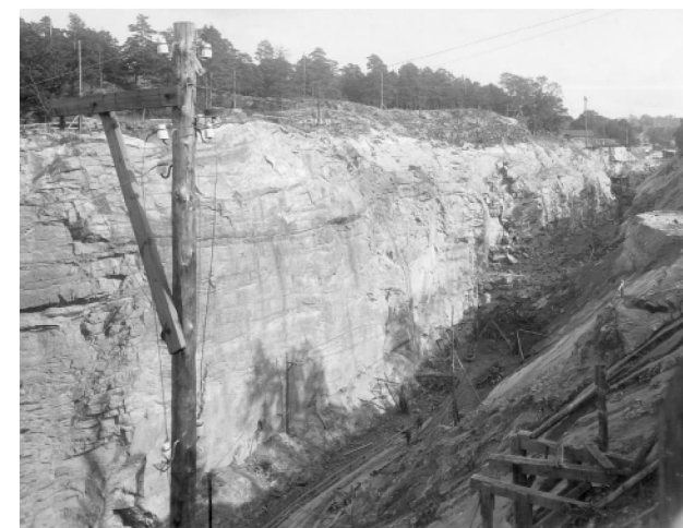
Figur 12 Bild från 1913 som visar hur ett 47 meter högt bergsparti i Trollhättan har sprängts bort för att göra plats åt dagens slussstrappa. Sjöfartsverket.
