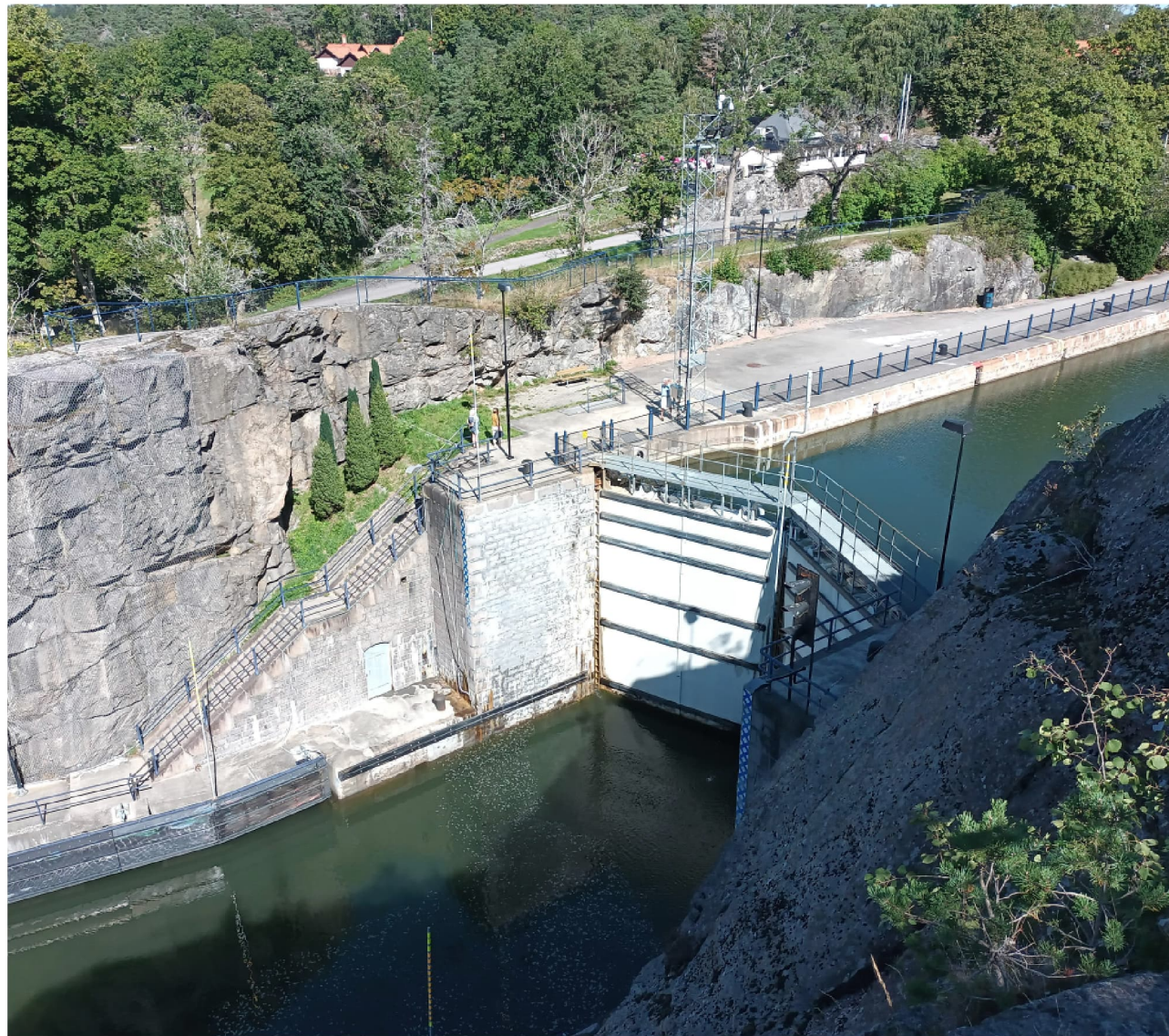
Figur 178 Slussen i Trollhättan omges av höga bergsskärningar.
