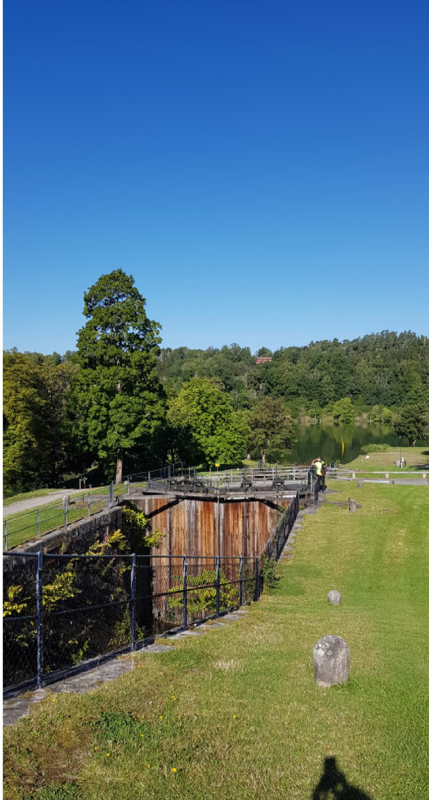
Figur 101 1844 års nedre slusstrappa med vy mot Åkers vass.
