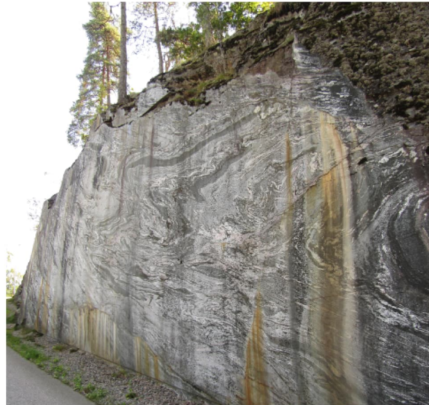
Figur 109 Bergsskärning söder om sluss 3-6 från 1916.
