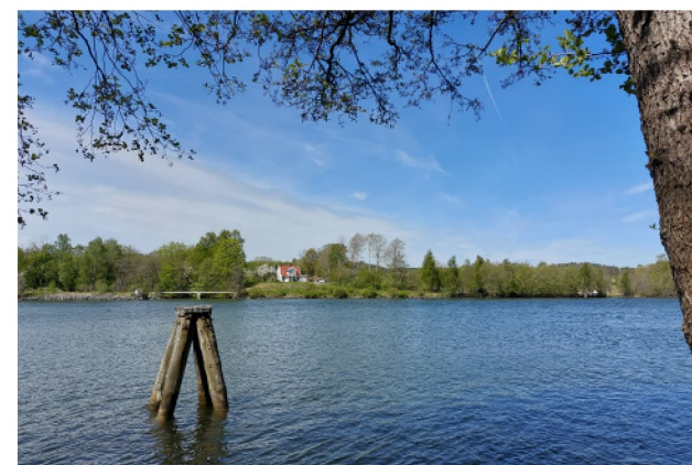
Figur 212 Uppströms slussen, vy över den västra stranden.
