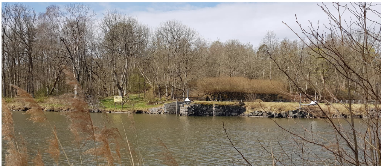
Figur 36 1844 års nedre sluss (Bommens sluss) ligger väster om befintlig sluss.
