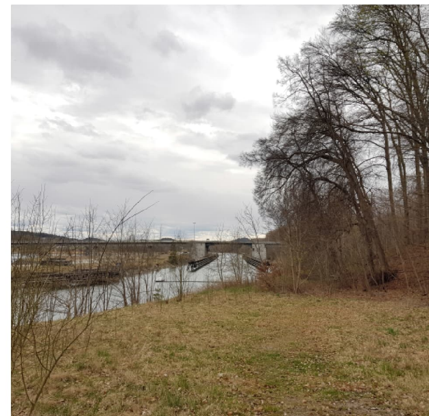
Figur 236 Den södra strandzonen med Lilla Edetbron i fonden.
