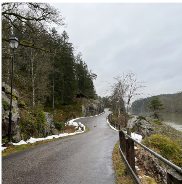
Figur 160 I områdets västra del går en bilväg som leder fram till befintlig sluss där den möter Göta älv. Området till vänster i bild är kraftigt kuperat och bevuxen med tät barrskog.
