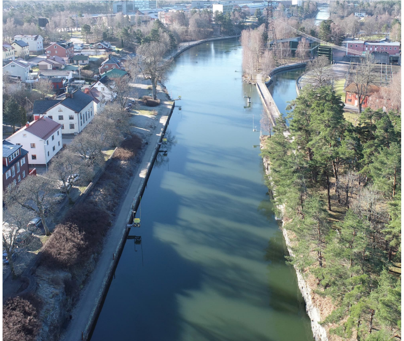
Figur 126 Vy över Bergkanalen. Till vänster i bild syns höjdskillnaden mellan Åkersbergsvägen och promenadvägen vid vattnet. Till höger i bild syns den tallskog som i NVI pekats ut med NV klass 2-3.
