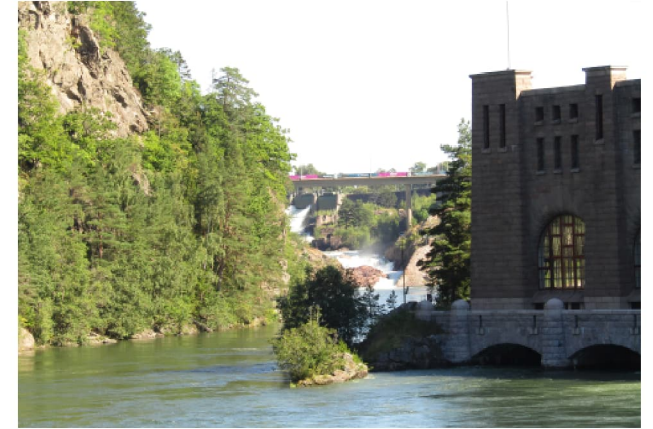
Figur 110 Håjums kraftverksdamm och Oskarsbron längst bak i bild, Stampeströmmen längre fram och allra längst fram till höger syns Olidans kraftstation.
