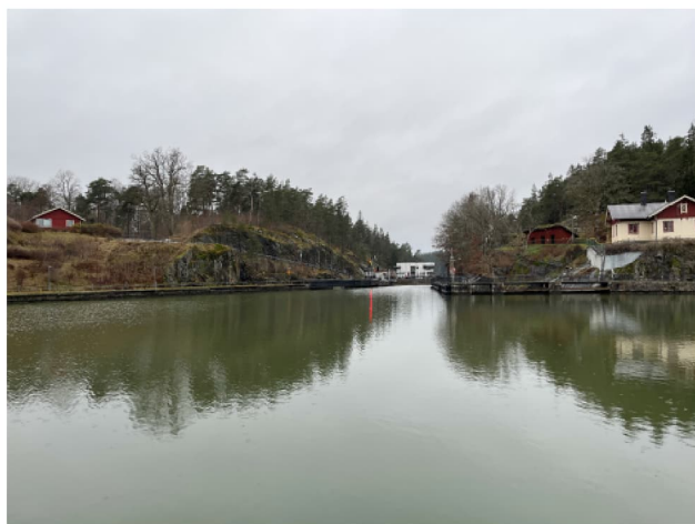
Figur 180 Vy över Höljan mot slussarna nedströms.
