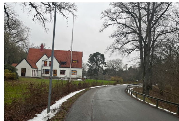
Figur 149 Skogsvreten, en kulturhistoriskt värdefull byggnad som ligger strax norr om Västergärdet, på vägen ner mot Olidans kraftstation.
