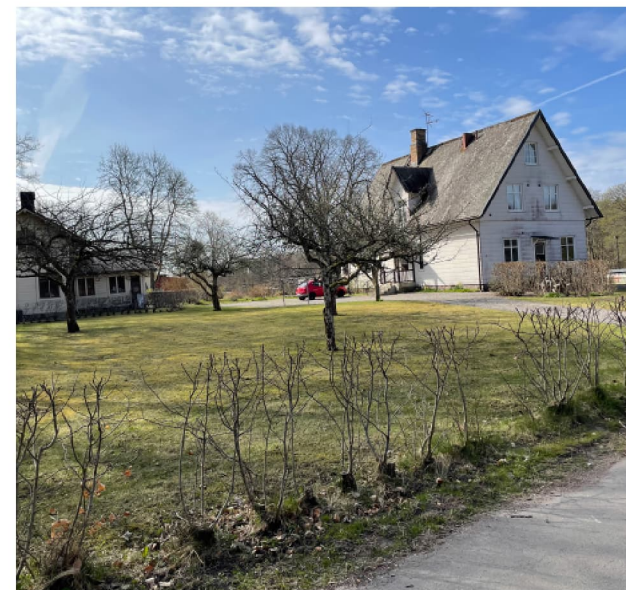
Figur 68 Före detta kanalkontoret med ekonomibyggnad.
