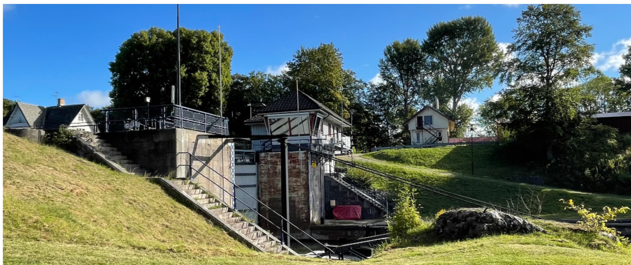
Figur 35 Södra slussporten på 1916 års sluss, flankerad av granittrappor. I bakgrunden syns den moderna manöverbyggnaden och bebyggelse från sent 1800-tal.
