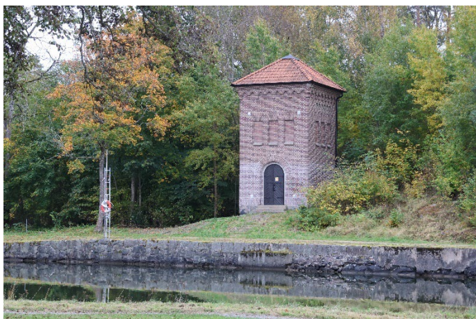
Transformatorstationen intill Bergkanalen.
