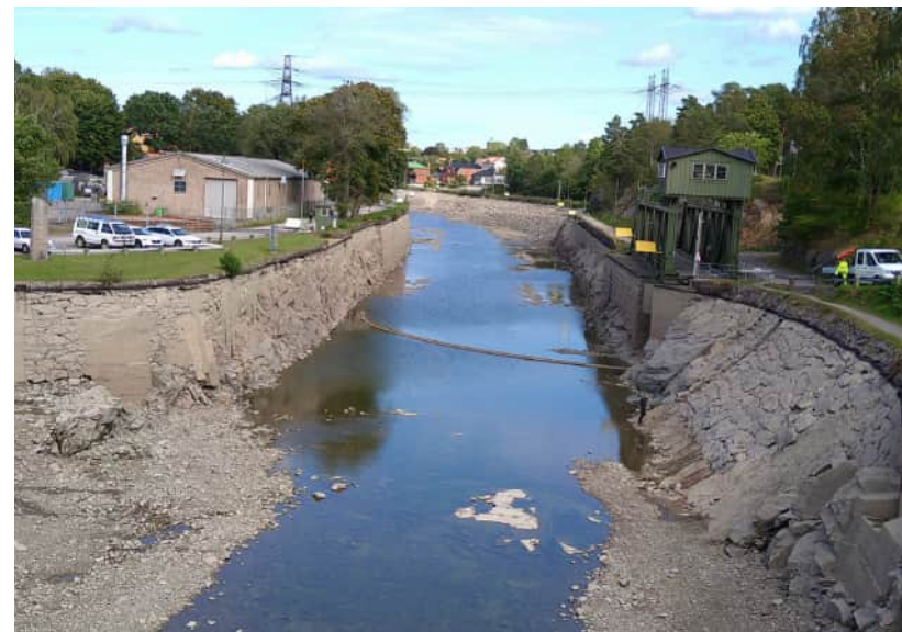
Figur 78. Bergkanalen tillfälligt tömd så att murar och stenskonig syns. T.h. Svängbron från 1915 och i vattnet syns skenan till bron. Över bron kunde tågen nå Nydqvist & Holms verkstäder och Olidans kraftverk.
