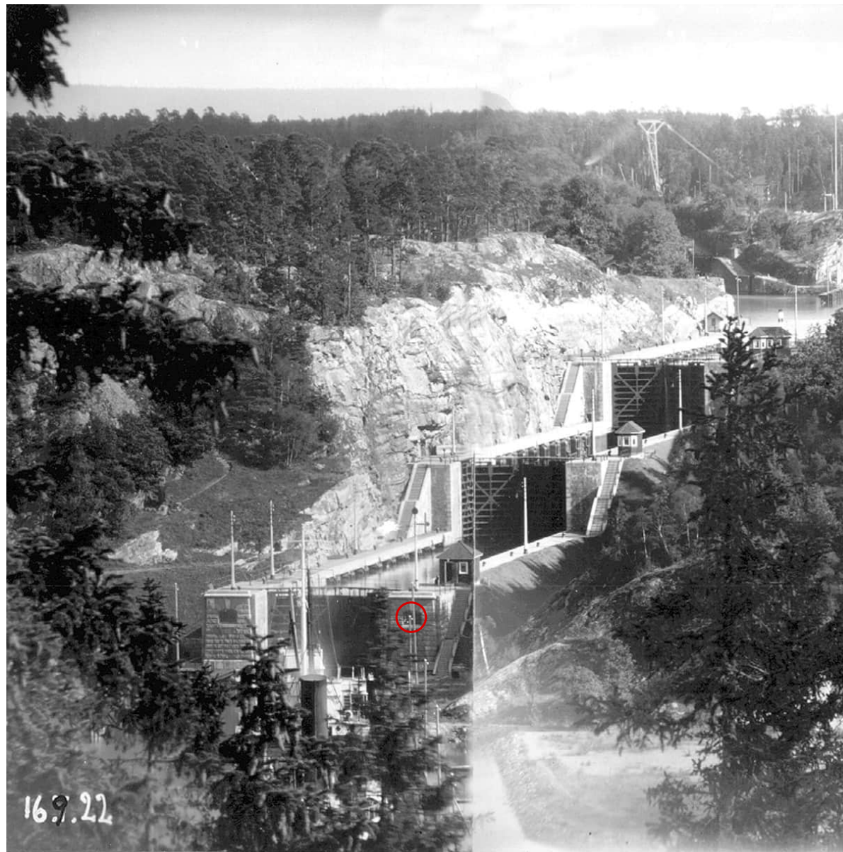
Figur 44. Den mäktiga slussstrappan sedd från Göta Älv, 1922. Vid varje port står en liten spånklädd manöverhytt. En intressant detalj är att det ska finnas en tidskapsel bakom den högra skylten (inringad i rött) vid entrén till slussen. Sjöfartsverket.
