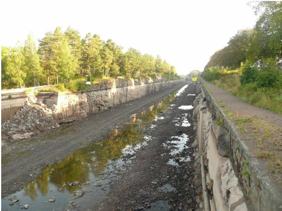
Figur 13. Bergkanalen (tömd på vatten). Foto taget mot norr. På motstående sida syns Kanalön. (Foto: Sjöfartsverket).
