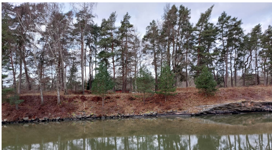
Figur 12. Bergkanalens västra sida. Bilden visar jordslänt på Kanalön. (Foto: WSP)
