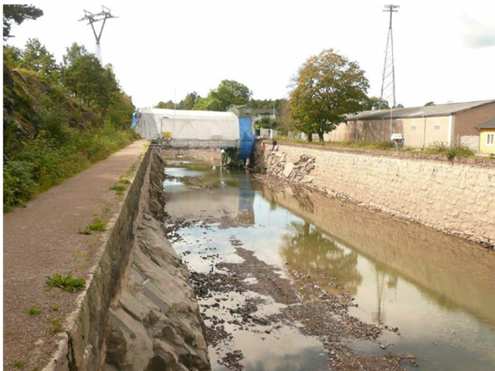
Figur 17. Bergkanalen (tömd på vatten) vid Svängbron. Foto taget mot sydväst. På motstående sida syns kanalmuren längs Kyrkbrovägen. (Foto: Sjöfartsverket)
