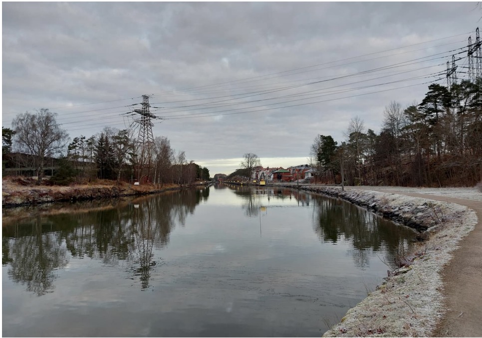
Figur 15. Bergkanalen, strax söder om korsande kraftledningar. Kanalkant med erosionsskyddad jordslänt till höger. Foto taget mot norr. (Foto: WSP)
