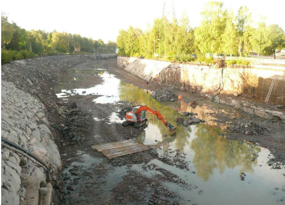
Figur 16. Bergkanalen (tömd på vatten), strax norr om korsande kraftledningar. Foto taget mot sydväst, ungefärligen från korsningen Bergsgatan/Österlånggatan. På motstående sida syns kanalkant av berg samt glacismur. Till vänster kanalkant som utgörs av jordslänt. (Foto: Sjöfartsverket)
