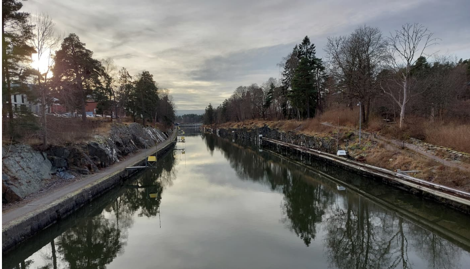
Figur 20. Bergkanalen söder om Olidebron. Foto taget mot söder. (Foto: WSP)
