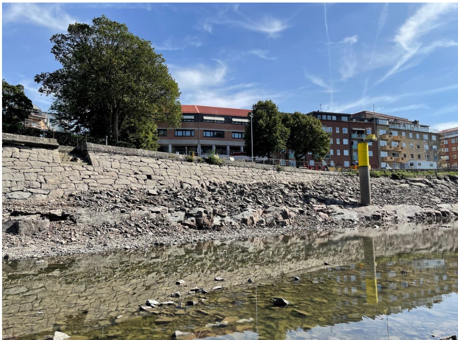
Figur 10. Bergkanalen (tömd på vatten) vid Karl Johans torg. Berg i dagen syns strax ovanför kanalbotten. (Foto: Sjöfartsverket)
