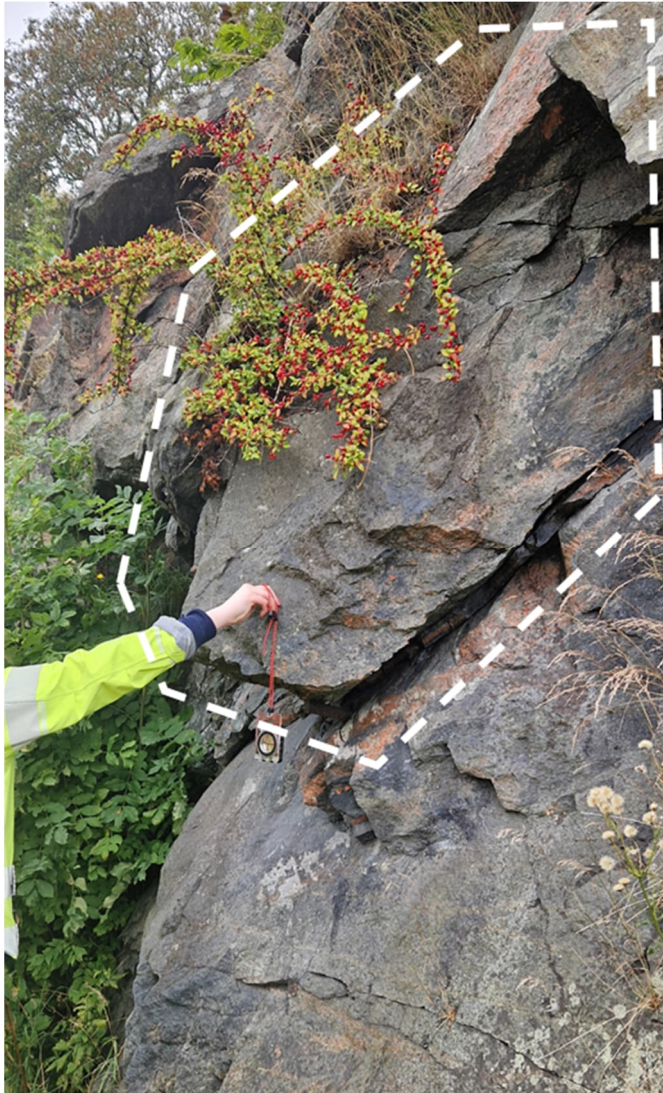
Figur 9. Block 3, markerat med vit streckad linje, utgörs av ett parti med cirka sex potentiellt instabila block.
