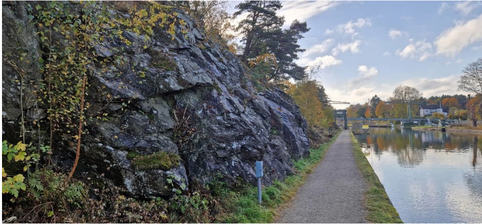
Figur 28. Slänt intill dragvägen som går längs Bergkanalens östra sida.
