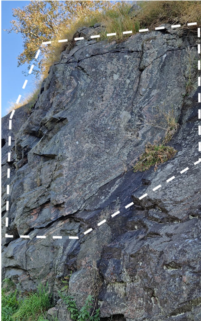
Figur 15. Block 9, markerat med vit streckad linje, är uppskattningsvis cirka 6 \text{ m}^3 stort.
