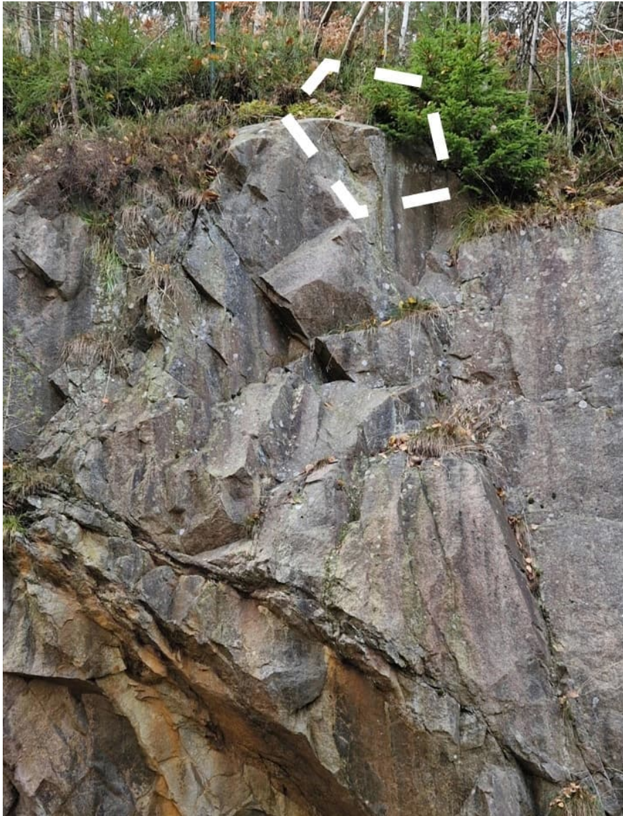
Figur 27. Block 19, markerat med vit streckad linje, är cirka 0,4 m 3 stort.
