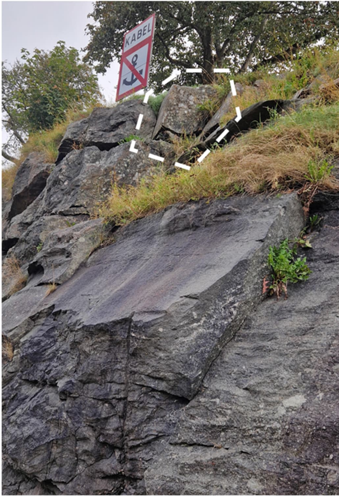
Figur 12. Block 6, markerat med vit streckad linje, är cirka 1,5 \text{ m}^3 stort.
