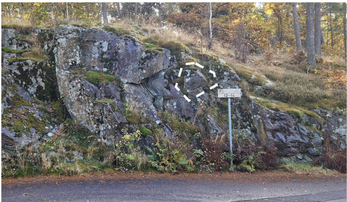
Figur 34. Block 26, markerat med vit streckad linje, är cirka 0,6x0,6x0,6 m stort.
