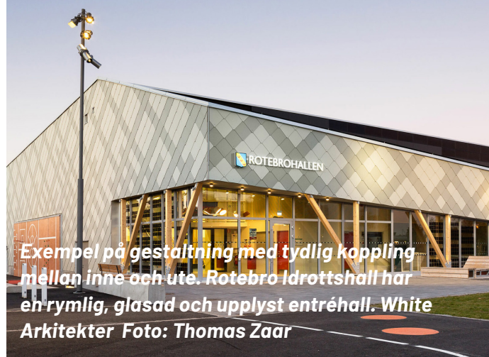
Exempel möte med mark. Panel neddragen över sockeln.
