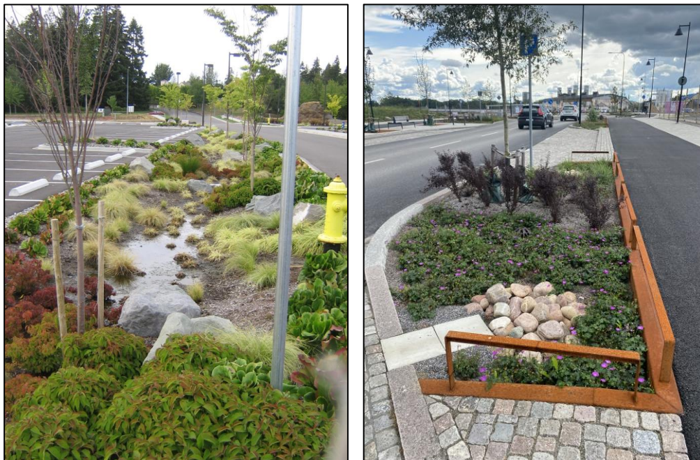
Figur 18. Exempelbilder på regnbäddar. Foto: NIRAS
