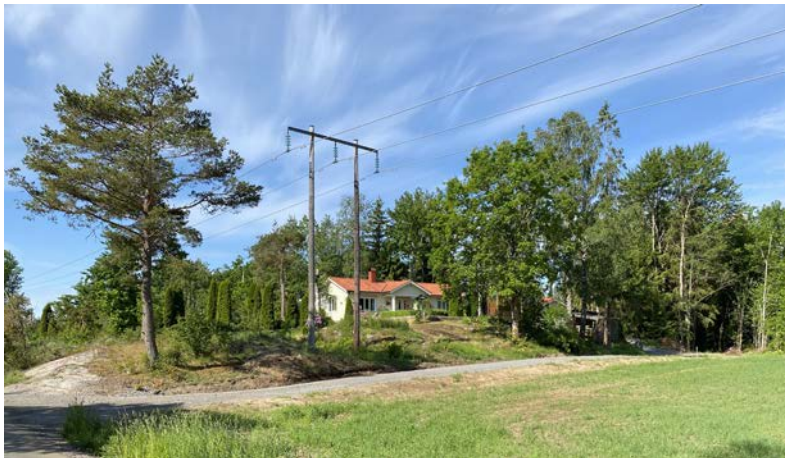
Figur 21. Kraftledningens sträckning genom del av planområdet. Bild tagen i juni 2020 av samhällsbyggnadsförvaltningen.
