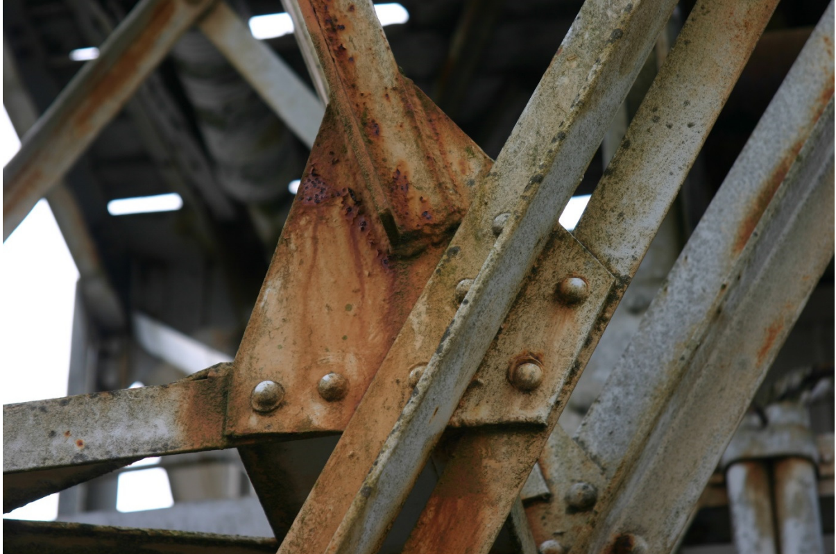
Exempel på rostskador i nitförband och svetsfogar.
