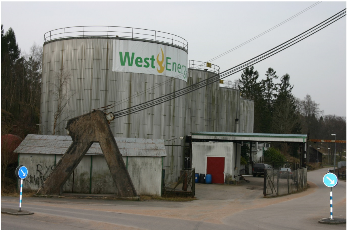
Den gigantiska motvikten var en förutsättning för att kranen skulle kunna lyfta 80 ton i kroken. Den utgör en väsentlig del i förståelsen för hur rysskranen fungerar.
