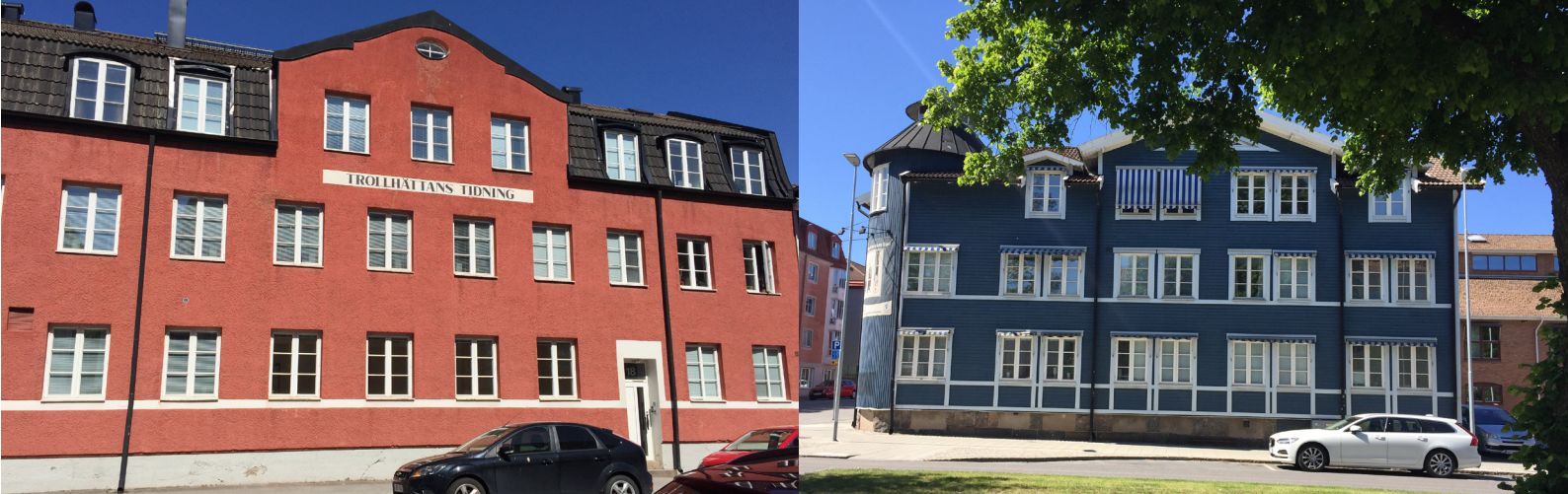
Byggnader inom Rödjan 5
